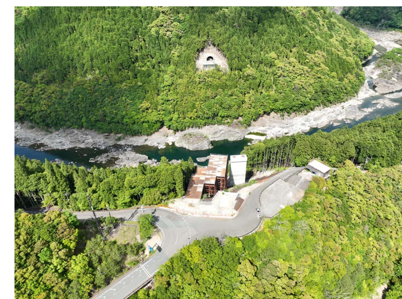
⑧ 北山村小松(2号トンネル・3号橋AA2橋脚・A2橋台)
