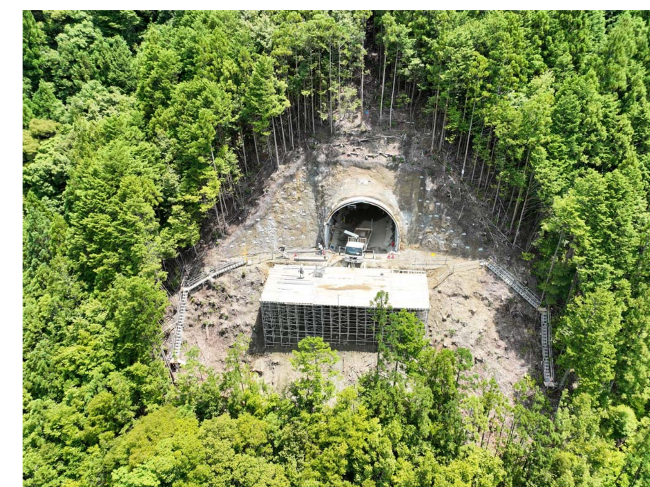
⑧ 北山村小松(2号トンネル・3号橋)
