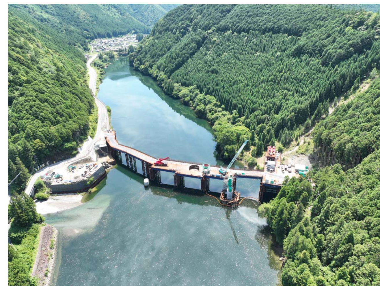
② 北山村下尾井(道路改良・1号橋)
