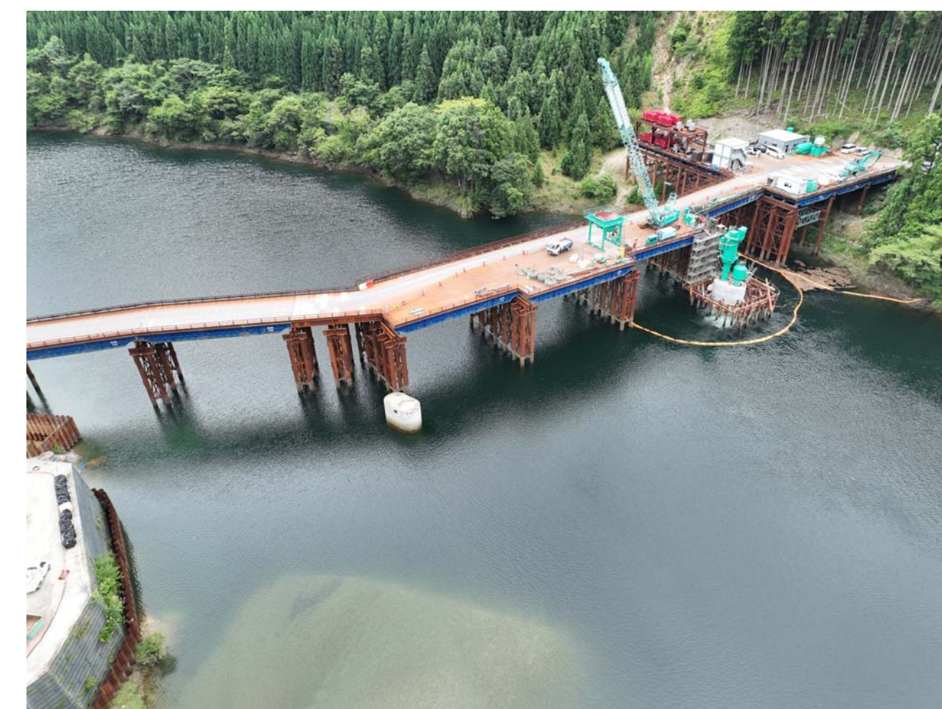
④ 北山村下尾井(1号橋)
