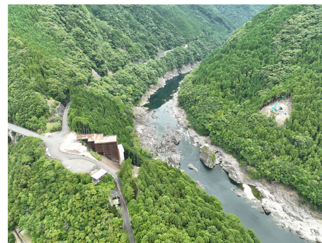
⑦ 北山村小松(2号トンネル・3号橋)
