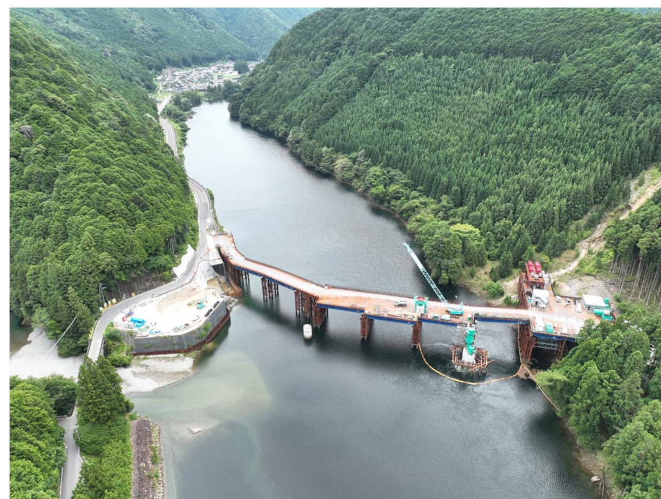
② 北山村下尾井(道路改良・1号橋)
