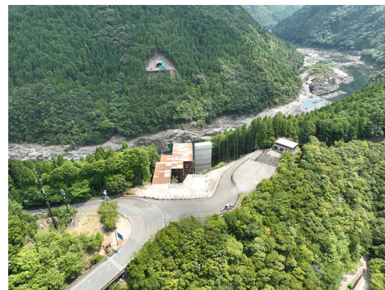
⑦ 北山村小松(2号トンネル・3号橋)
