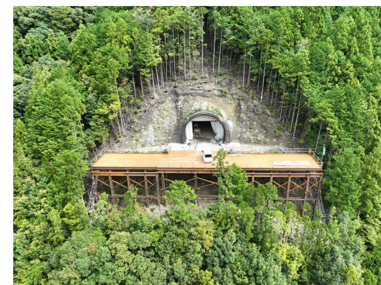
⑧ 北山村小松(2号トンネル・3号橋)
