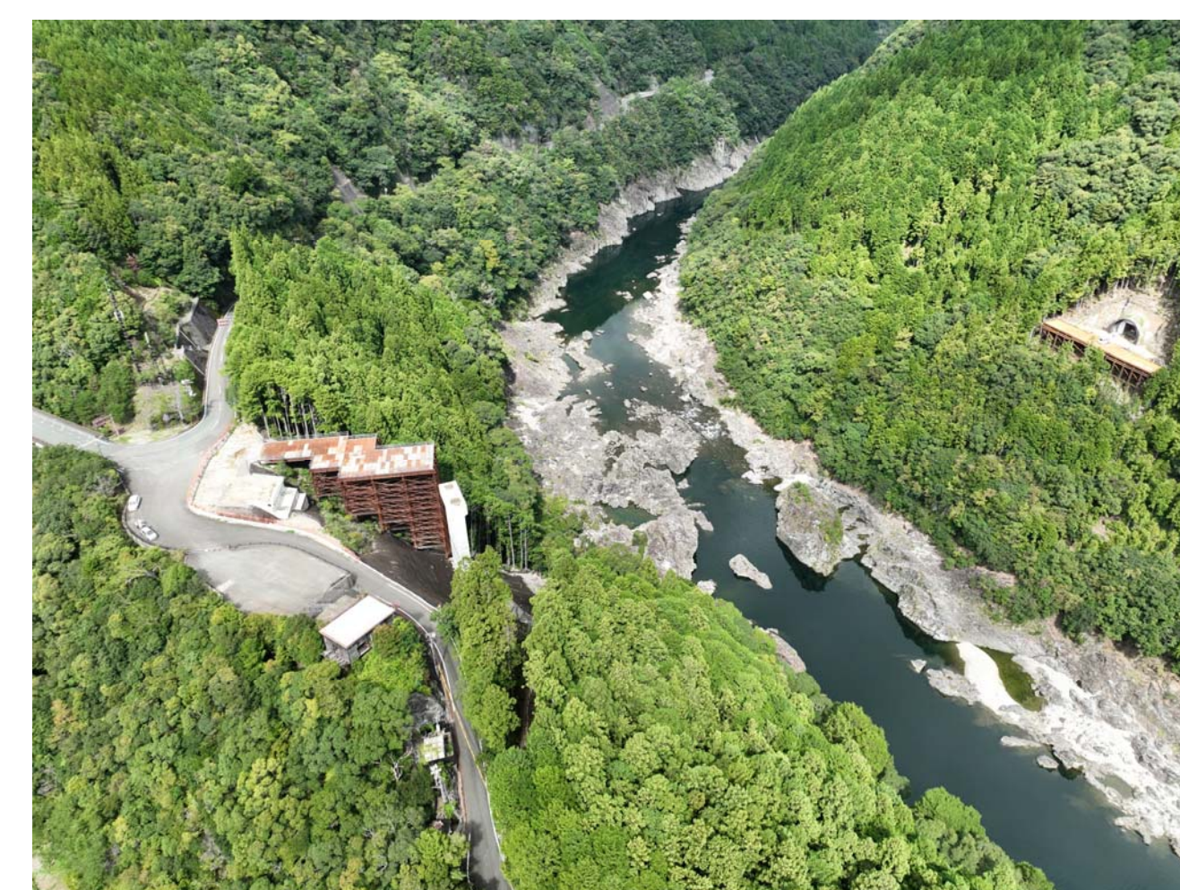
⑦ 北山村小松(2号トンネル・3号橋)
