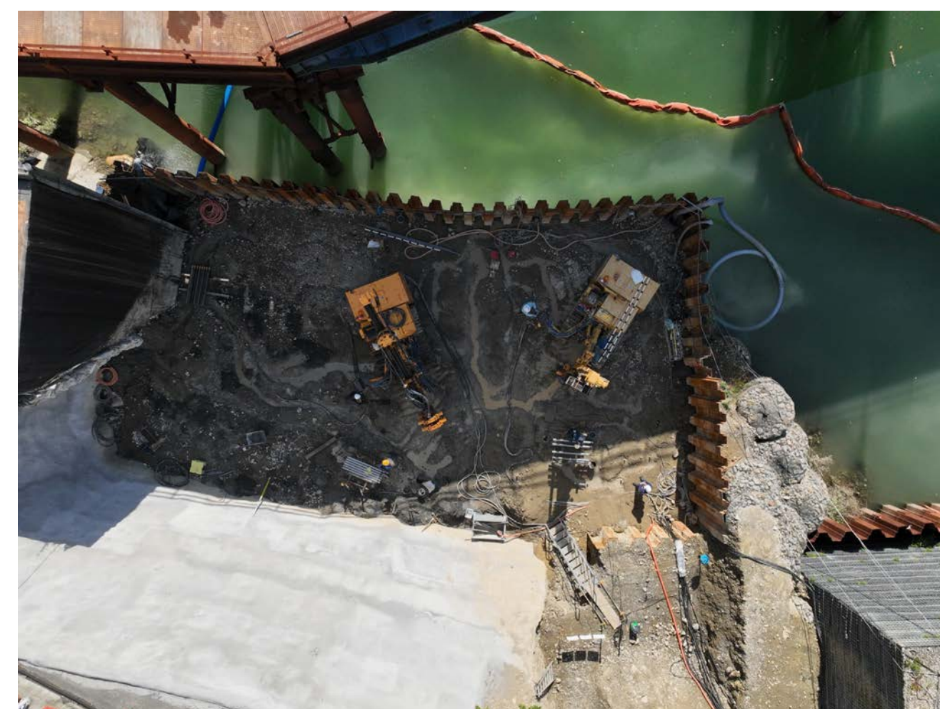
② 北山村下尾井(道路改良・1号橋)
