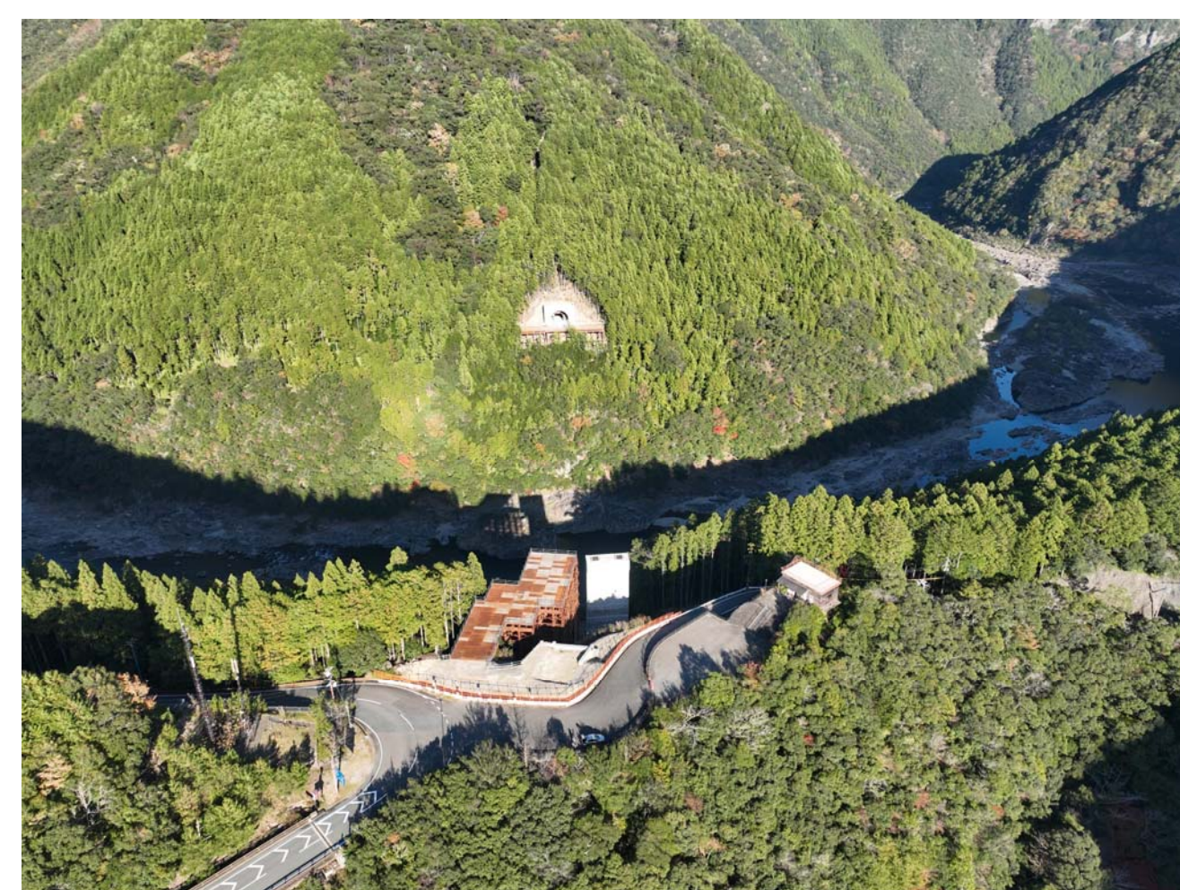
⑦ 北山村小松(2号トンネル・3号橋)
