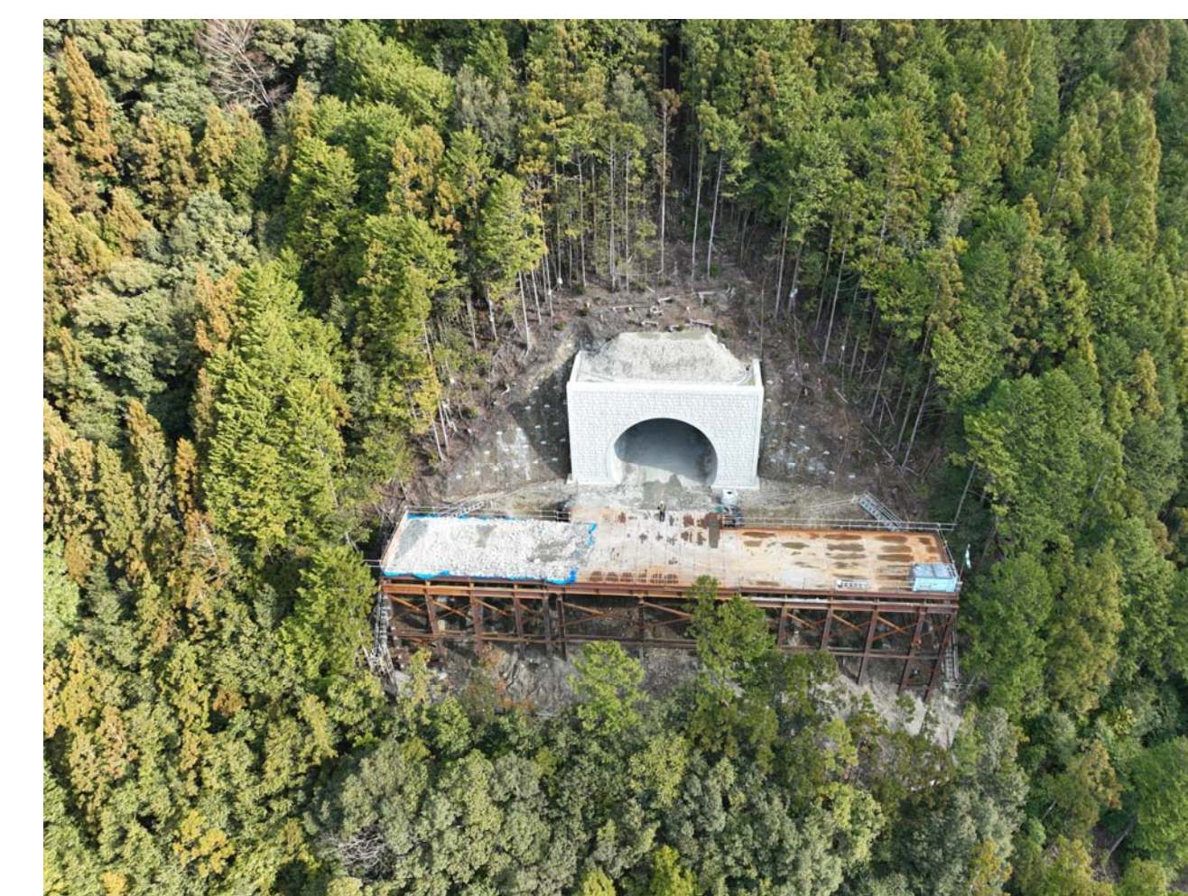
⑧ 北山村小松(2号トンネル・3号橋)
