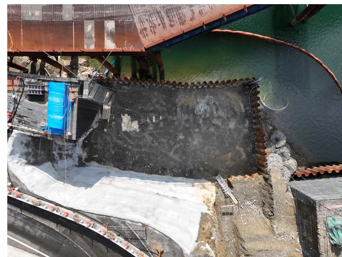
② 北山村下尾井(道路改良・1号橋)
