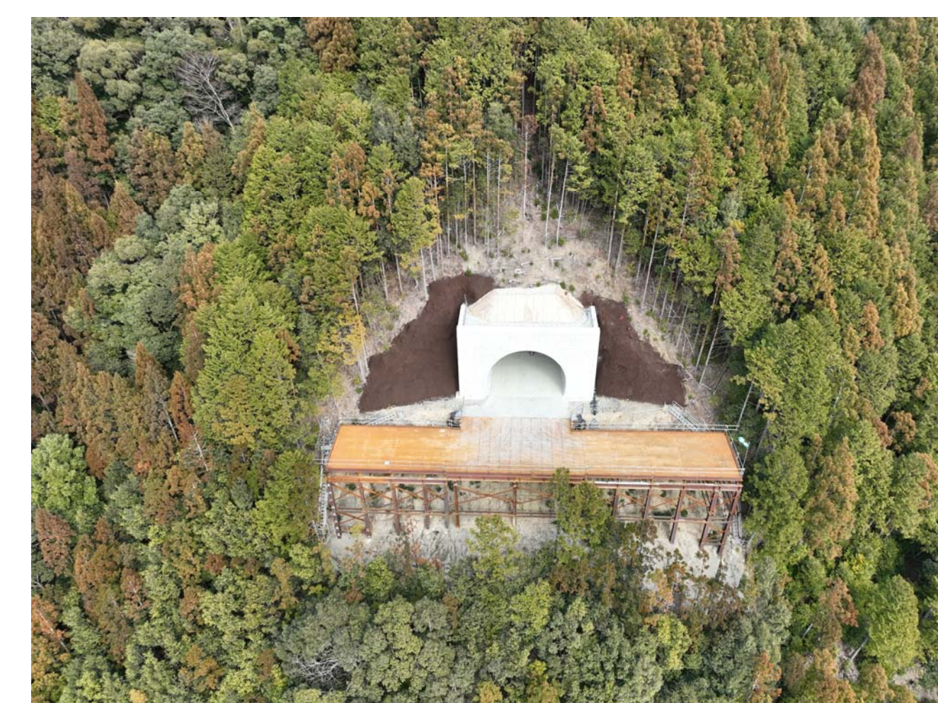
⑧ 北山村小松(2号トンネル・3号橋)
