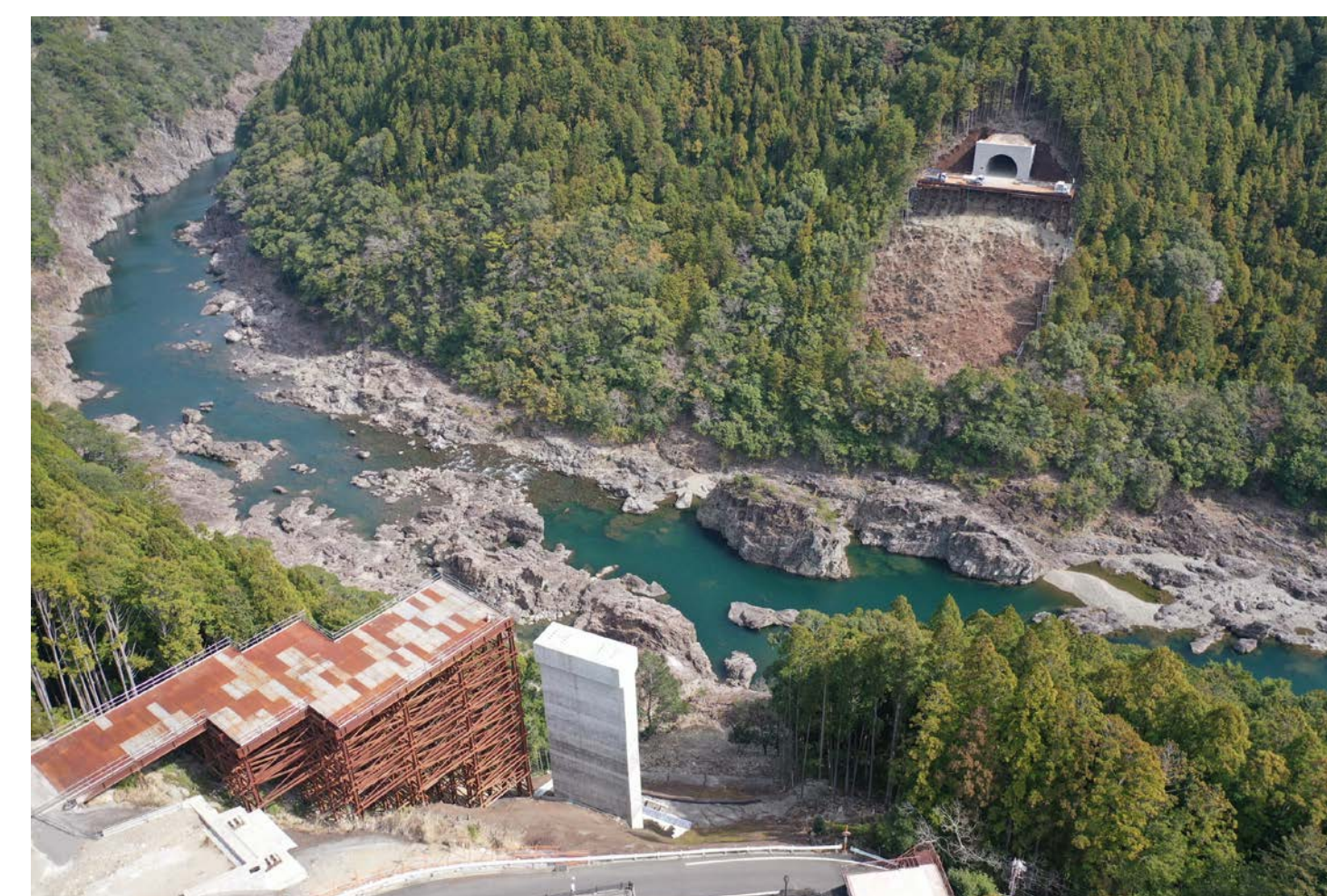
⑦ 北山村小松(2号トンネル・3号橋)
