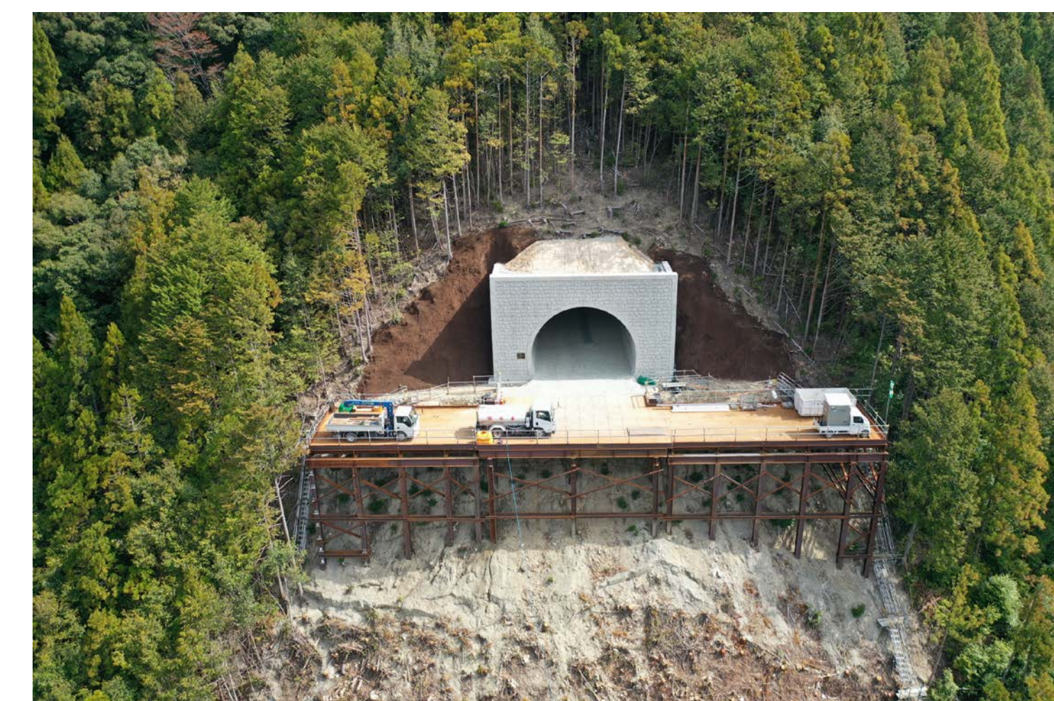
⑧ 北山村小松(2号トンネル・3号橋)
