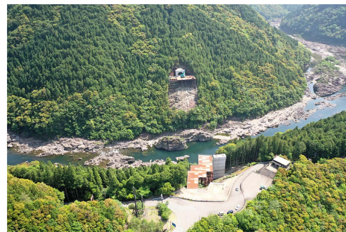
⑦ 北山村小松(2号トンネル・3号橋)
