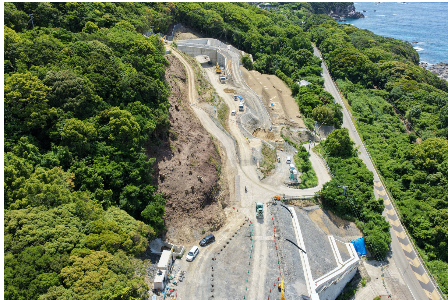
②すさみ町里野(道路改良)
