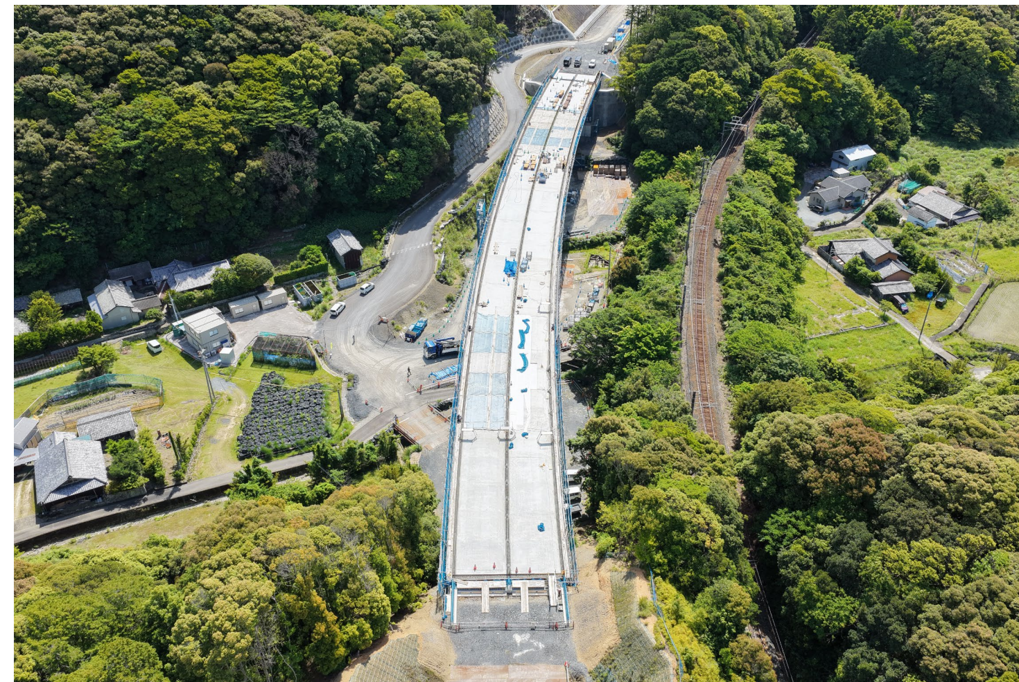
③すさみ町里野(小河瀬谷川橋)
