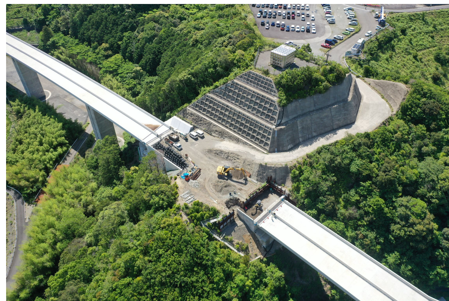
⑦串本町サンゴ台(道路改良)
