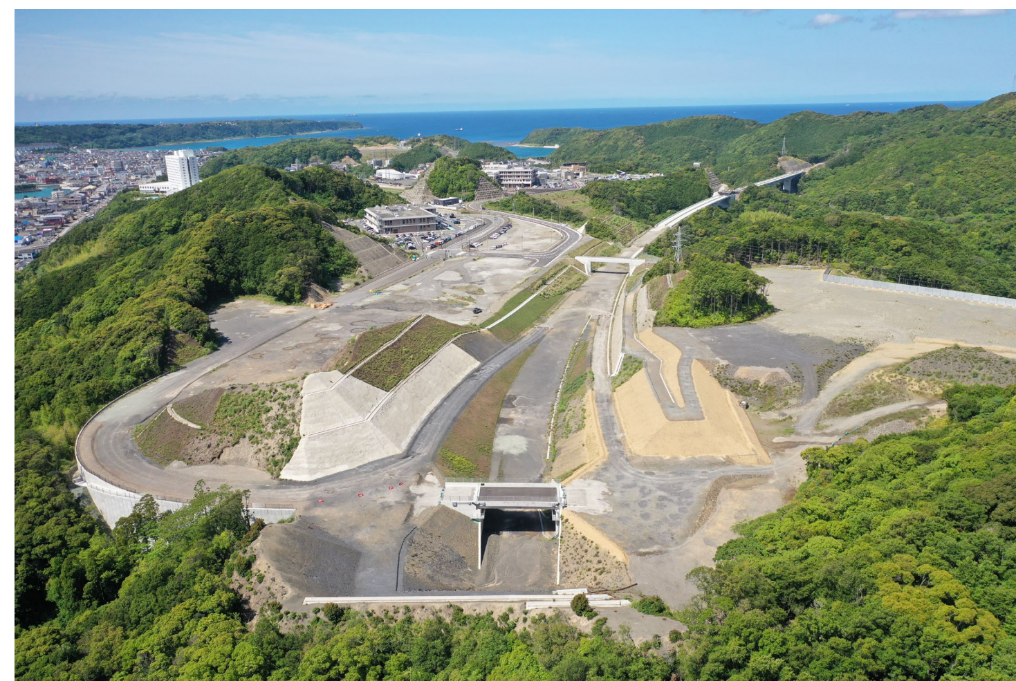
⑧串本IC仮称 (道路改良)
