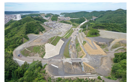
⑧串本IC仮称(道路改良)
