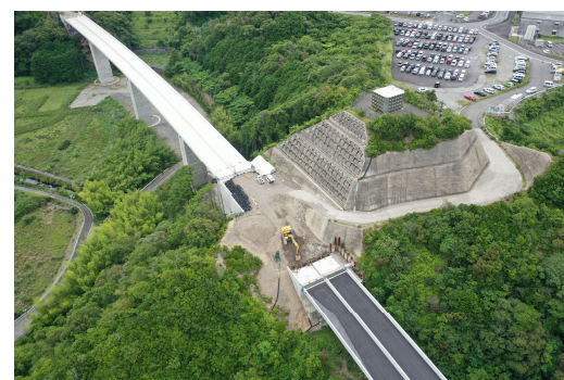
⑦串本町サンゴ台(道路改良)
