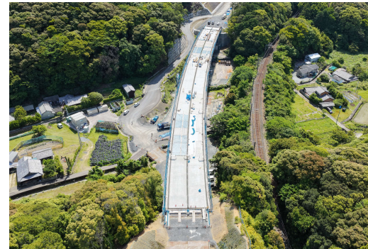
③すさみ町里野(小河瀬谷川橋)
