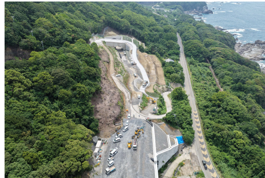
②すさみ町里野(道路改良)
