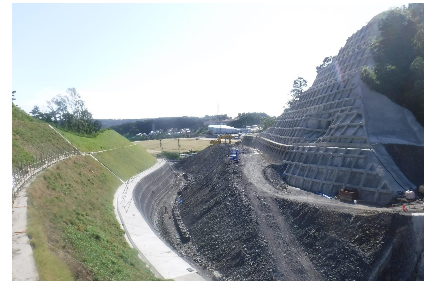
⑧ ICアクセス改良工事
