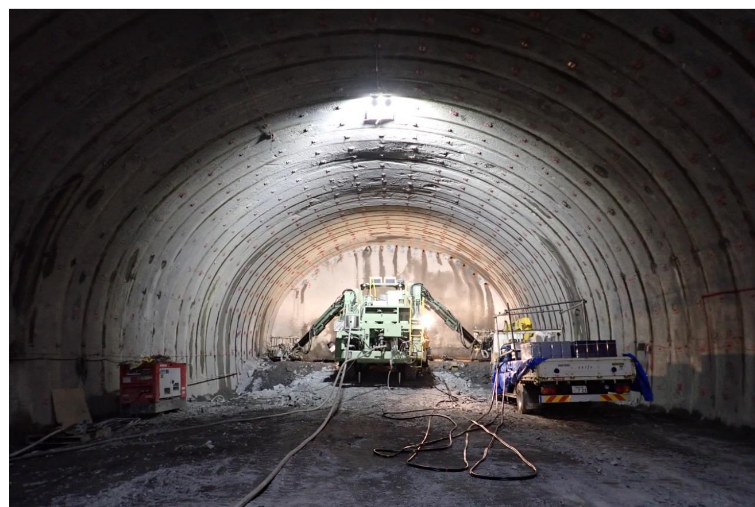
② 里野トンネル他工事
