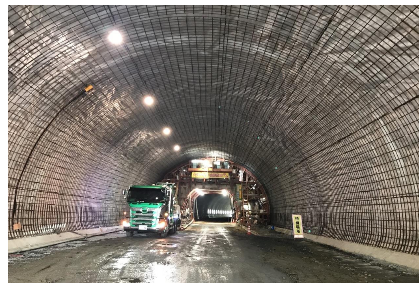
③ 雨嶋トンネル工事
