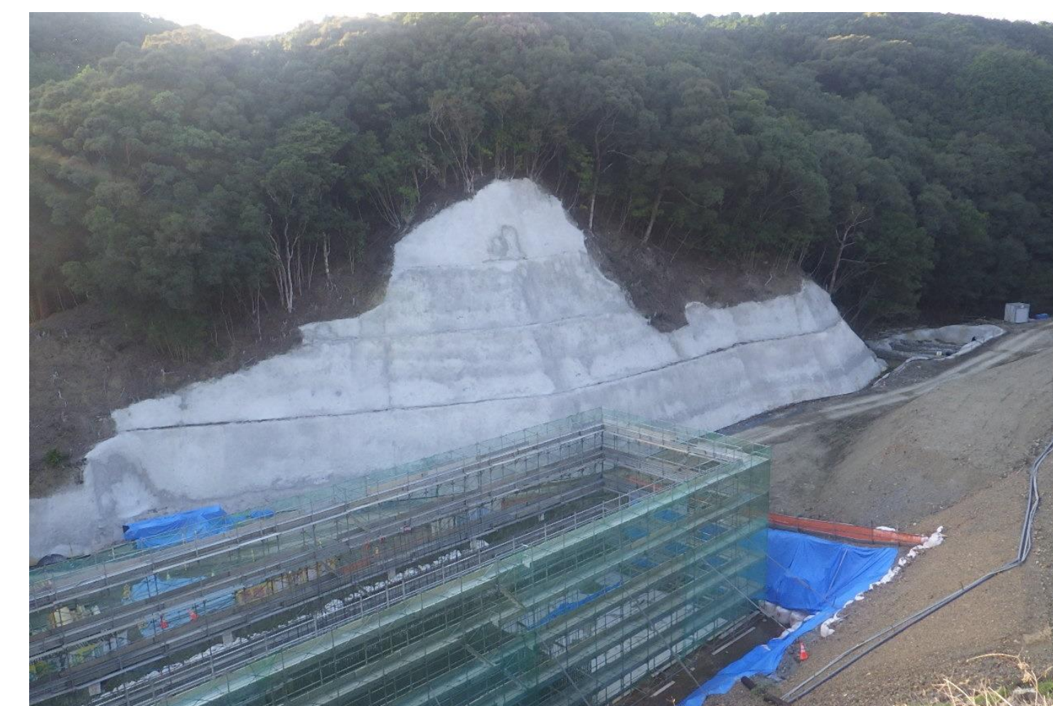
④ 田子トンネル他工事
