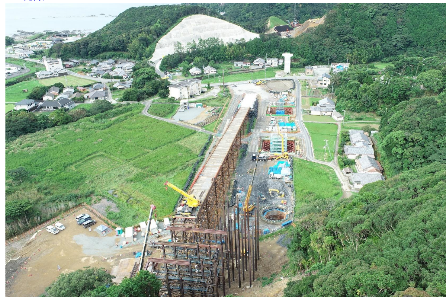
⑥ 高富川橋下部工事
