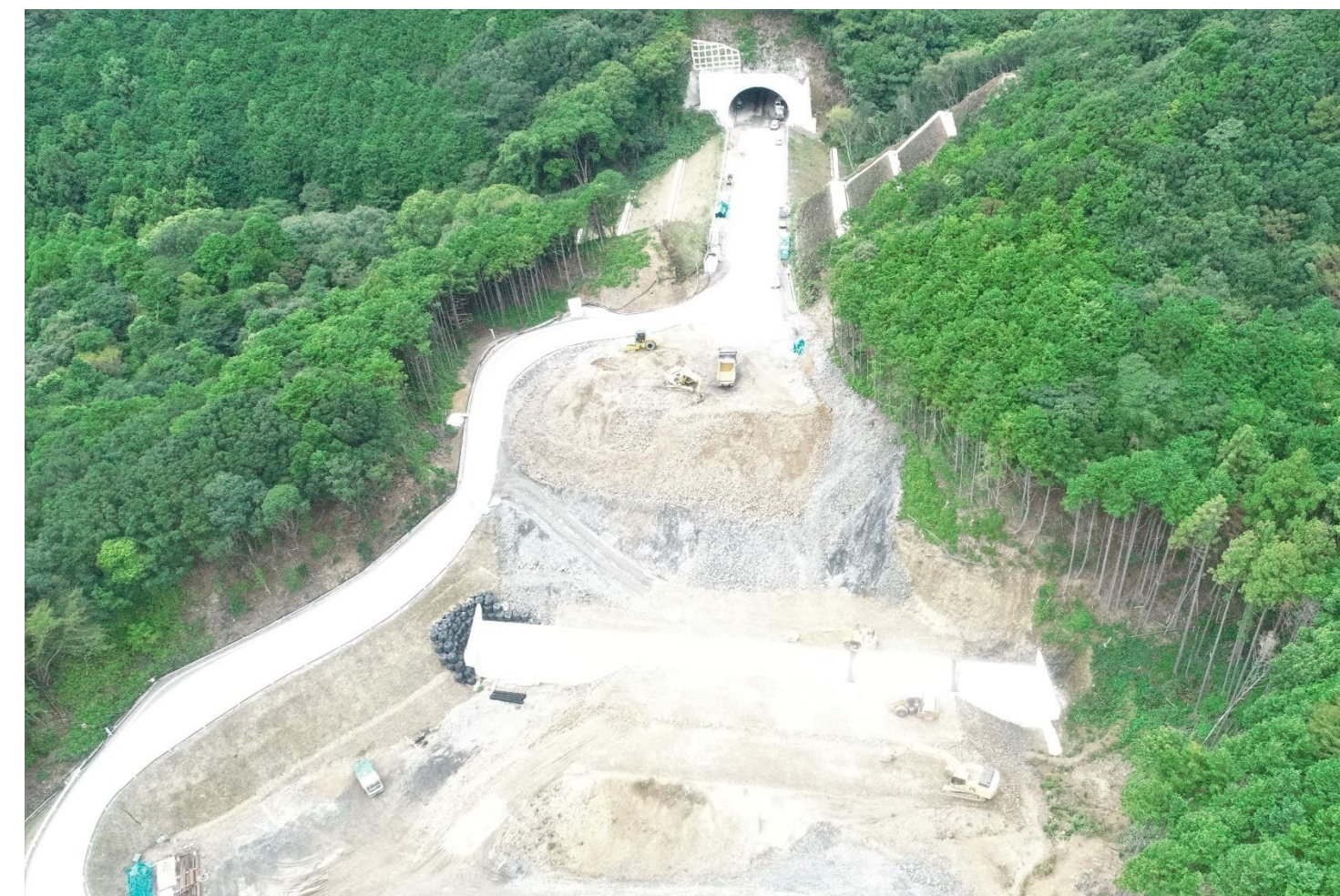
⑦ 二色トンネル工事
