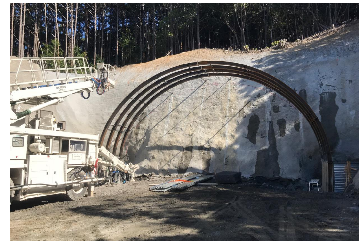
④ 田子トンネル他工事
