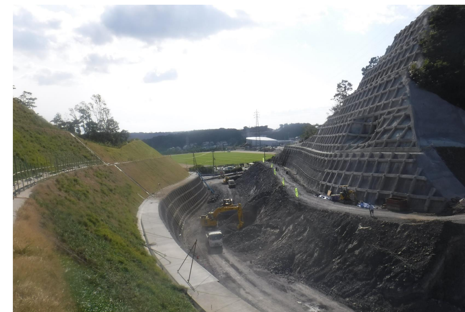
⑧ ICアクセス改良工事
