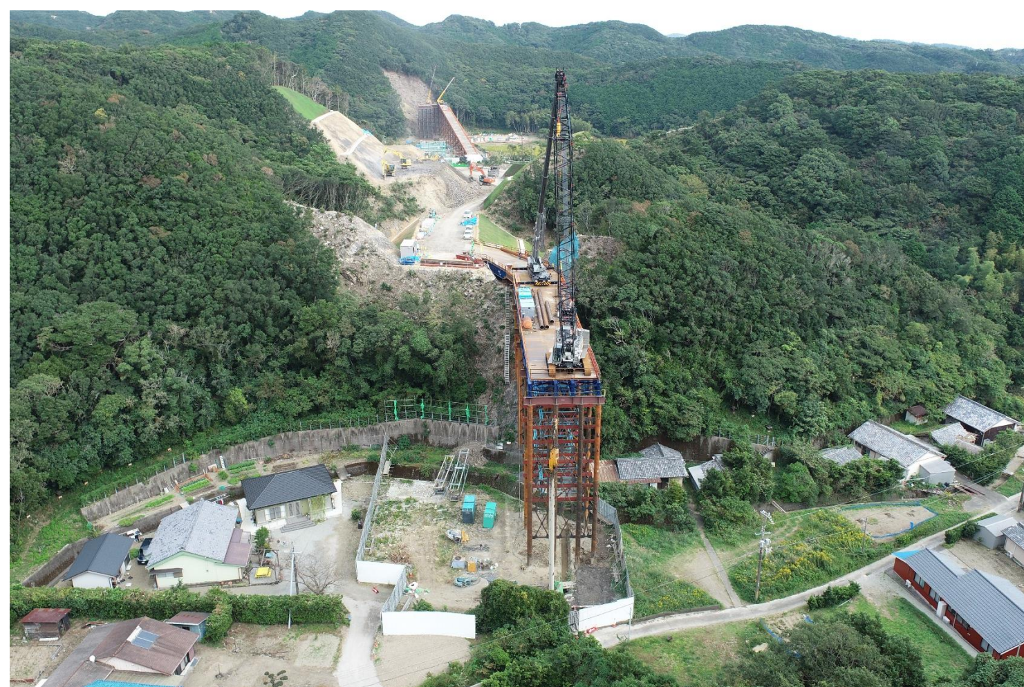
⑤ 釜郷原川橋進入路工事
