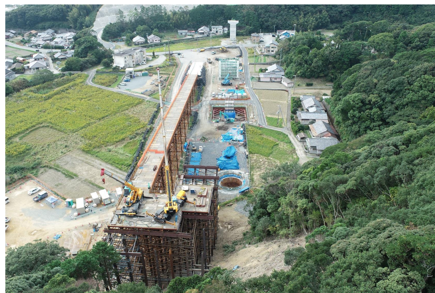
⑥ 高富川橋下部工事
