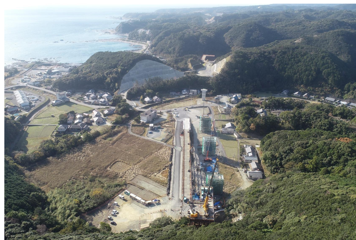
⑥ 高富川橋下部工事
