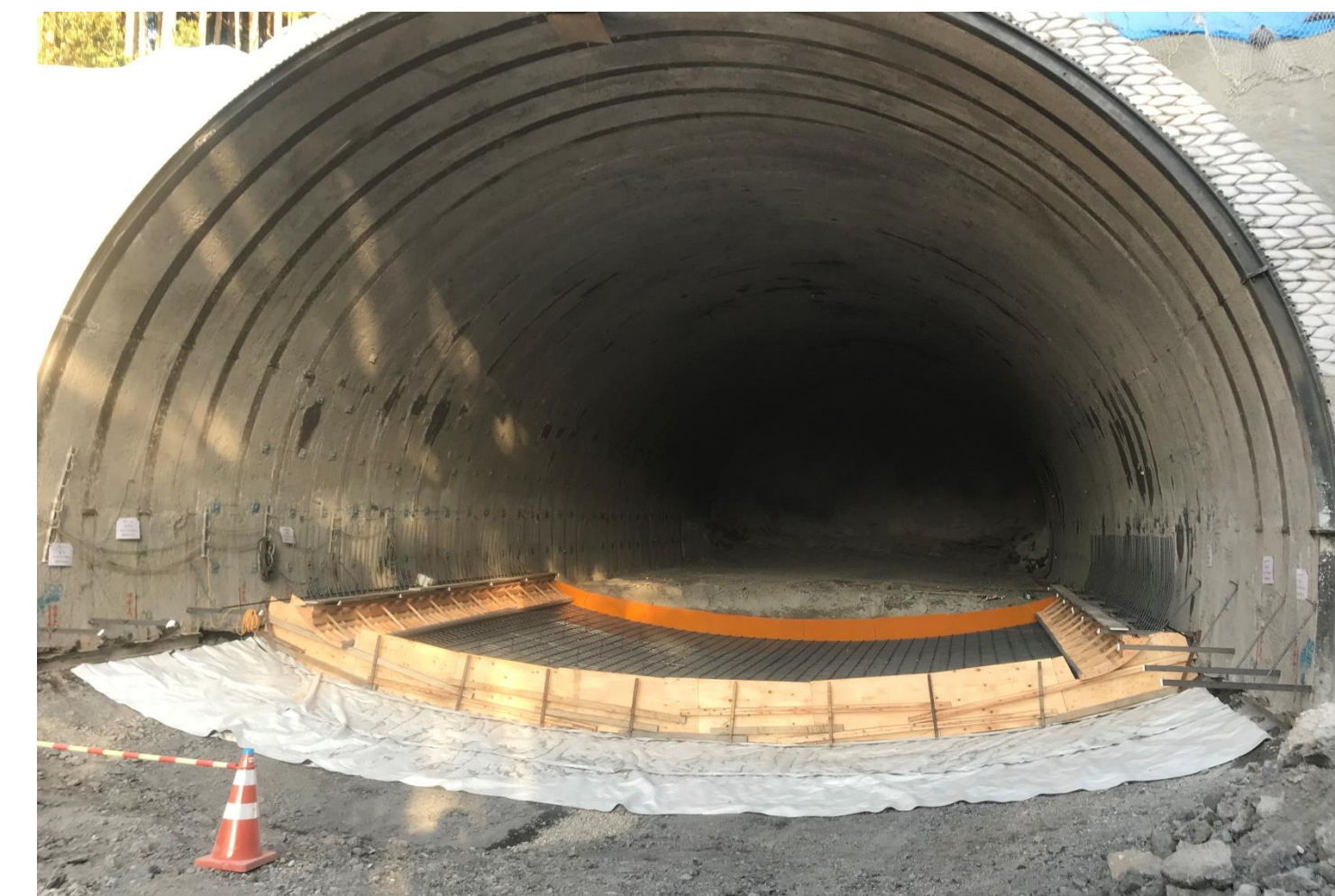
④ 田子トンネル他工事
