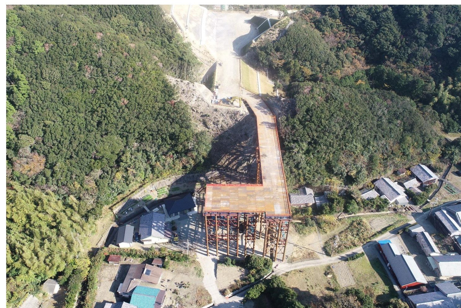
⑤ 釜郷原川橋進入路工事
