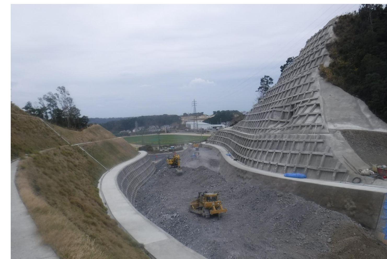
⑧ ICアクセス改良工事
