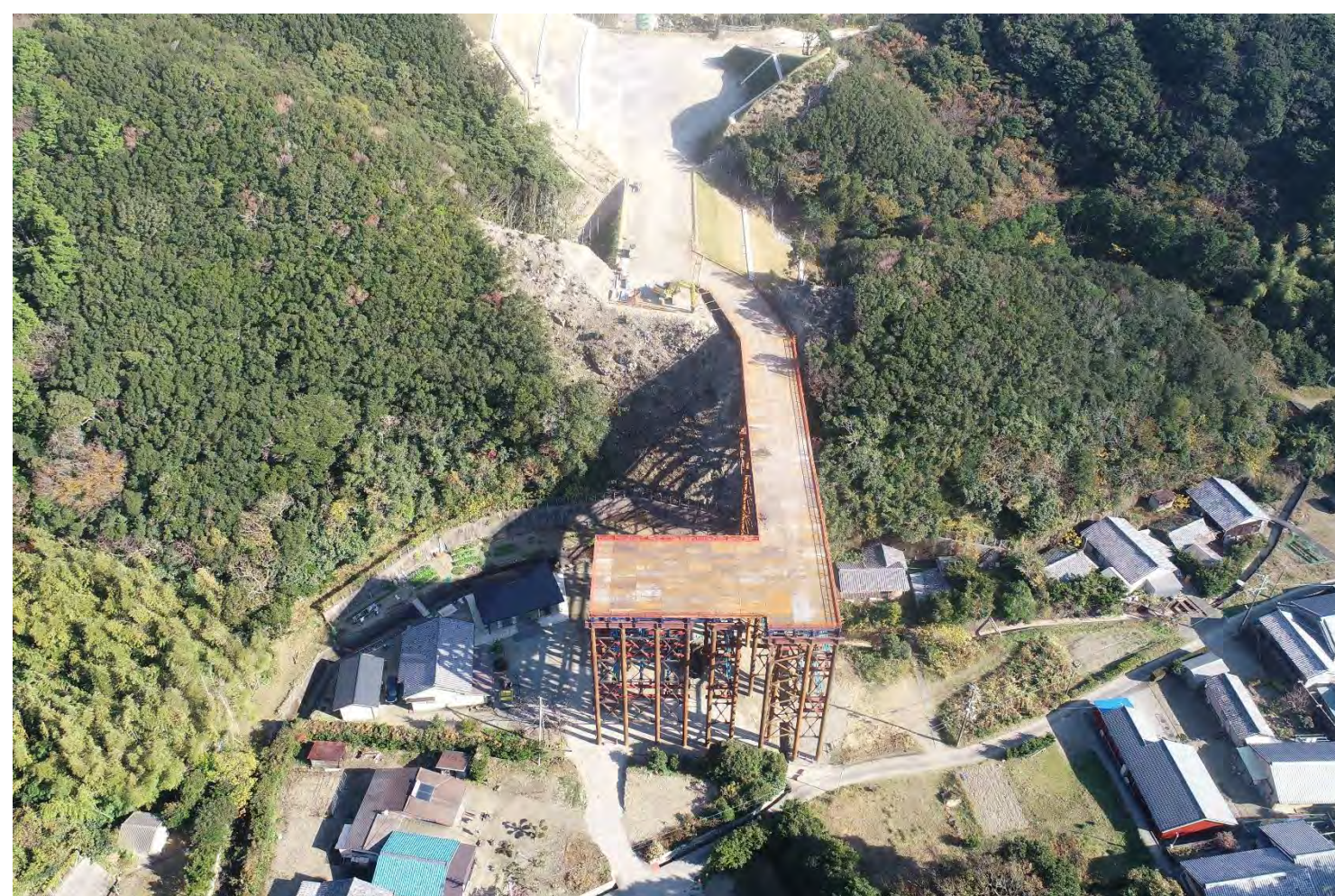
⑤ 釜郷原川橋進入路工事
