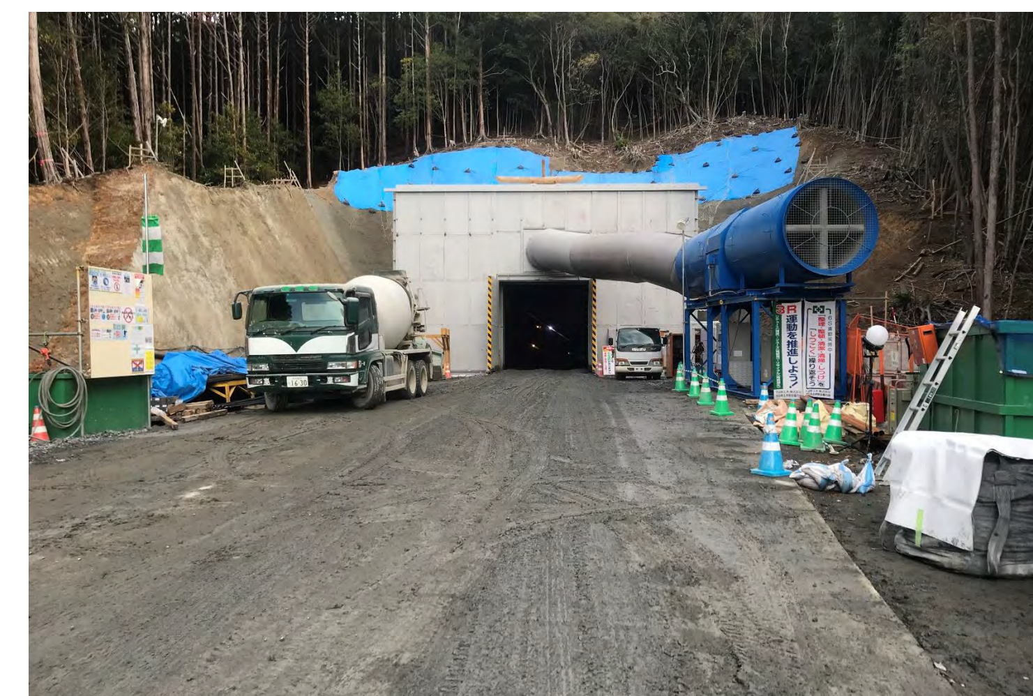
④ 田子トンネル他工事
