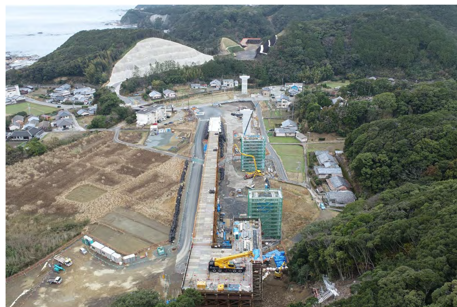
⑥ 高富川橋下部工事
