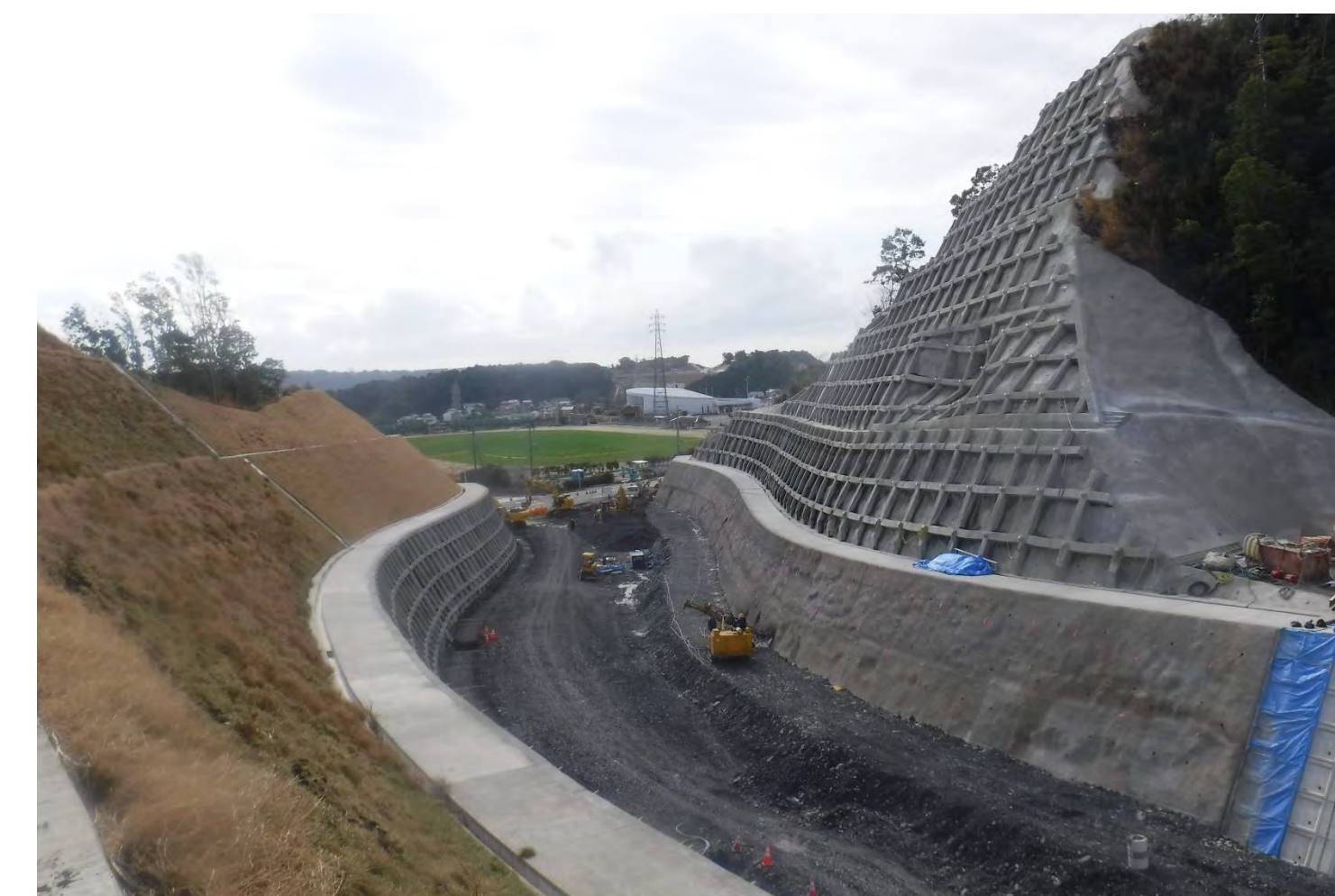
⑧ ICアクセス改良工事
