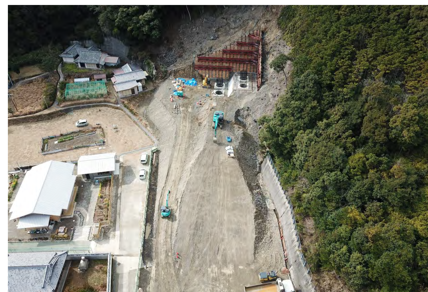
③ 和深川橋A1下部工事
