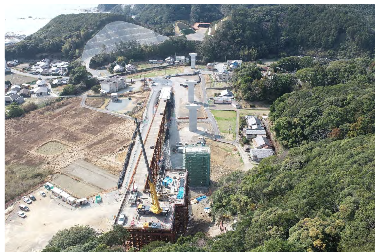
⑥ 高富川橋下部工事
