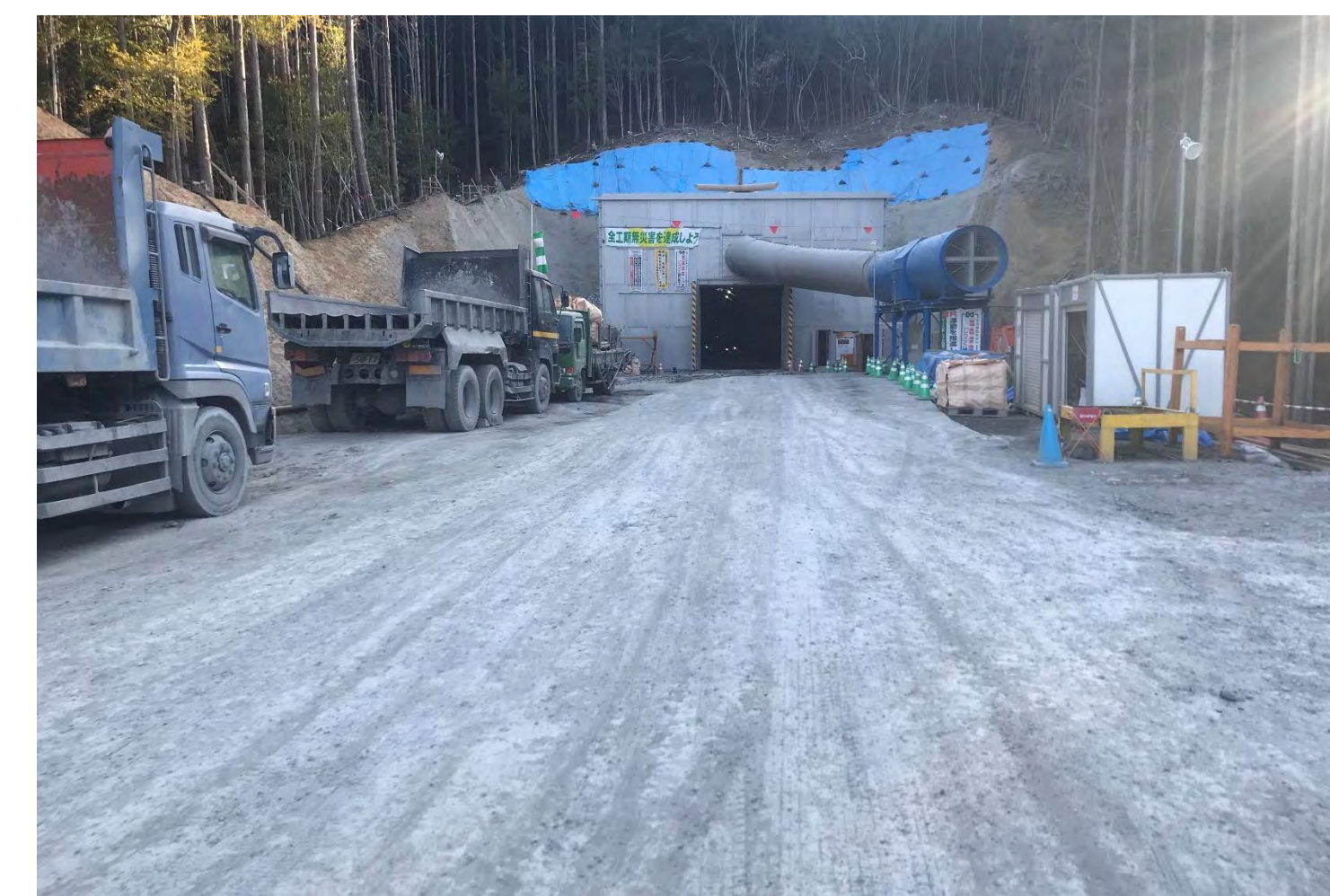
④ 田子トンネル他工事
