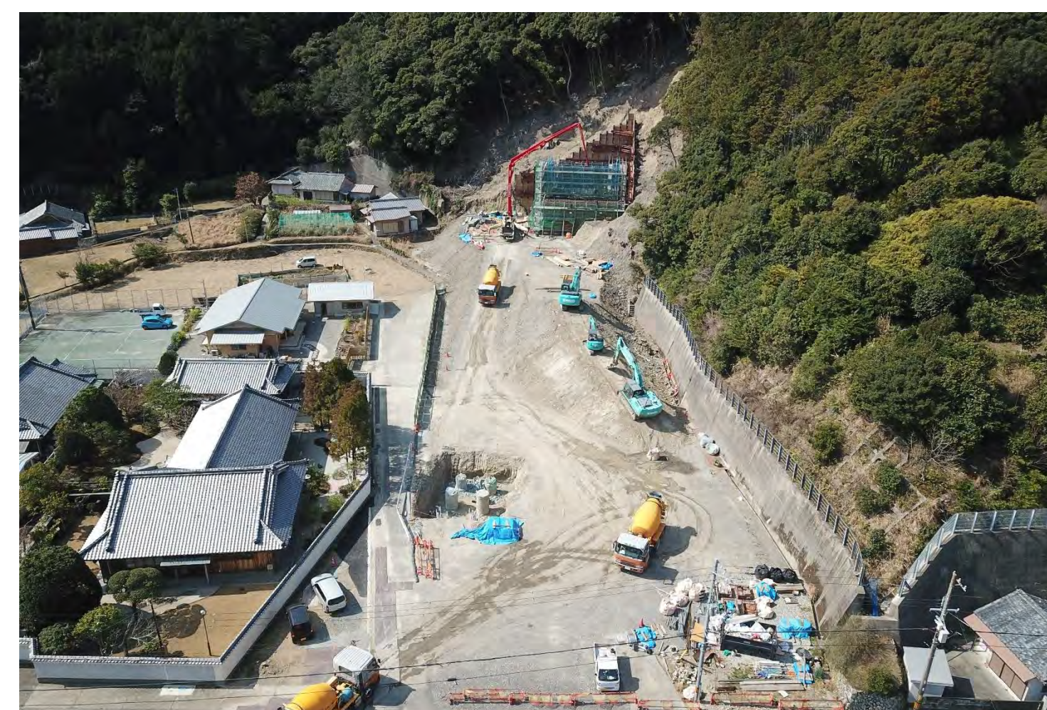
③ 和深川橋A1下部工事
