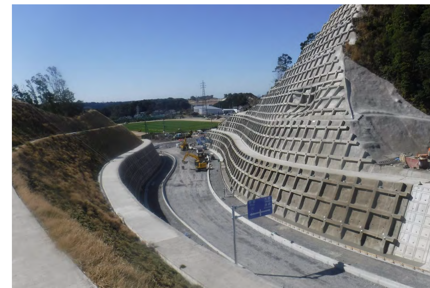
⑧ ICアクセス改良工事
