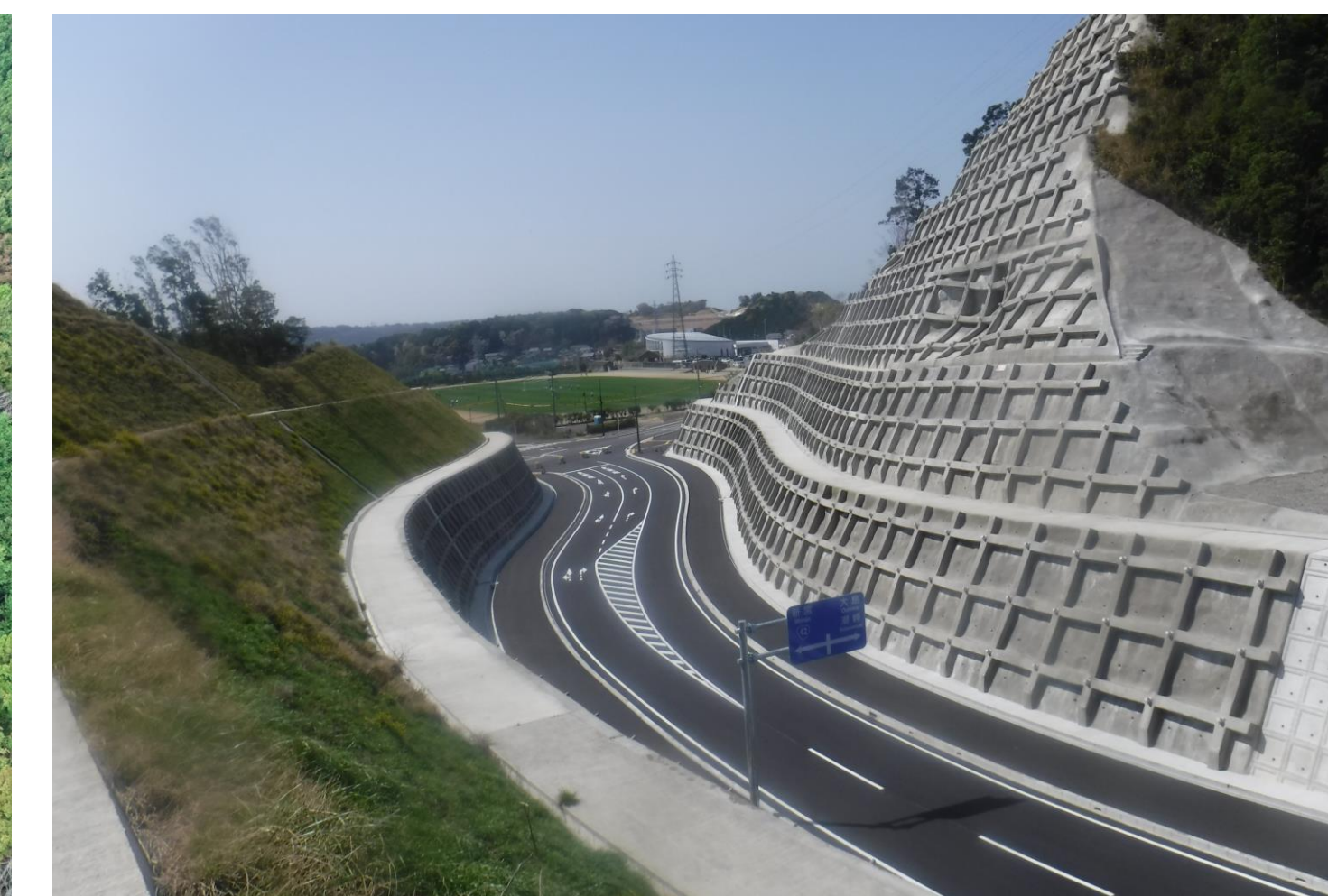
⑧ ICアクセス改良工事
