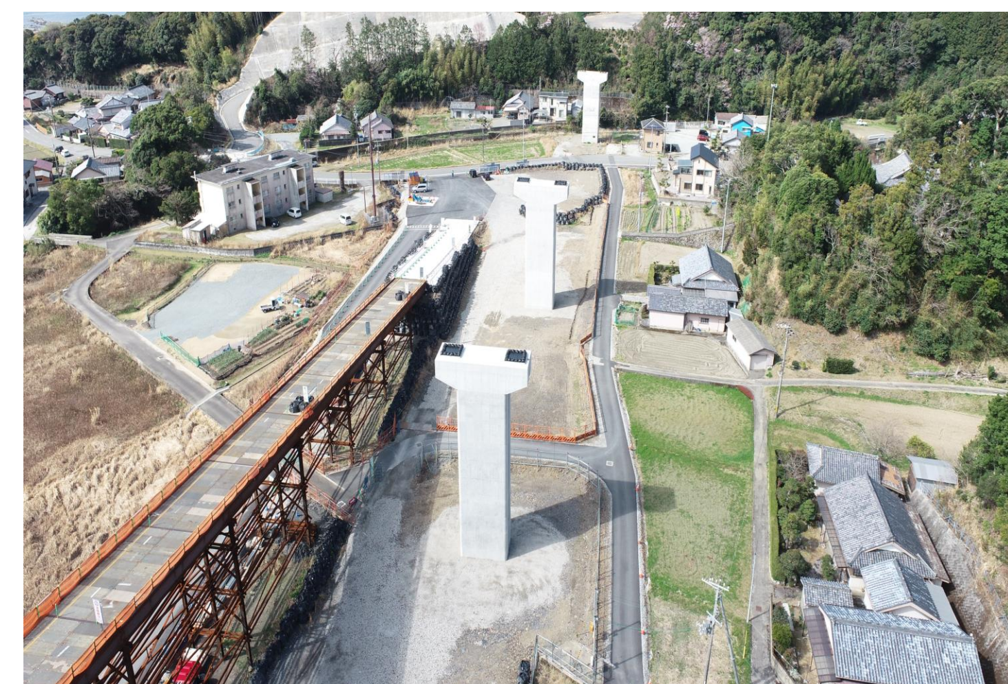
⑥ 高富川橋下部工事
