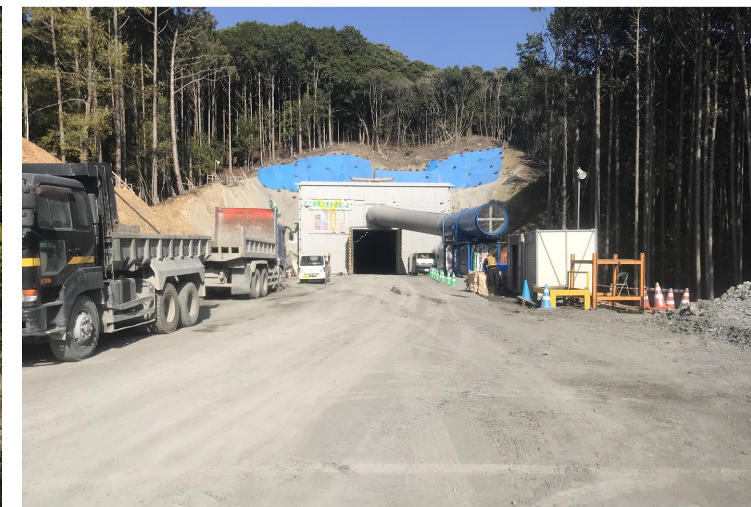
④ 田子トンネル他工事
