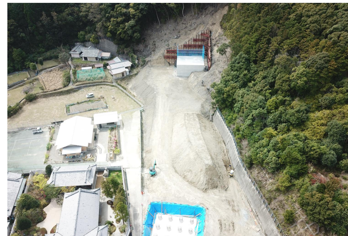
③ 和深川橋A1下部工事
