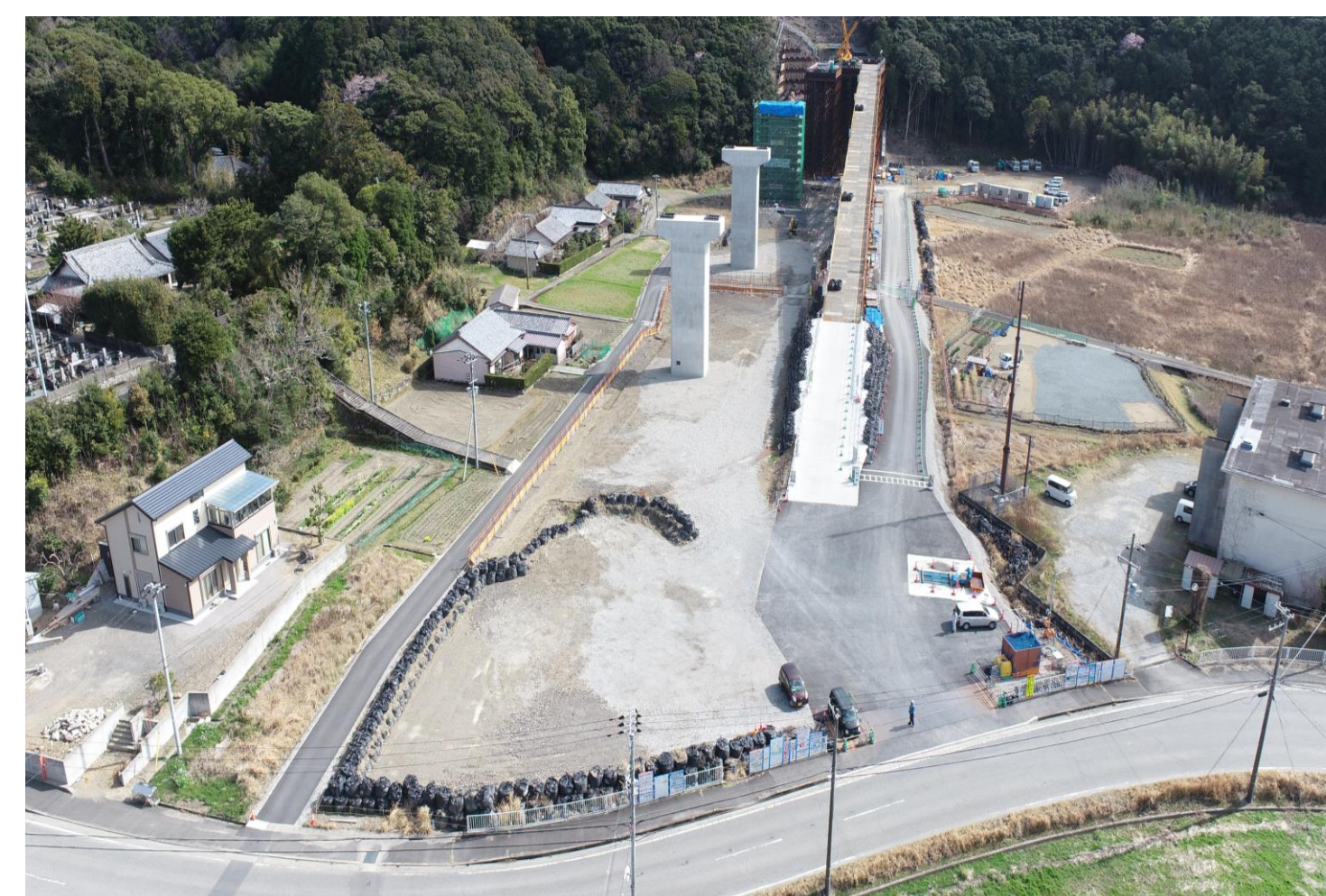
⑤ 終点側より釜郷原川橋(仮称)方面を望む
