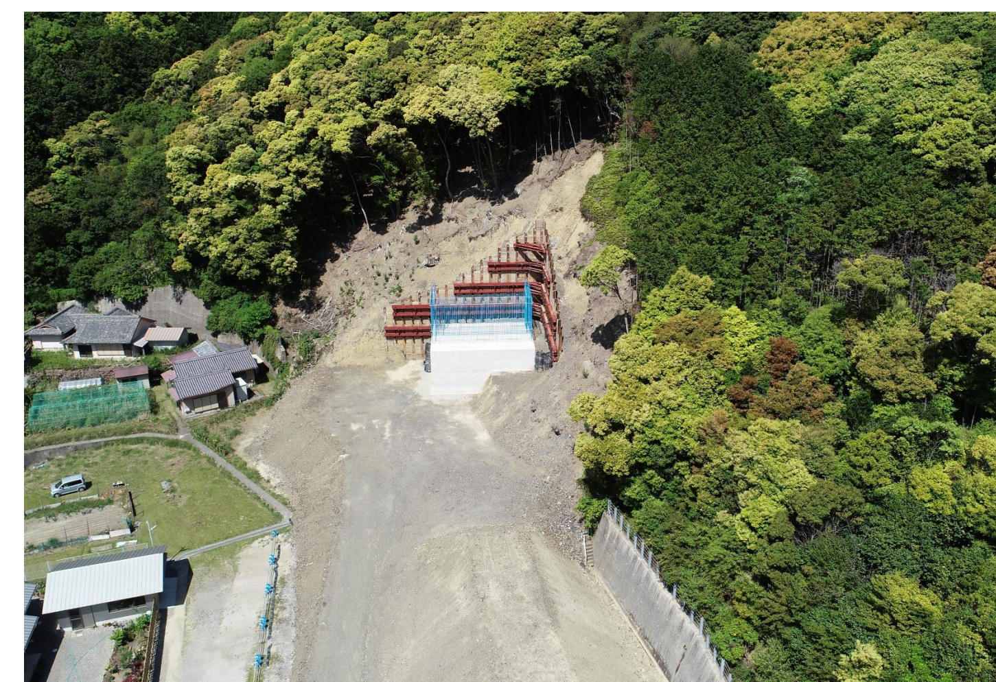
③ 和深川橋P3下部工事
