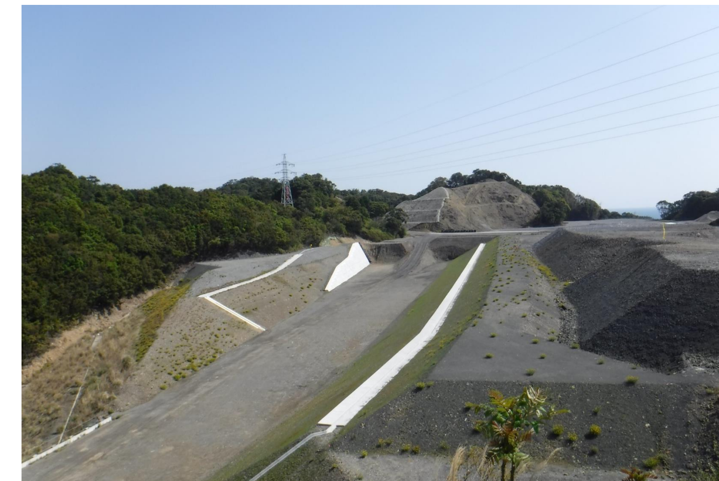
⑧ 串本IC西改良工事
