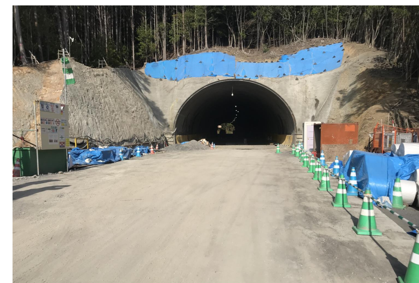
④ 田子トンネル他工事
