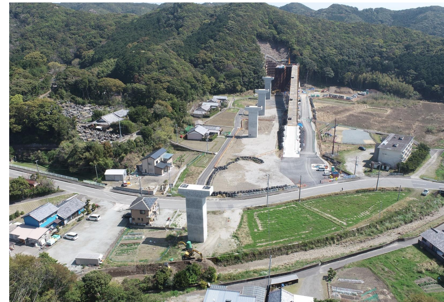
⑥ 高富川橋下部工事
