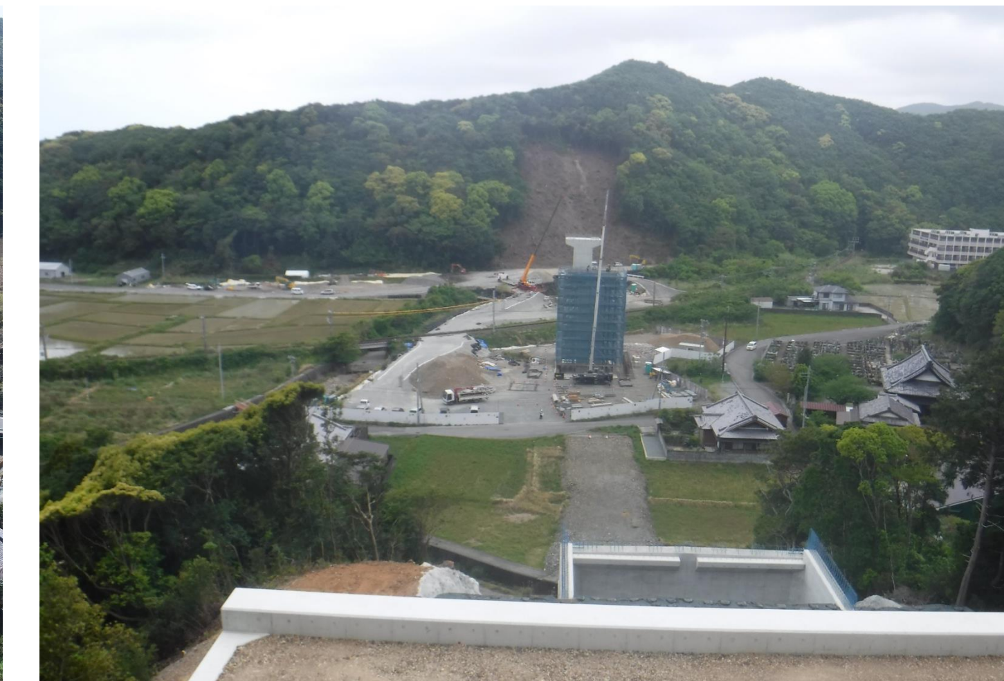
⑦ 二色川橋P3下部他工事
