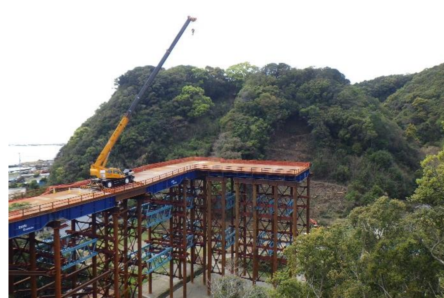
⑤ 釜郷原川地区進入路工事
