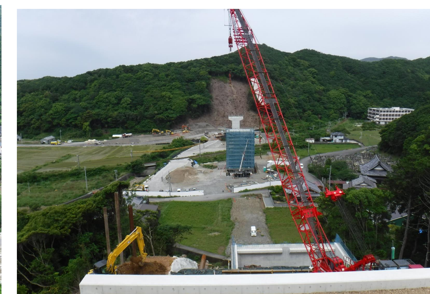
⑦ 二色川橋P3下部他工事
