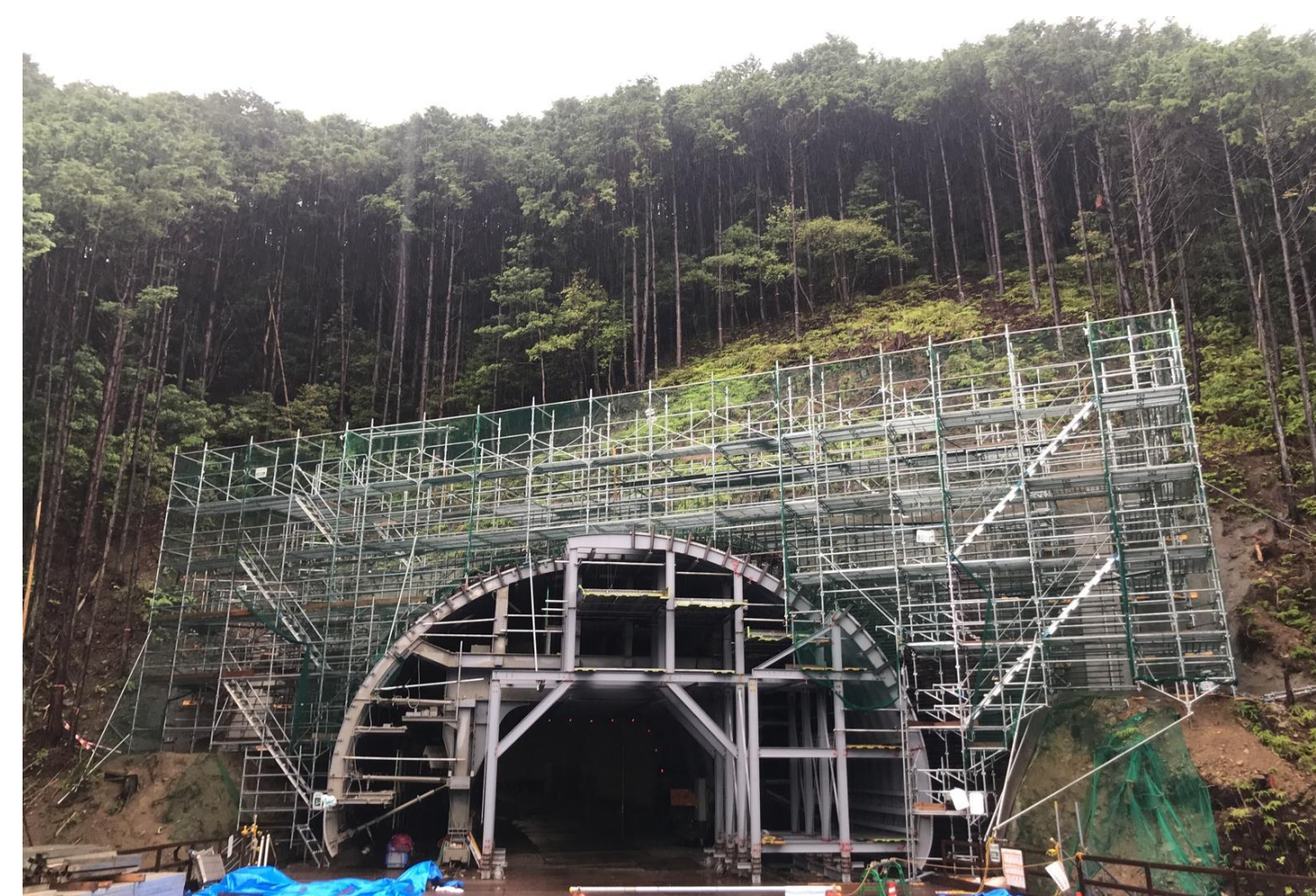
② 里野トンネル他工事(令和2年10月14日貫通)
