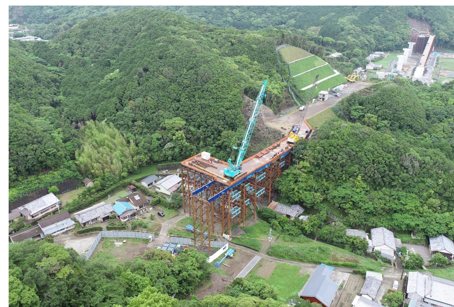
⑤ 釜郷原川地区進入路工事
