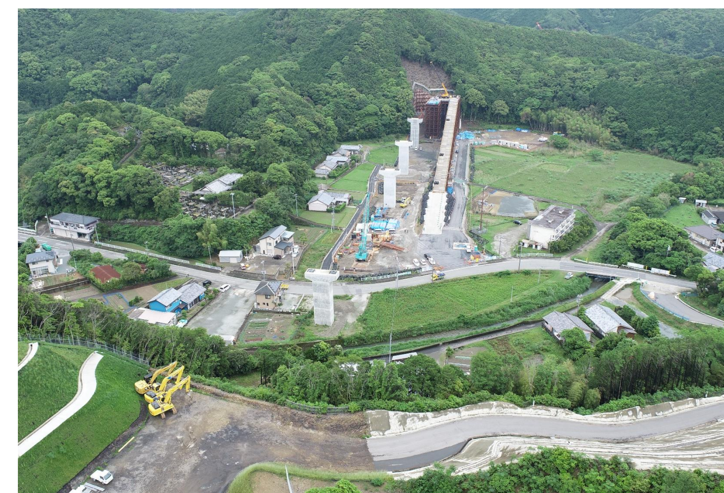
⑥ 高富川橋下部工事
