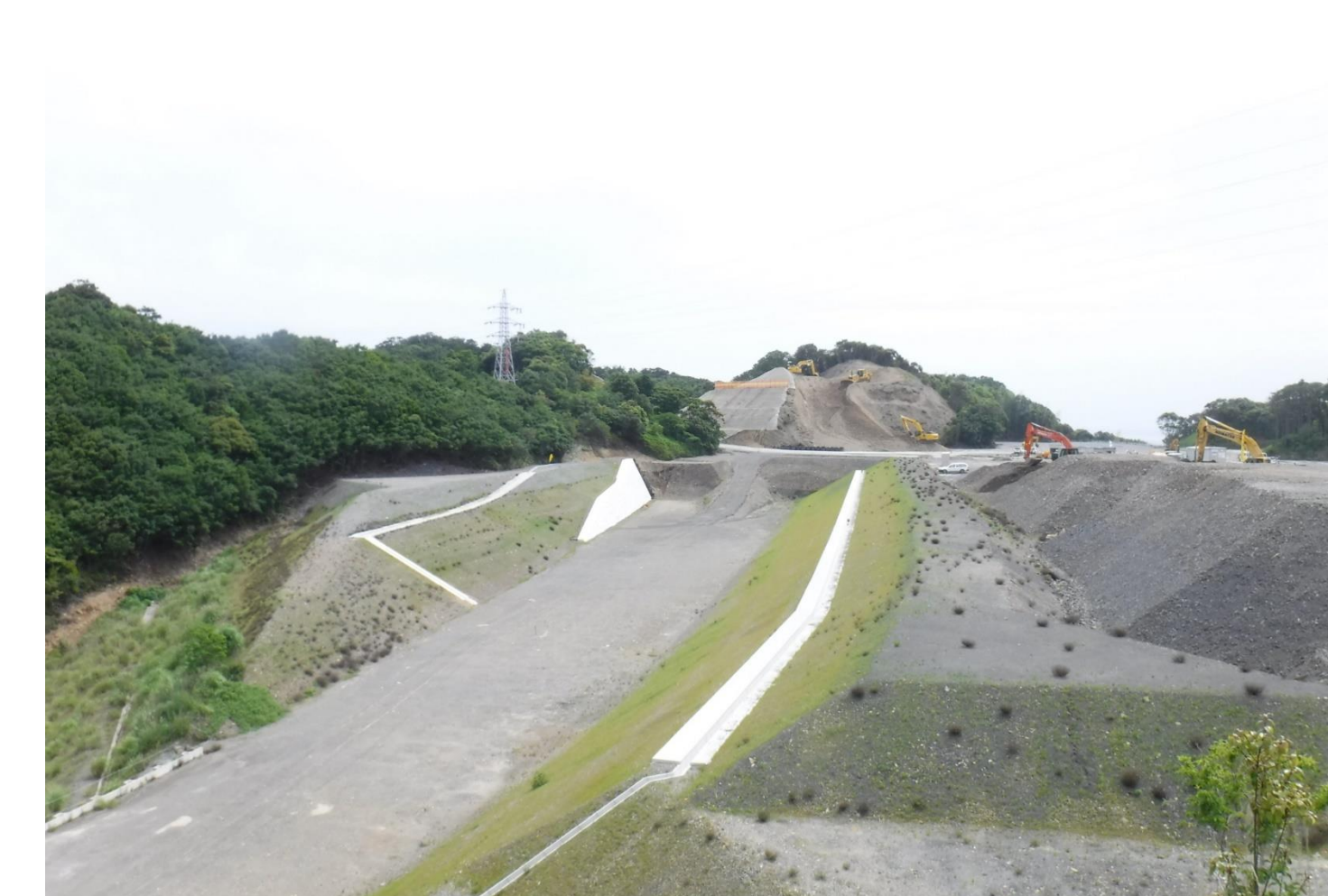
⑧ 串本IC西改良工事
