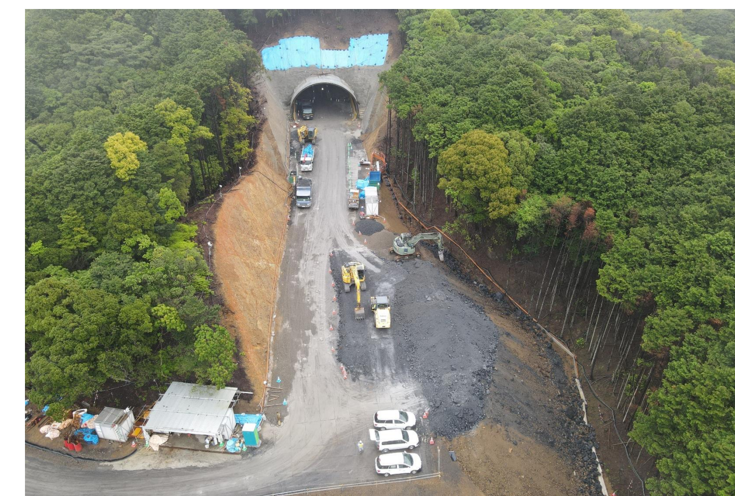
④ 田子トンネル他工事
