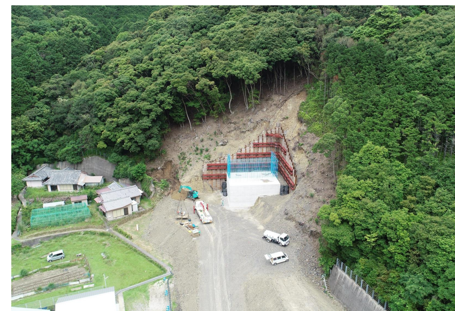
③ 和深川橋P3下部工事(A1橋台)
