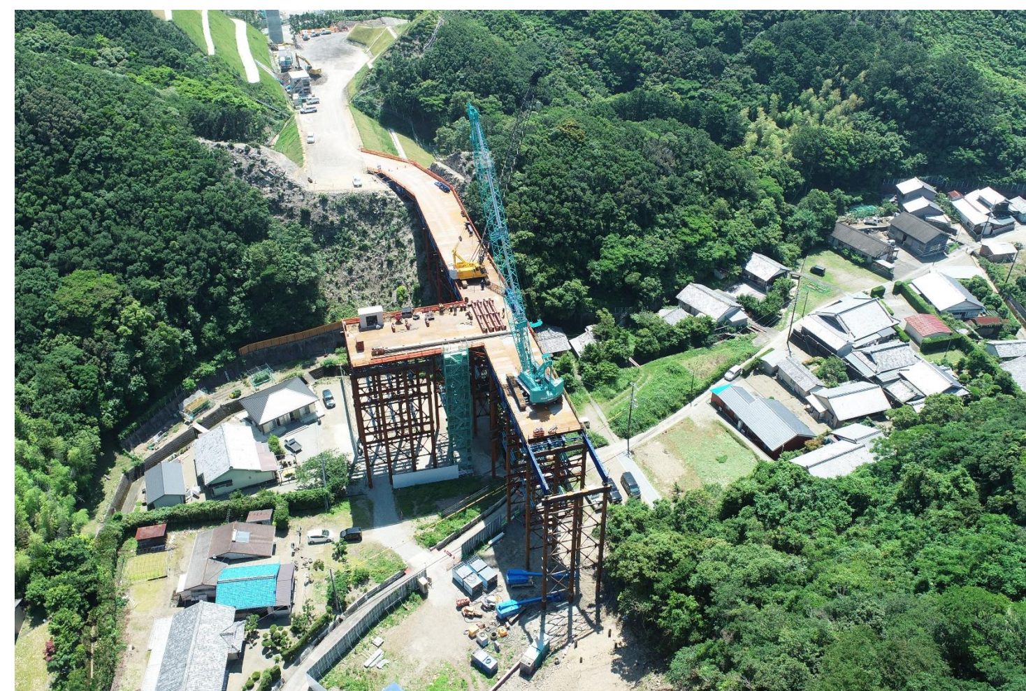
⑤ 釜郷原川地区進入路工事
