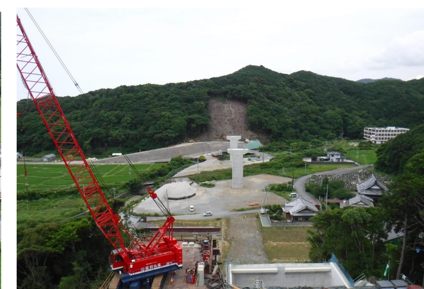
⑦ 二色川橋P3下部他工事
