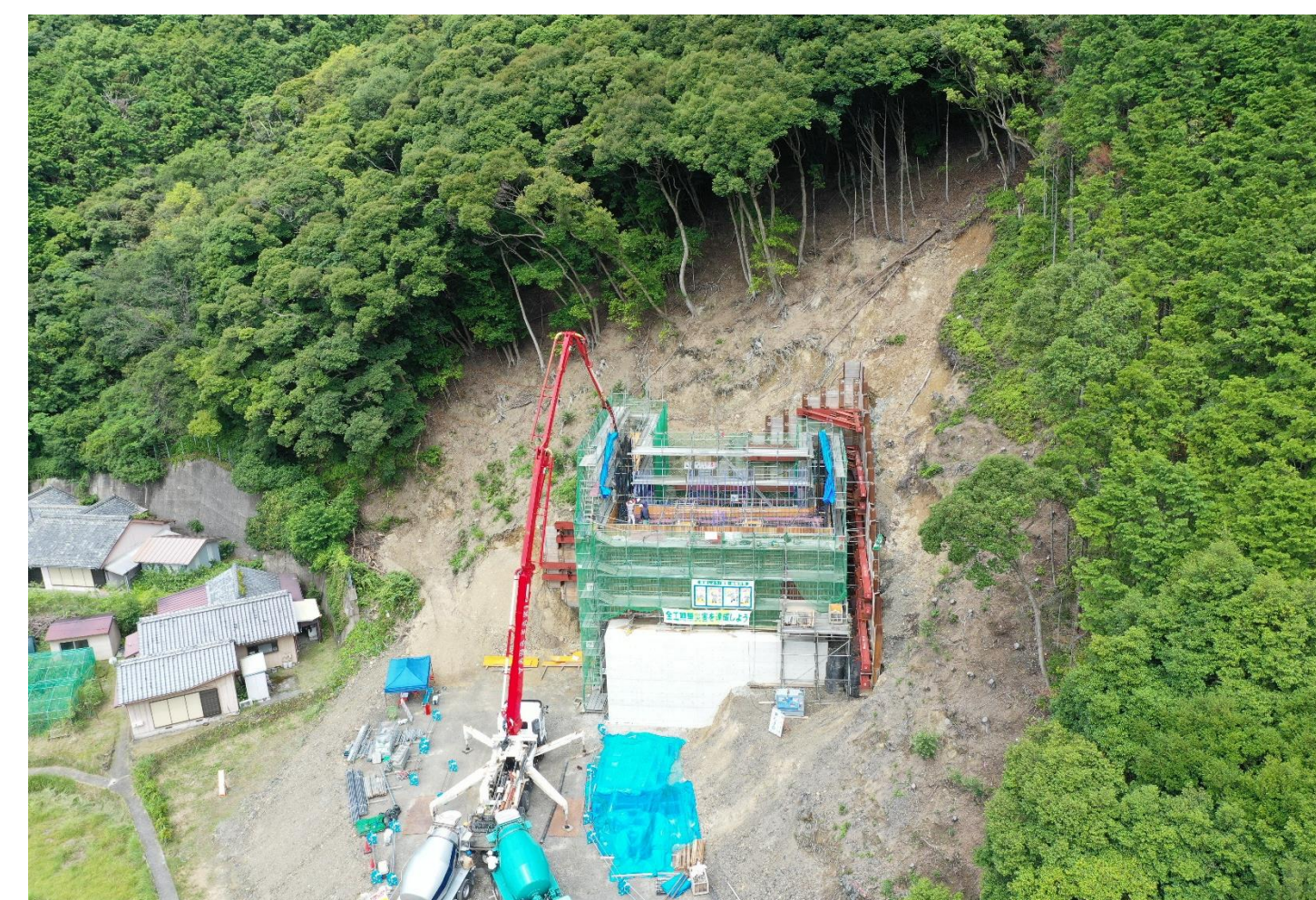
③ 和深川橋P3下部他工事(A1橋台)
