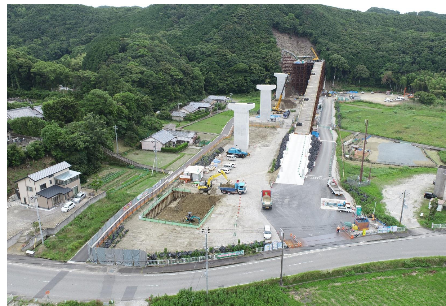
⑥ 高富川橋下部工事
