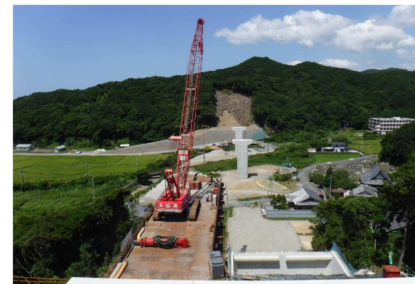
⑦ 二色川橋P3下部他工事
