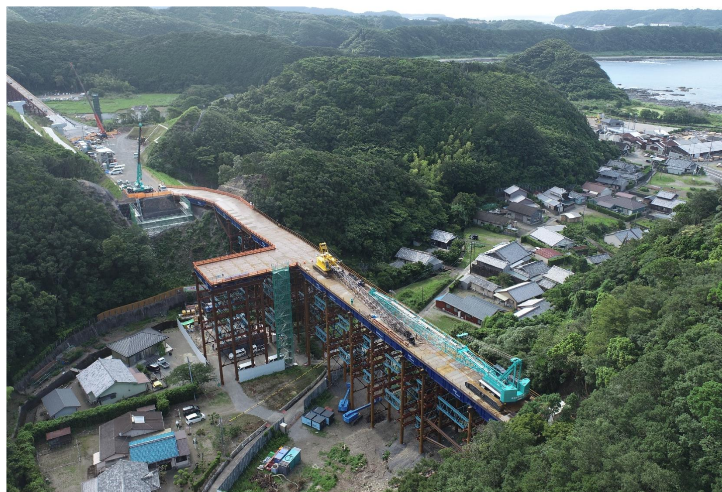
⑤ 釜郷原川地区進入路工事
