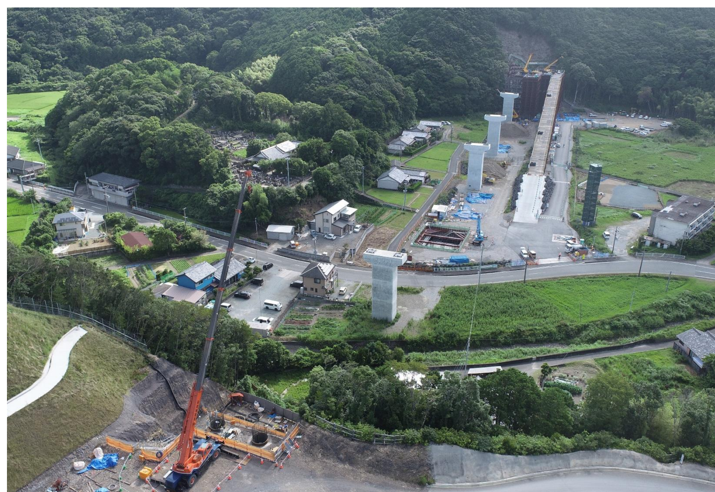
⑥ 高富川橋下部工事
