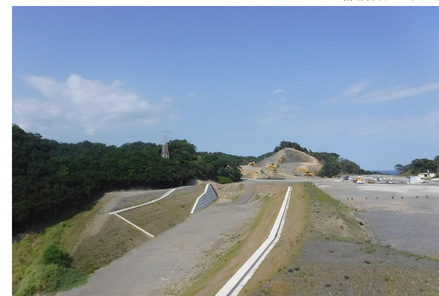
⑧ 串本IC西改良工事
