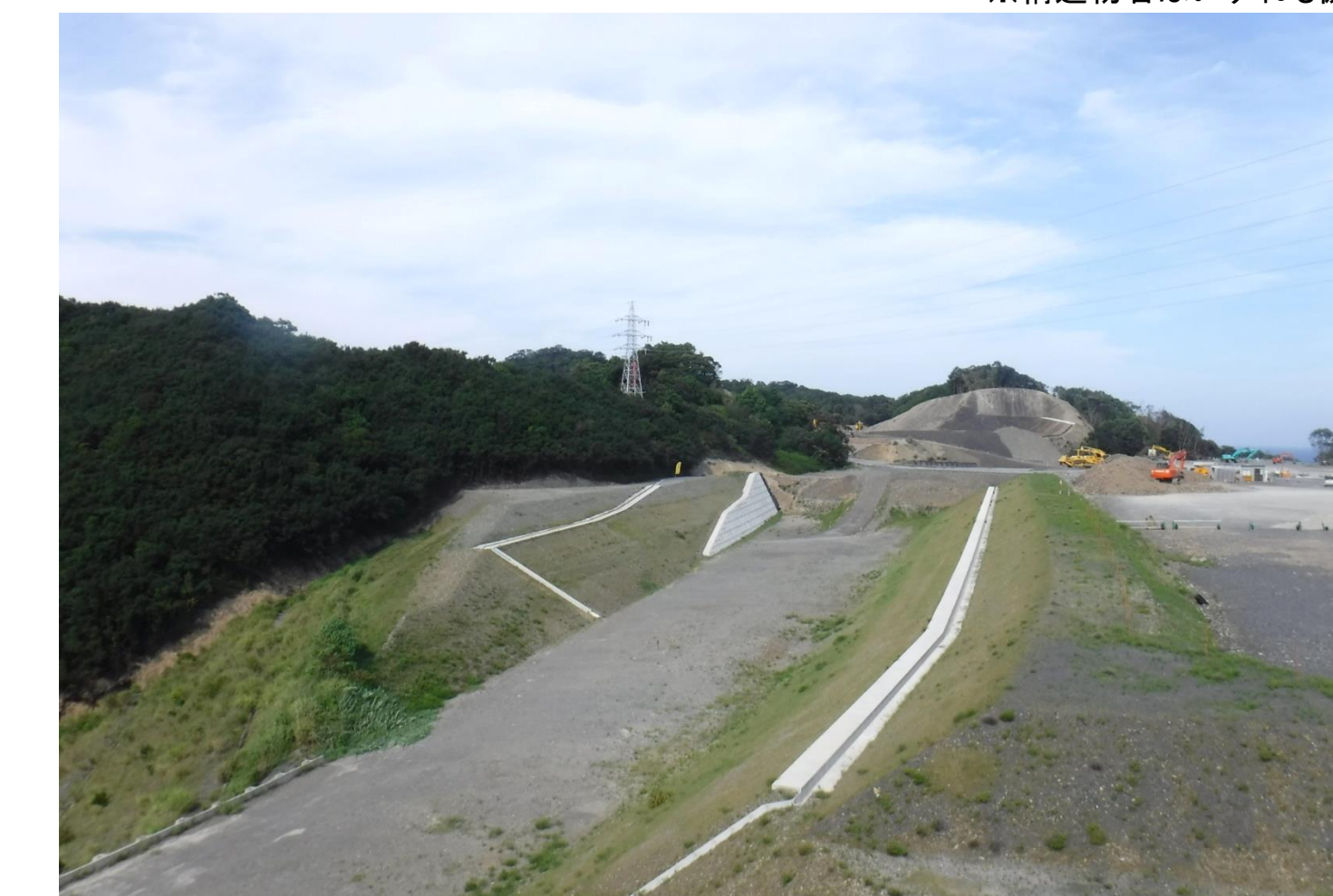
⑧ 串本IC西改良工事
