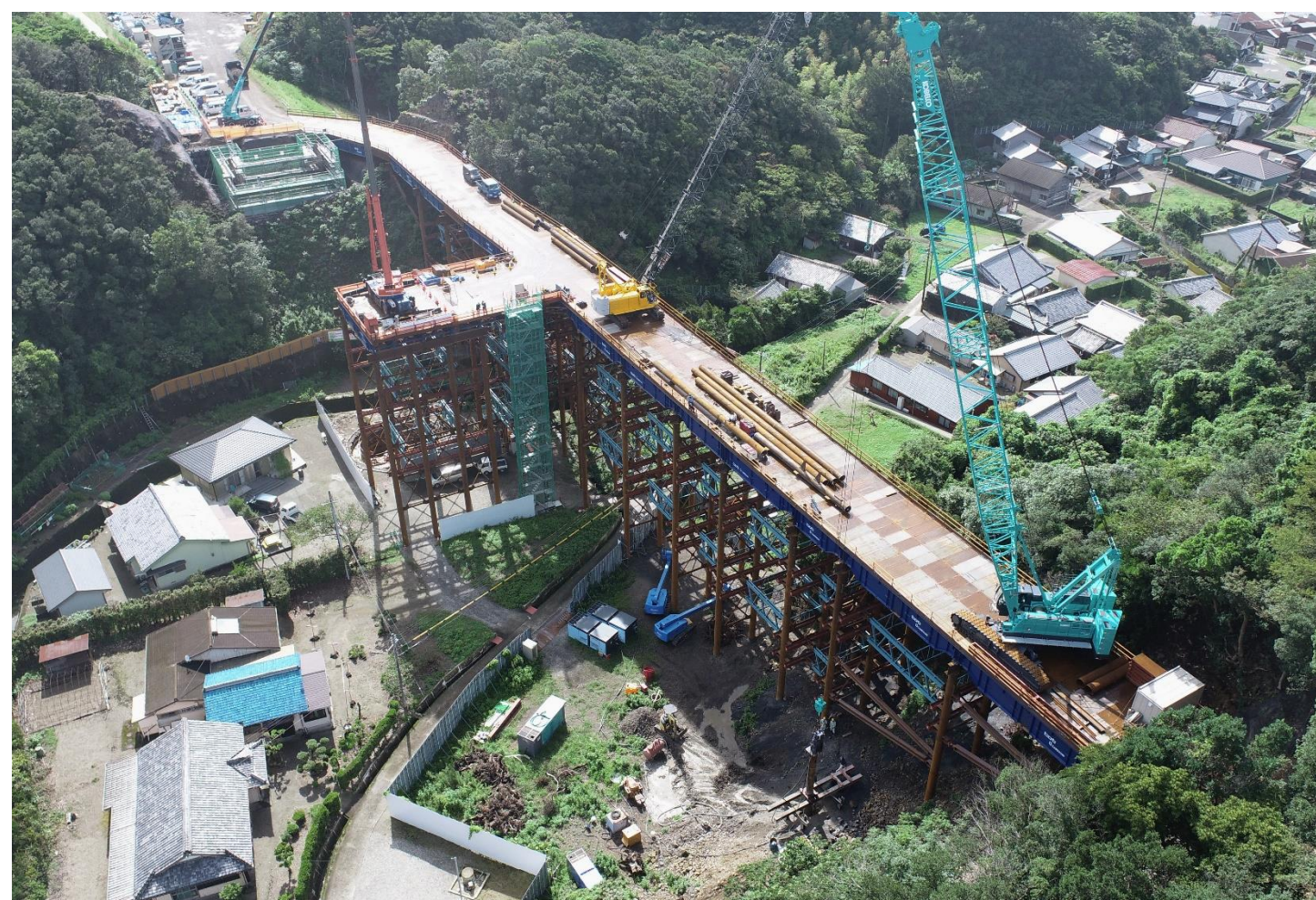
⑤ 釜郷原川地区進入路工事
