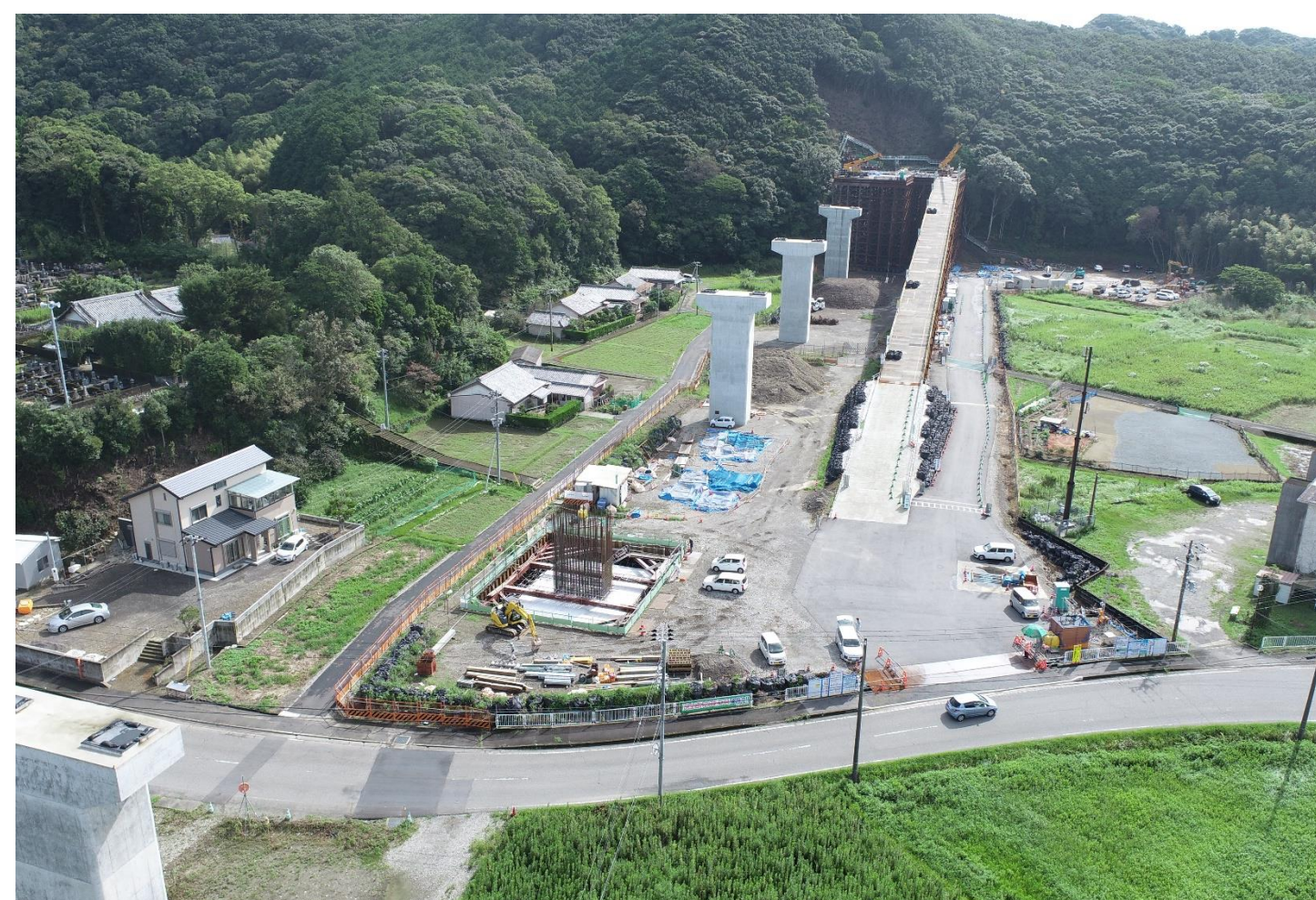
⑥ 高富川橋下部工事
