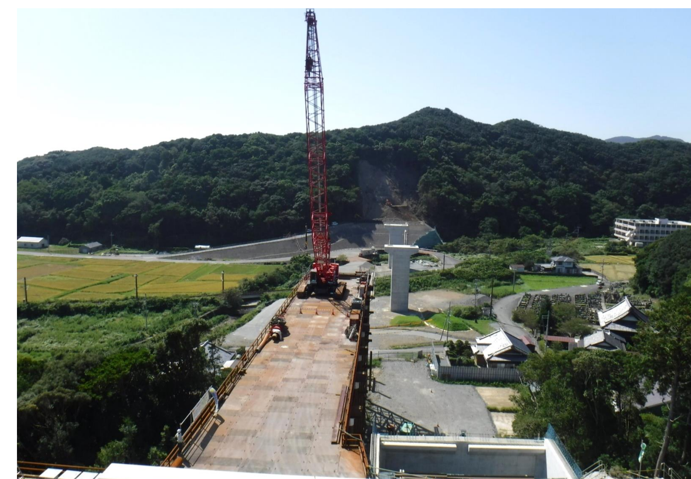
⑦ 二色川橋P3下部他工事
