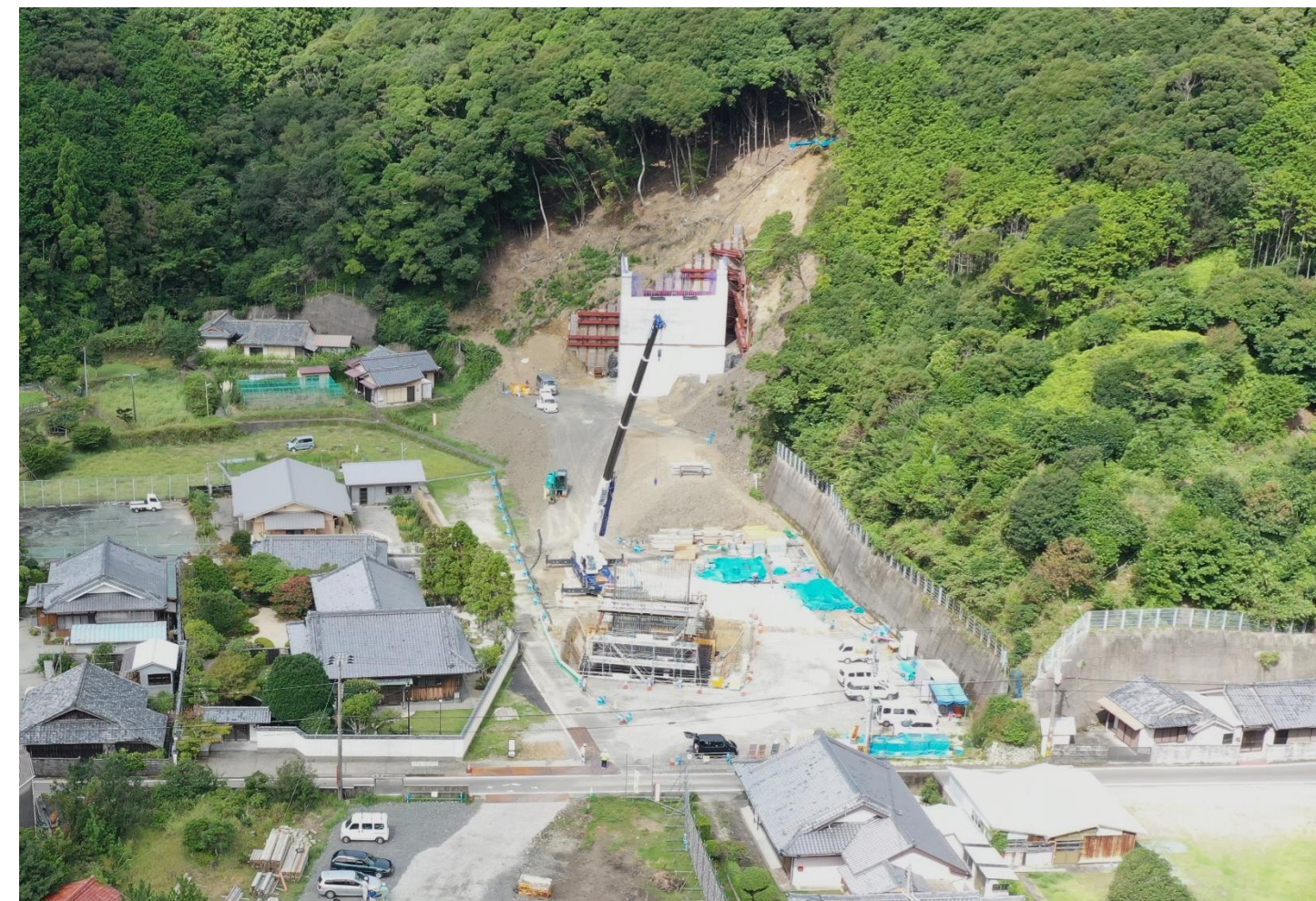
③ 和深川橋P3下部他工事
