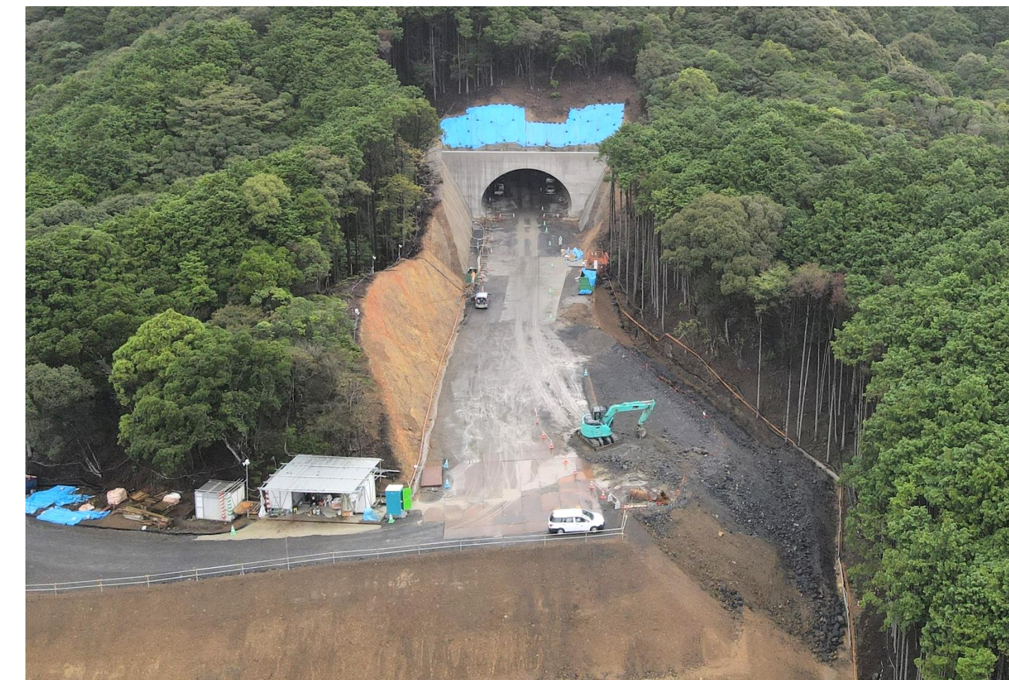
④ 田子トンネル他工事
