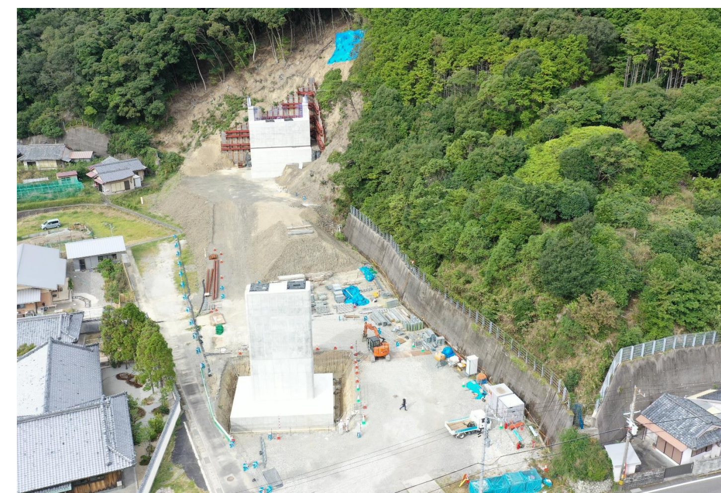
③ 和深川橋P3下部他工事
