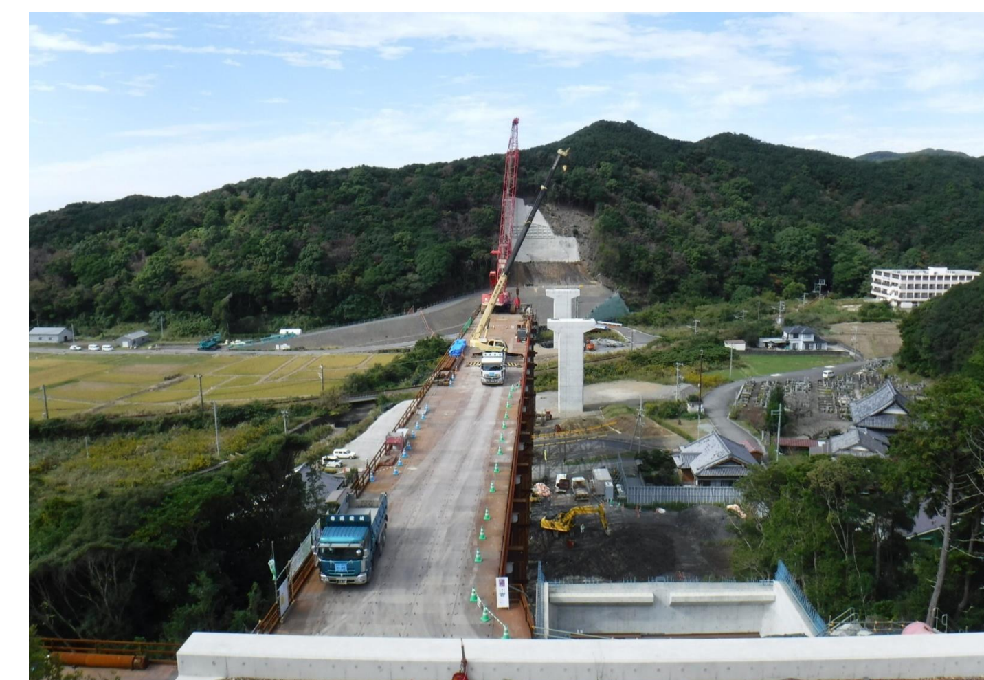
⑦ 二色川橋P3下部他工事
