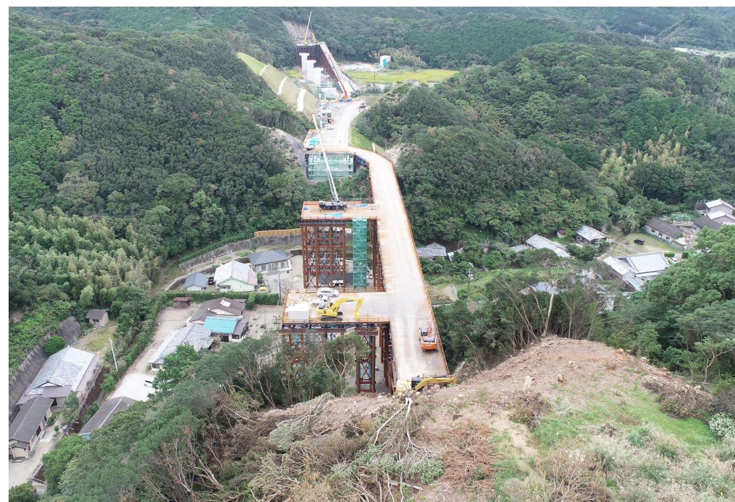
⑤ 釜郷原川地区進入路工事
