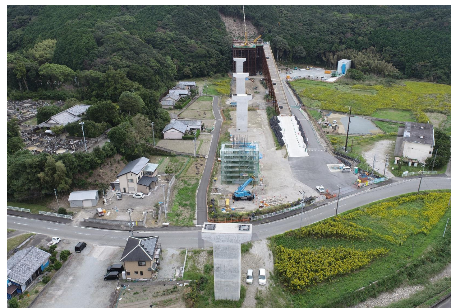
⑥ 高富川橋下部工事
