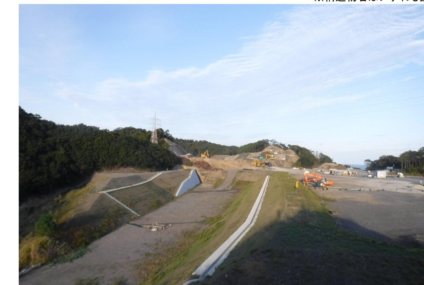
⑧ 串本IC西改良工事
