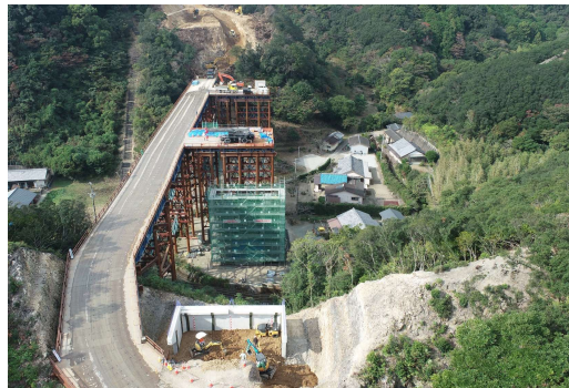
⑤ 釜郷原川地区進入路工事
