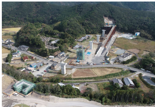
⑥ 高富川橋下部工事
