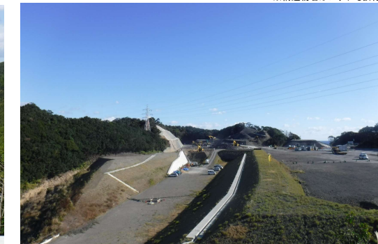
⑧ 串本IC西改良工事
