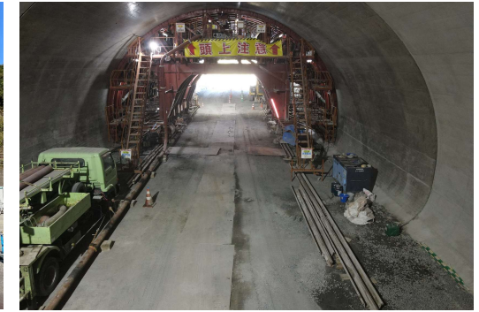
④ 田子トンネル他工事(令和3年4月5日貫通)
