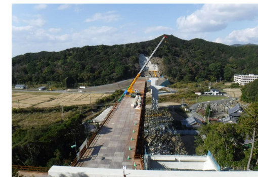
⑦ 二色川橋P3下部他工事
