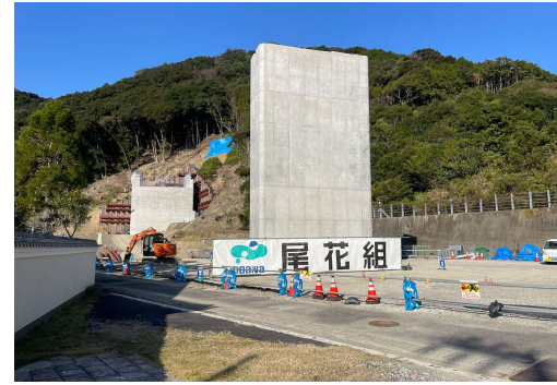
③ 和深川橋P3下部他工事
