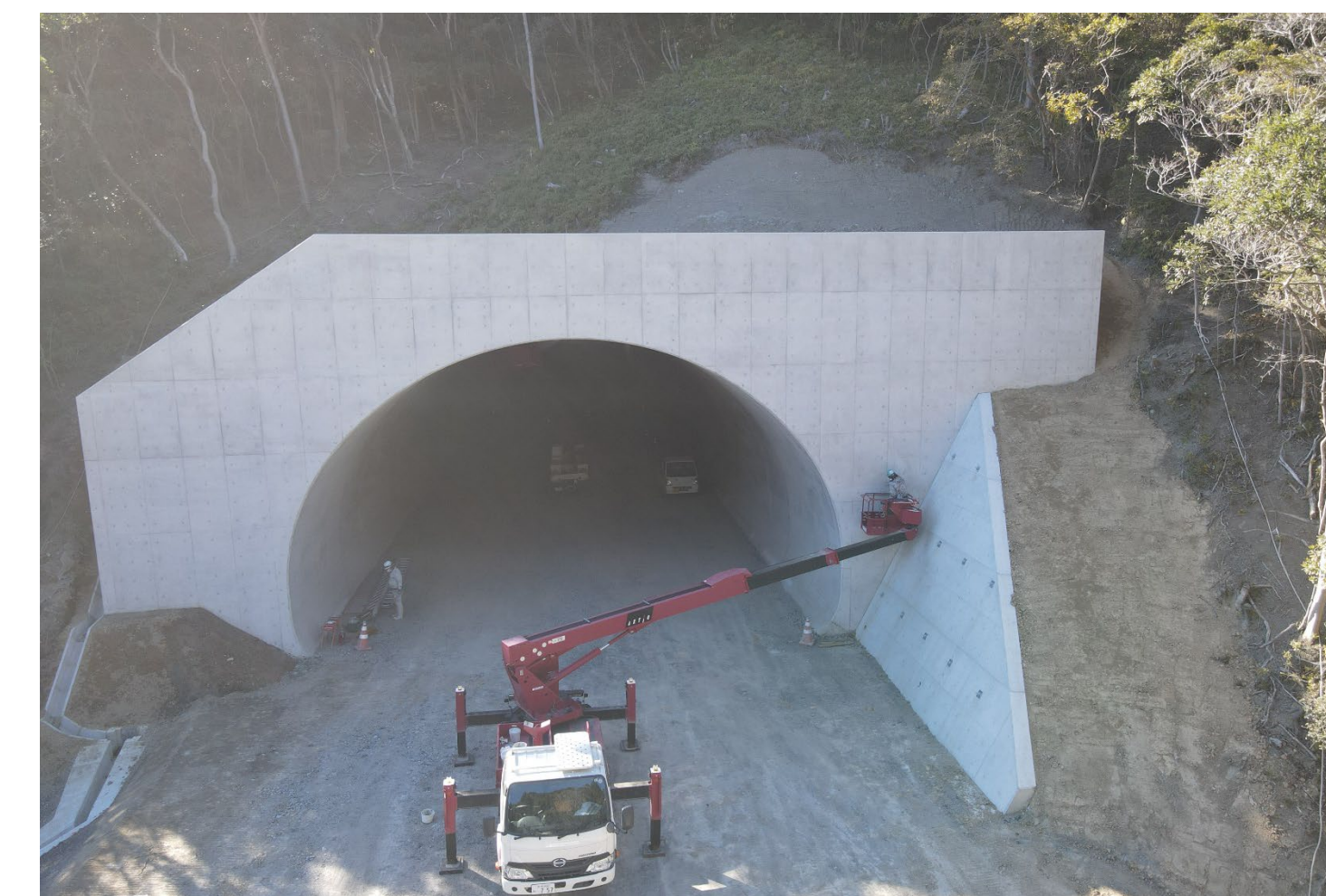
④ 田子トンネル他工事(令和3年4月5日貫通)
