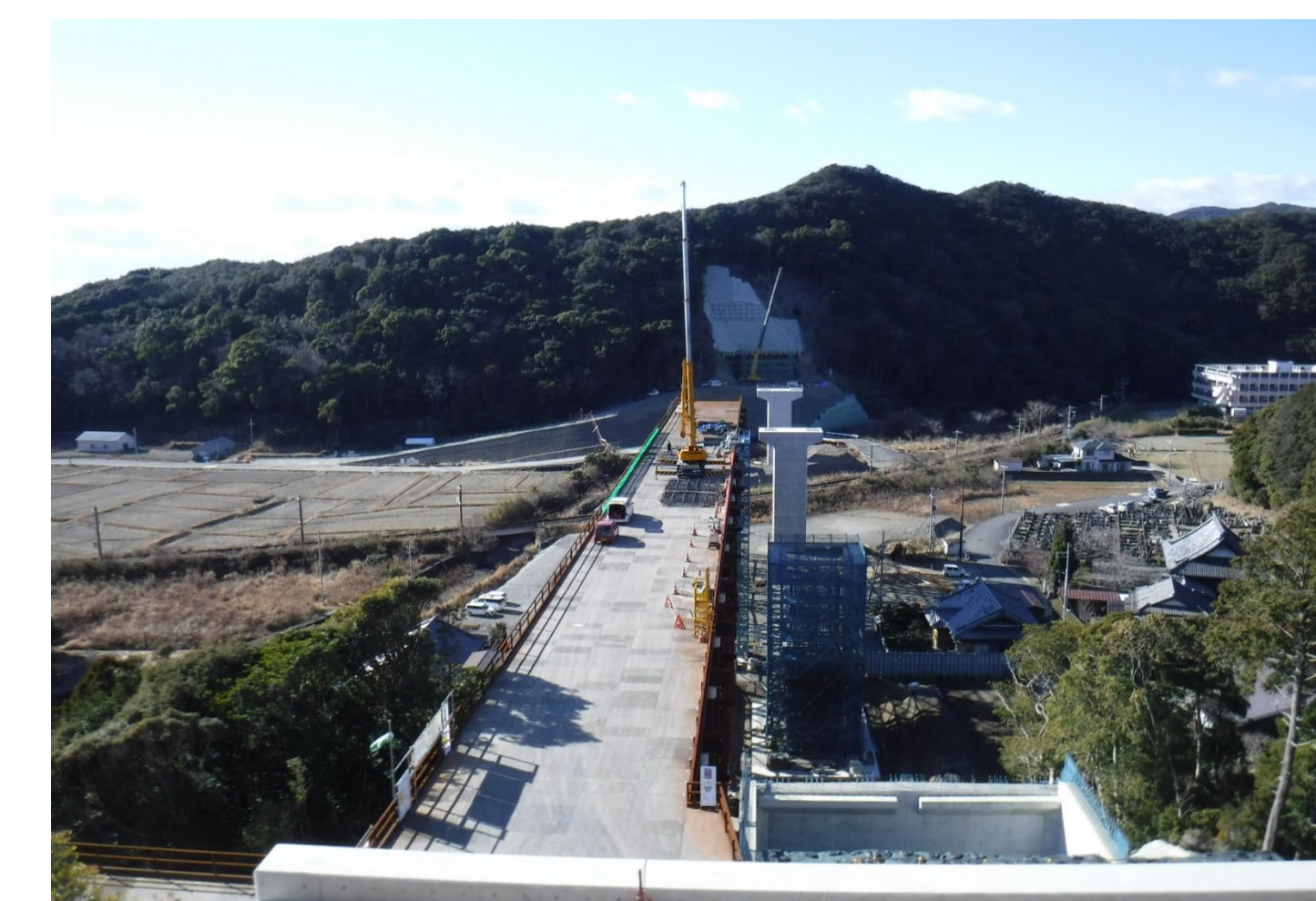
⑦ 二色川橋P3下部他工事
