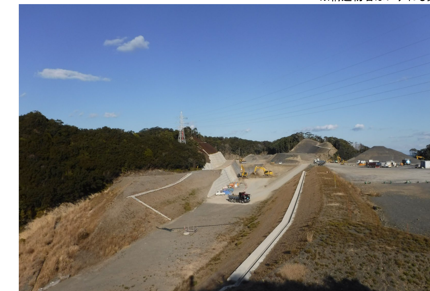
⑧ 串本IC西改良工事
