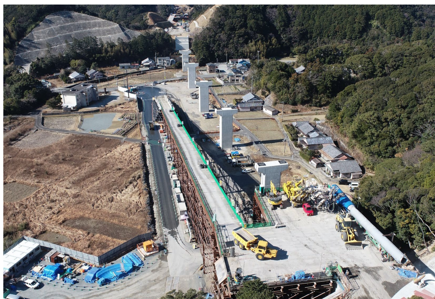
⑥ 高富川橋下部工事
