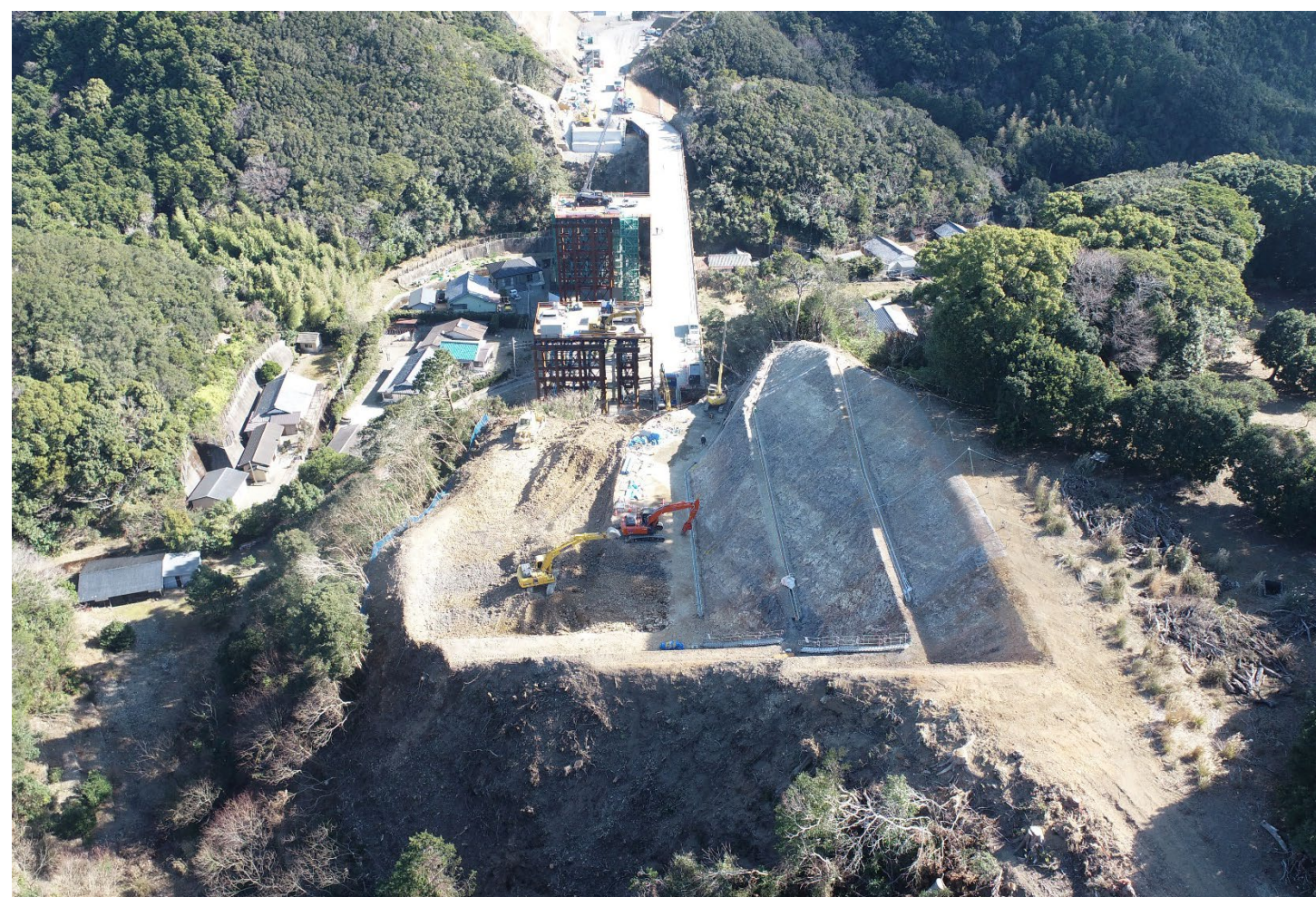
⑤ 釜郷原川地区進入路工事
