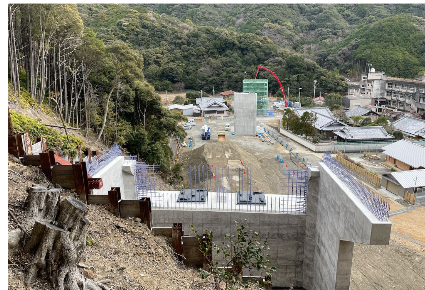
③ 和深川橋P3下部他工事
