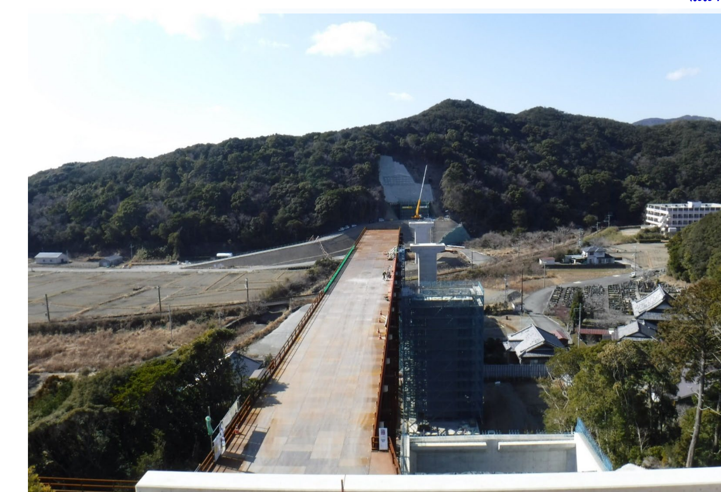
⑦ 二色川橋P3下部他工事
