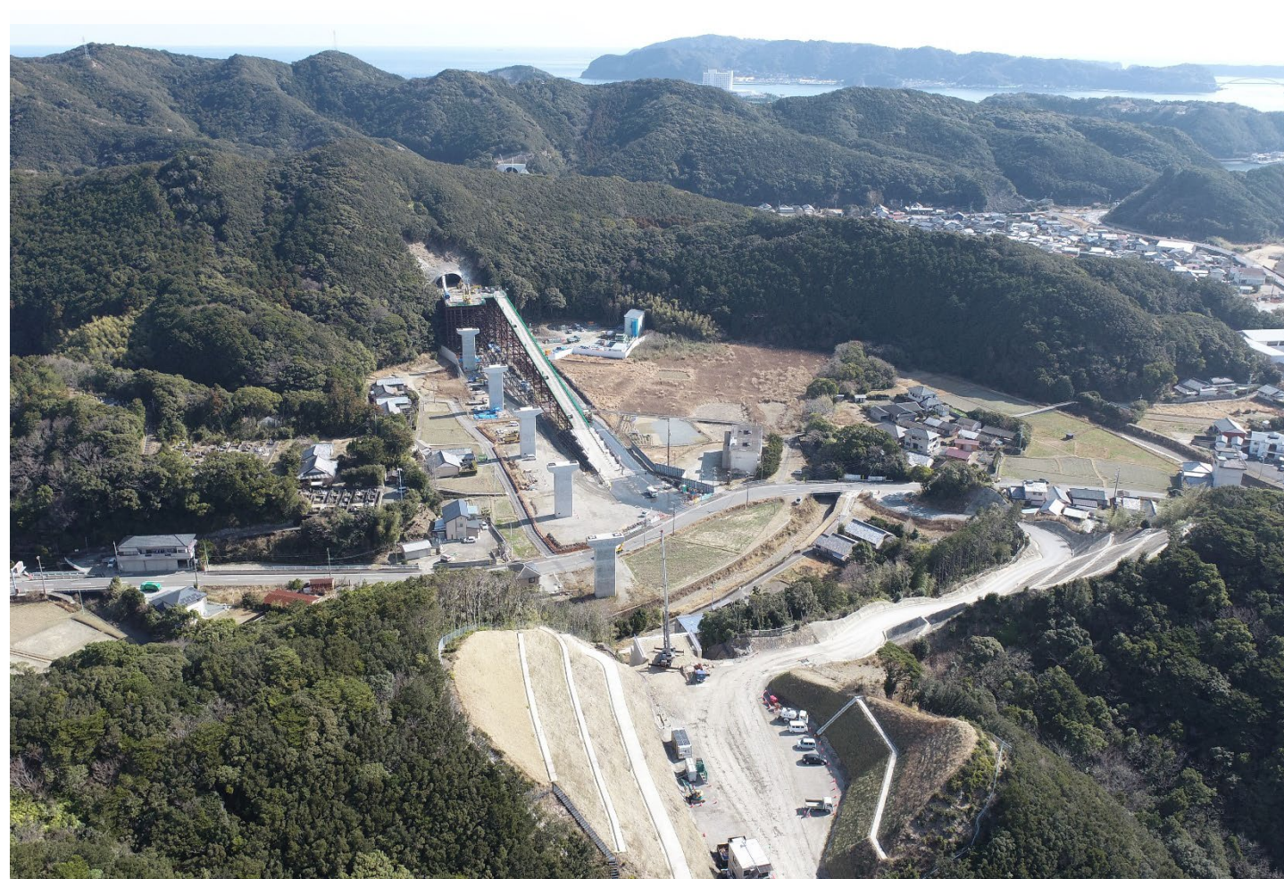
⑥ 高富川橋下部工事
