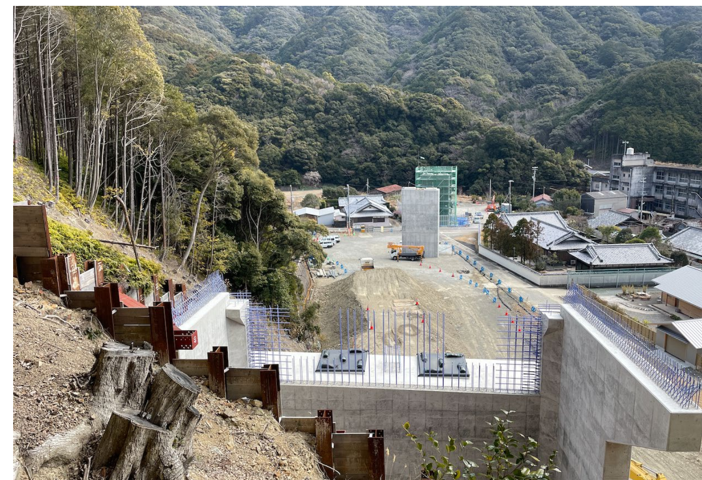
③ 和深川橋P3下部他工事
