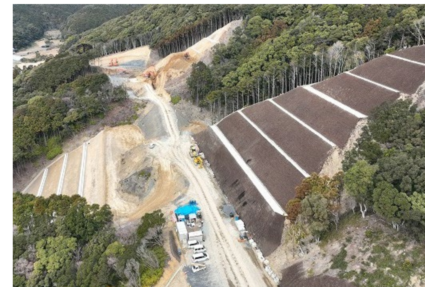
④ 江田地区他改良工事
