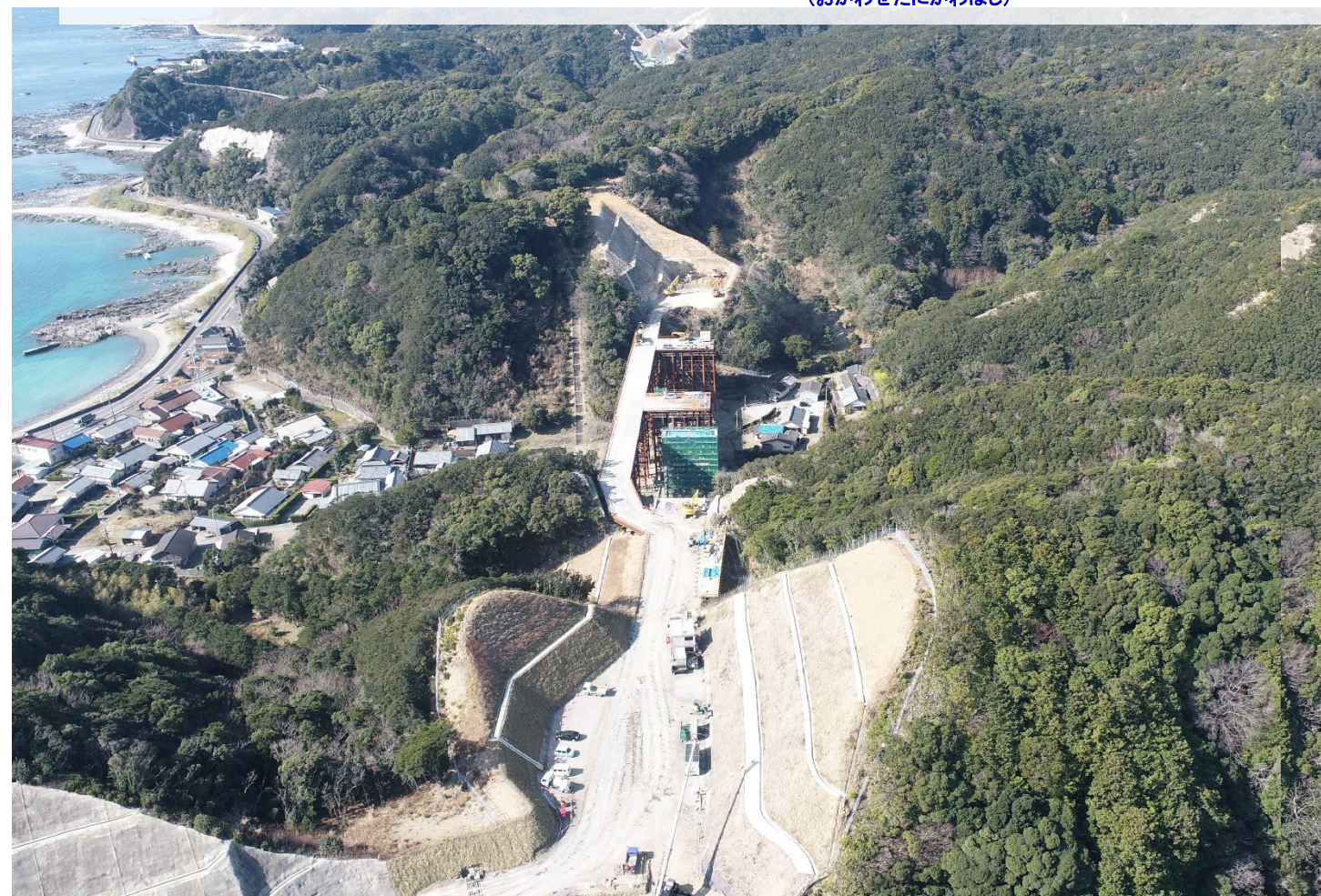
⑤ 釜郷原川地区進入路工事
