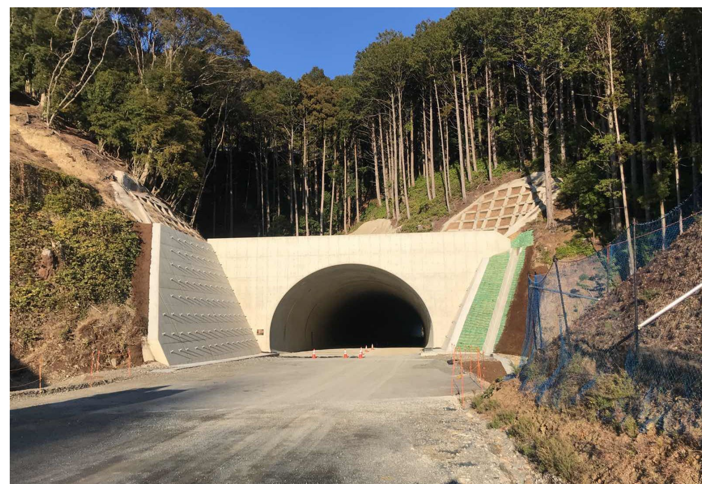
② すさみ町里野(里野トンネル)
