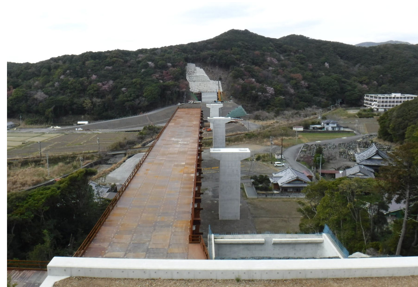
⑦ 串本町二色(二色川橋)
