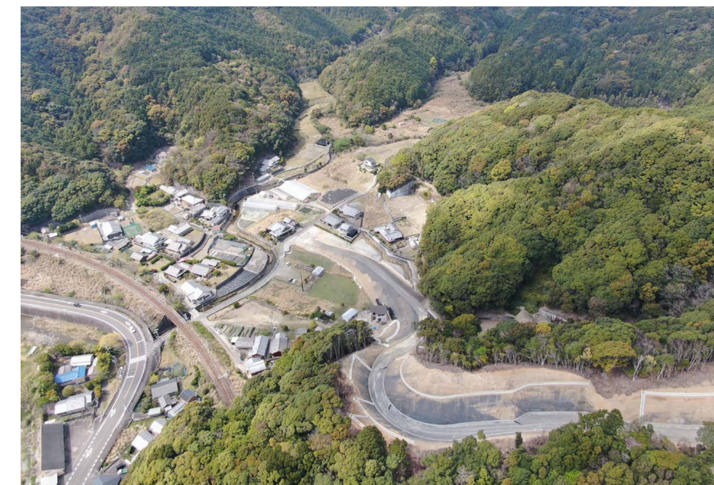
④ 串本町江田(工事用道路・江田川橋付近)
