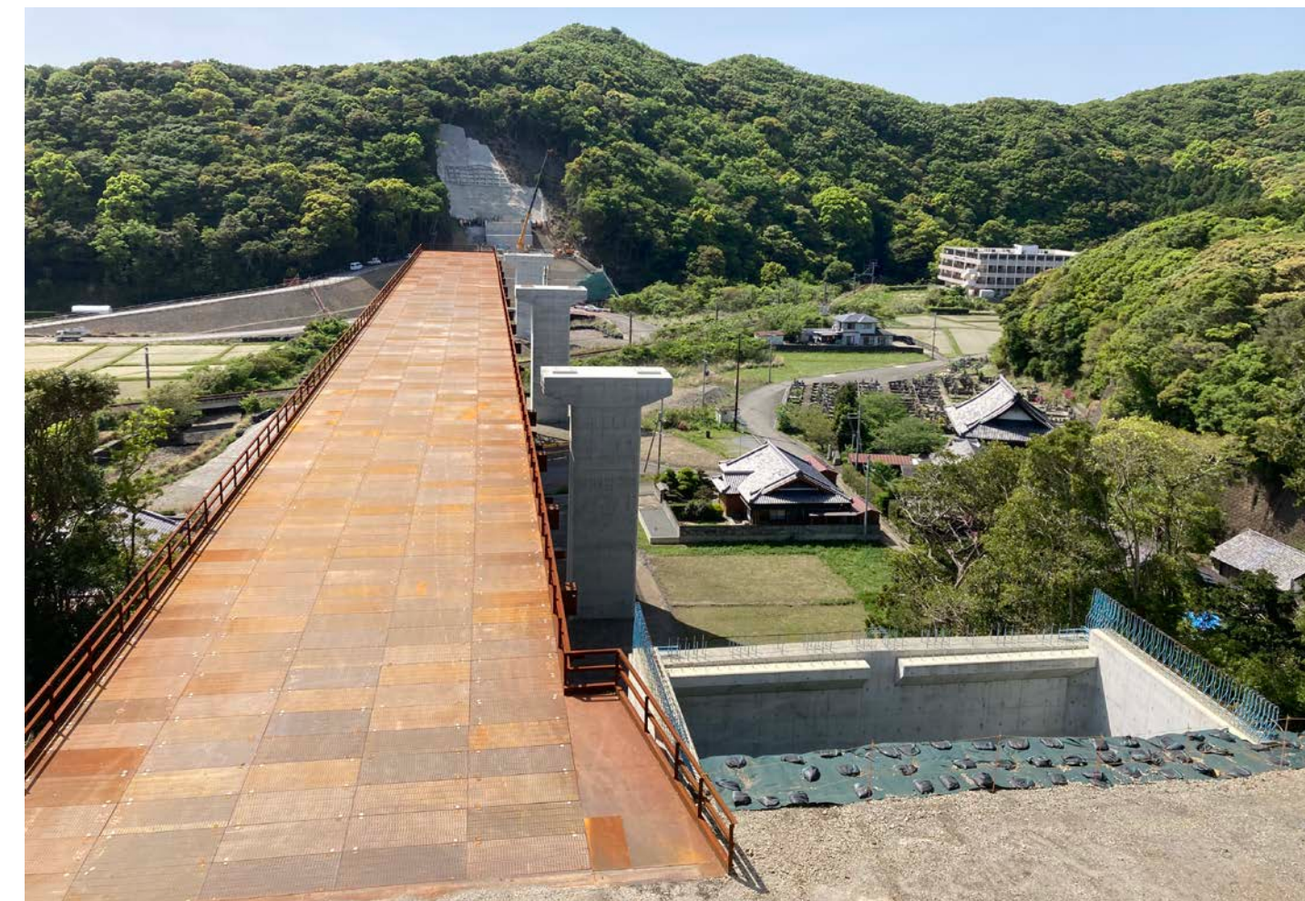
⑦ 串本町二色(二色川橋)
