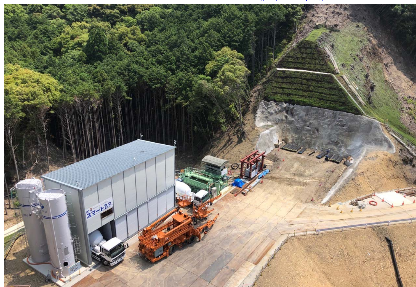
⑤ 串本町有田(有田上第1トンネル)
