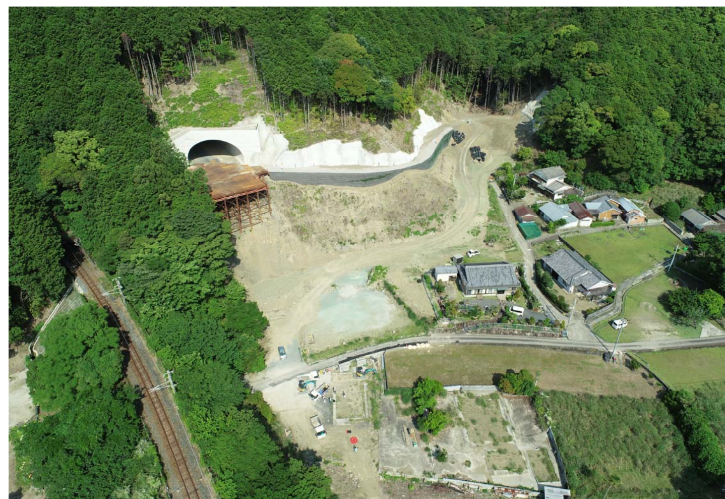
② すさみ町里野(里野西池川橋)
