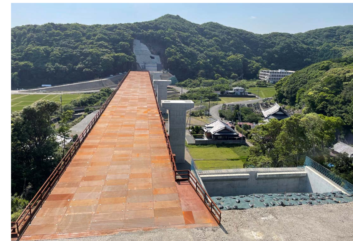
⑦ 串本町二色(二色川橋)
