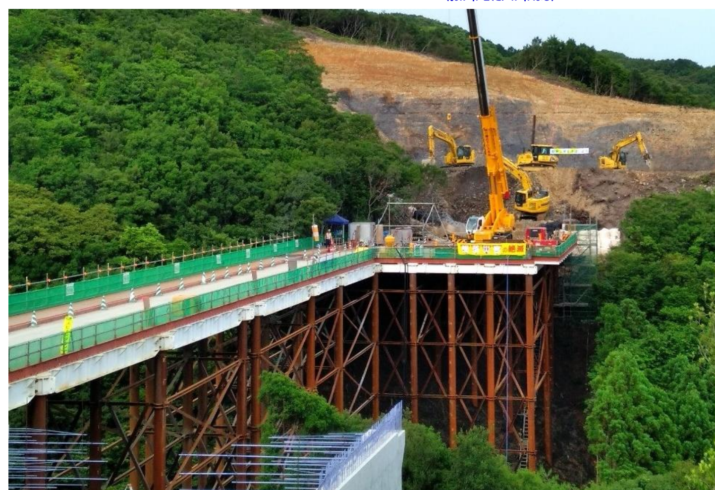
⑤ 串本町高富(東雨川第一橋)
