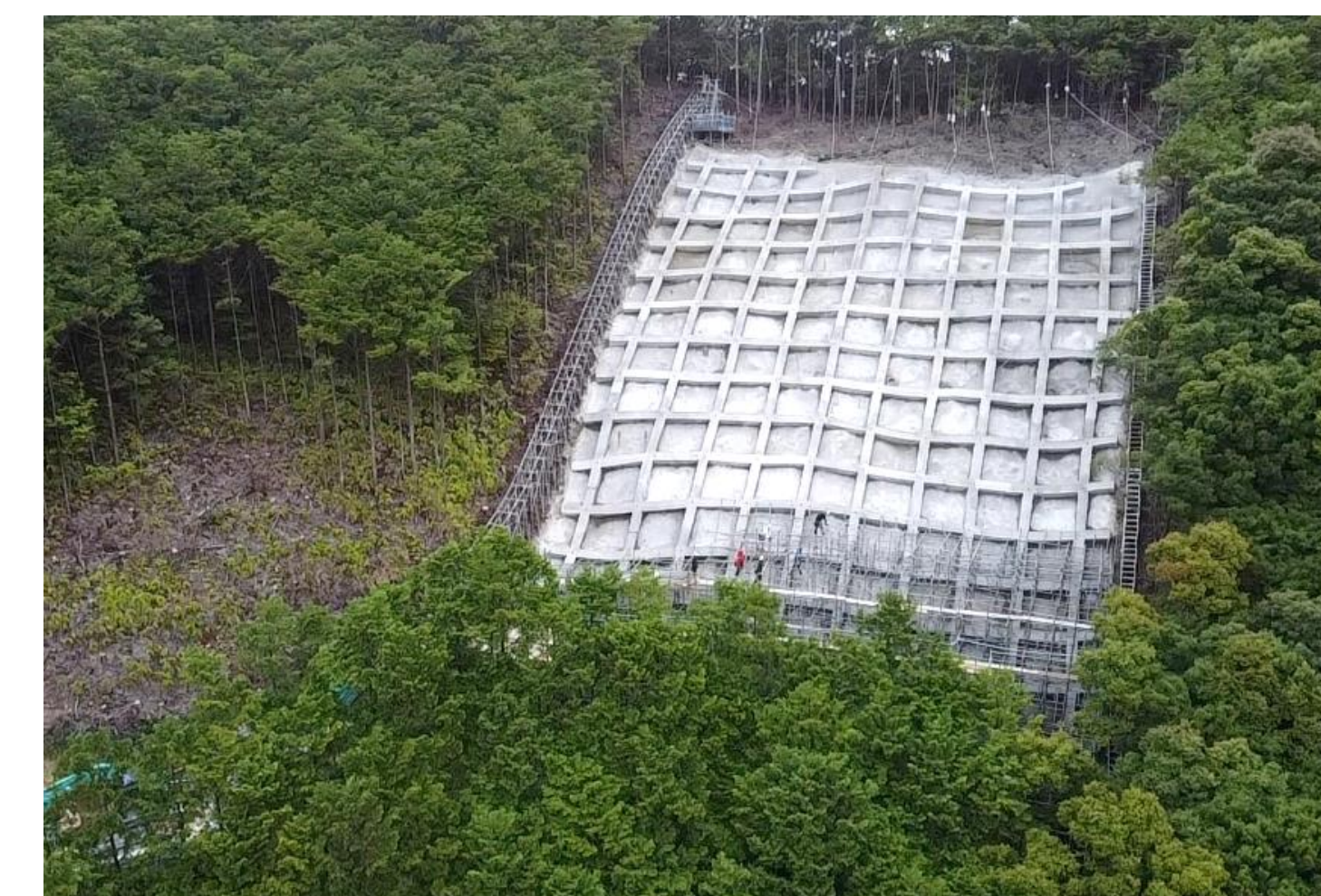
④ 串本町有田(田並トンネル)
