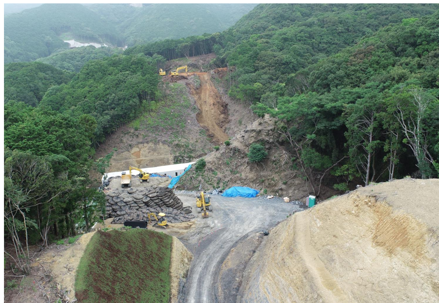
② すさみ町里野(小河瀬谷川橋)
