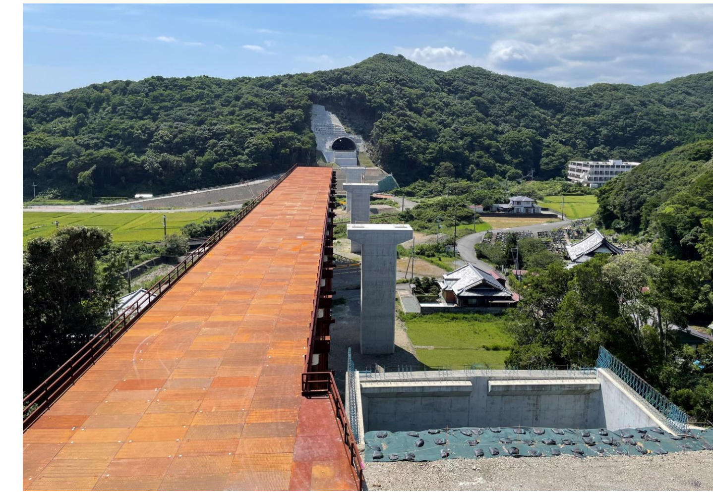
⑦ 串本町二色(二色川橋)
