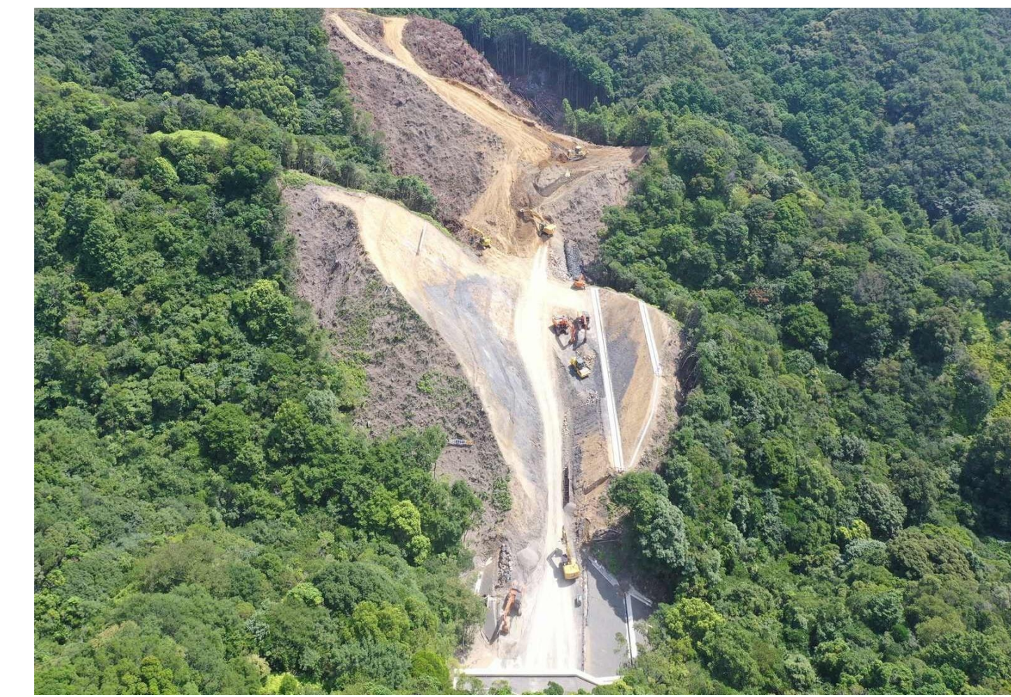
④ 串本町田子(道路改築)
