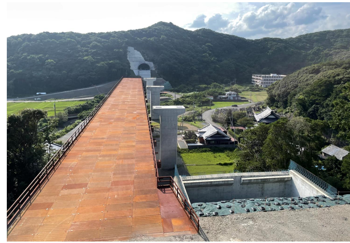
⑦ 串本町二色(二色川橋)
