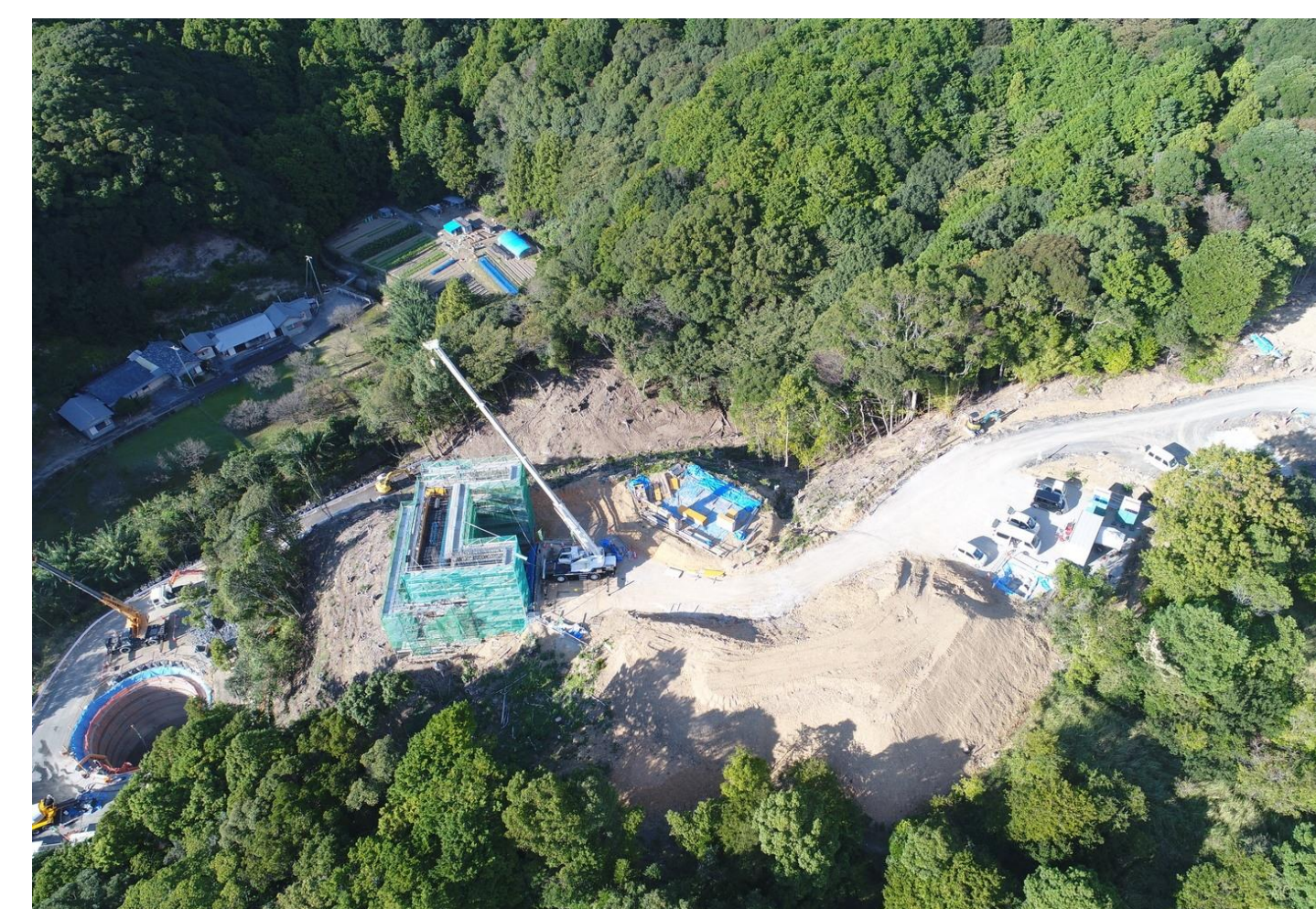
③ 串本町和深(熊谷川第二橋)
