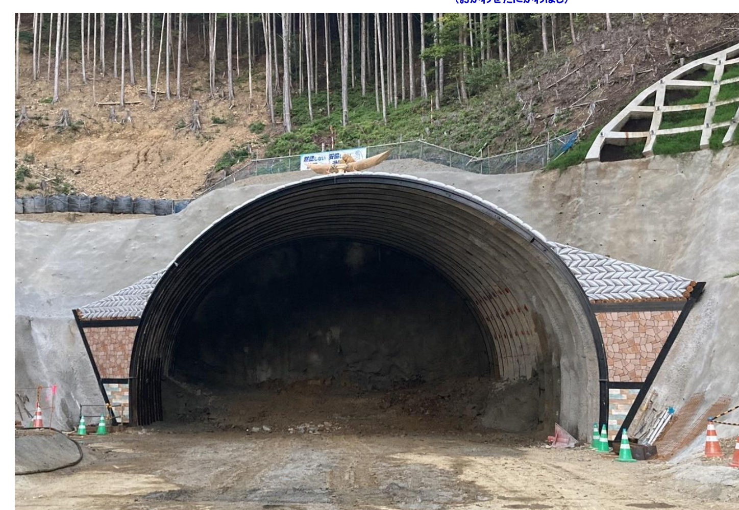
⑤ 串本町田並(田並トンネル)
