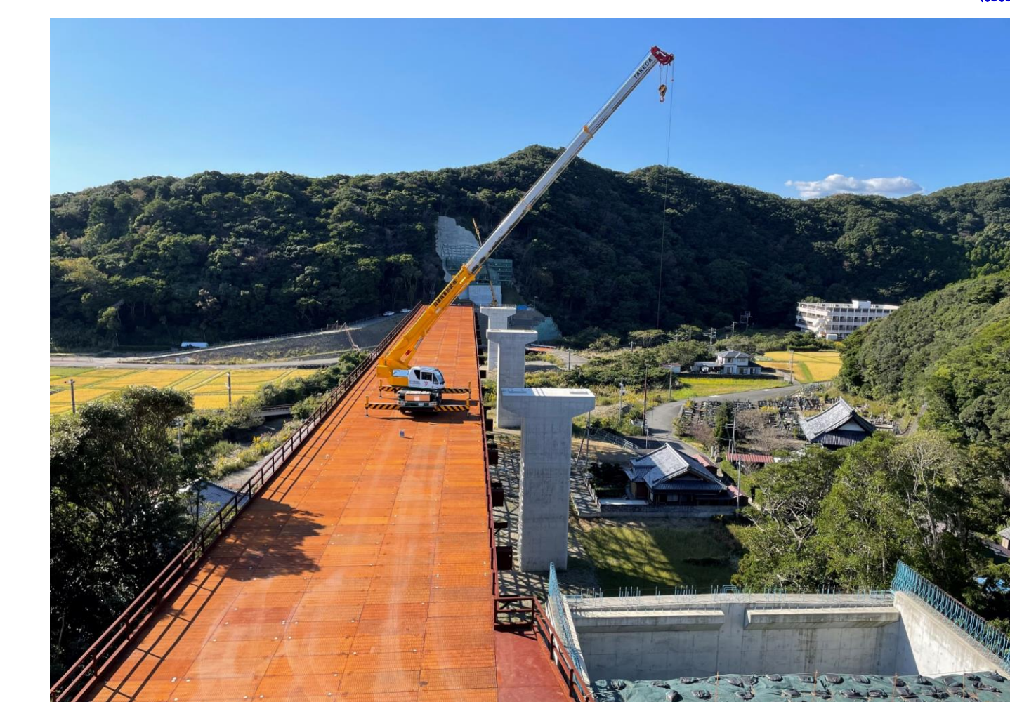
⑦ 串本町二色(二色川橋)
