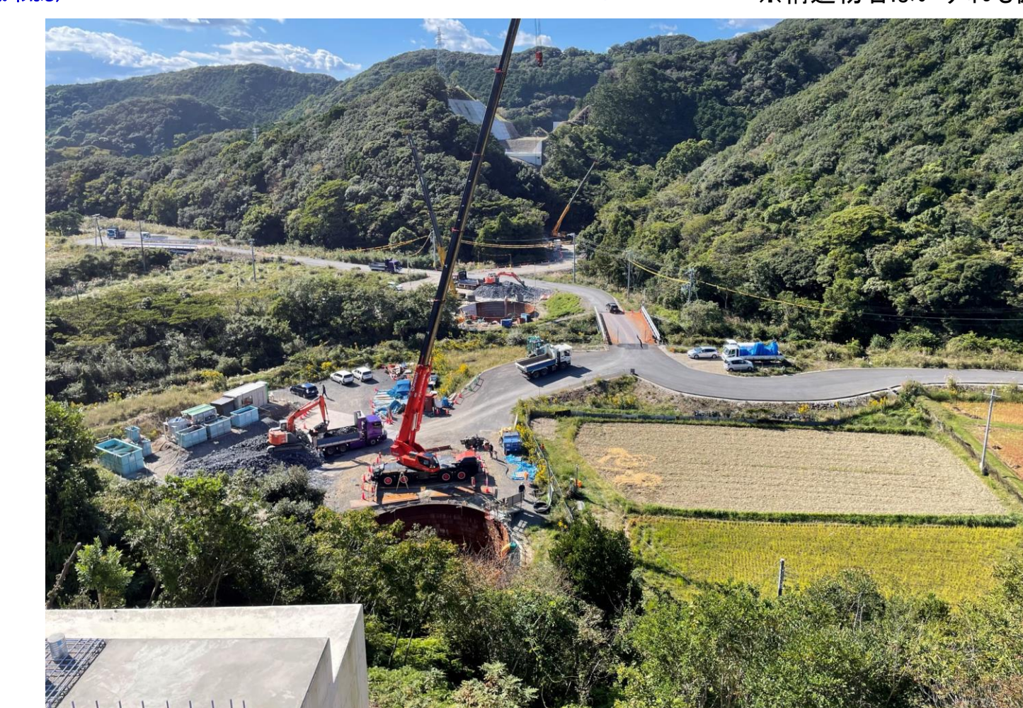
⑧ 串本町關野川(關野川橋)
