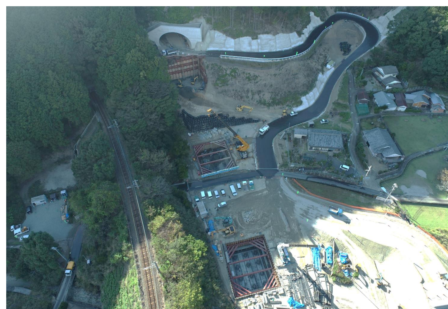
② すさみ町里野(里野西池川橋)
