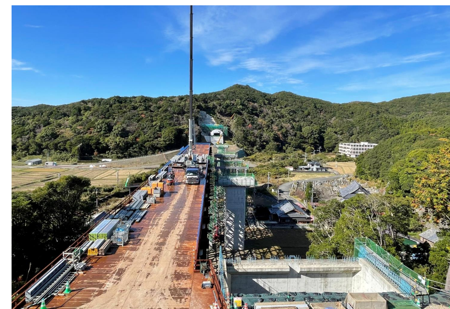
⑦ 串本町二色(二色川橋)
