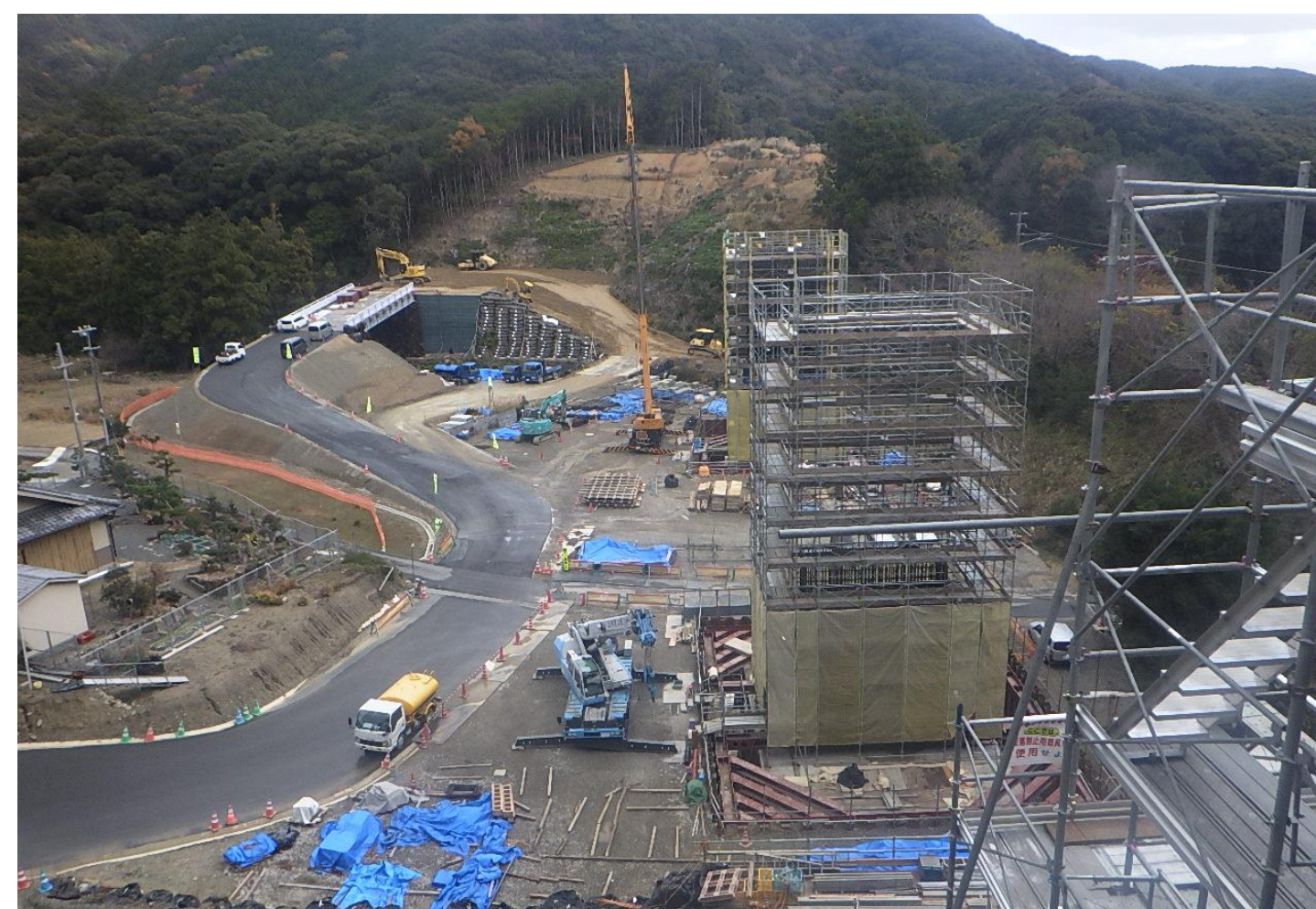
② すさみ町里野(里野西池川橋)
