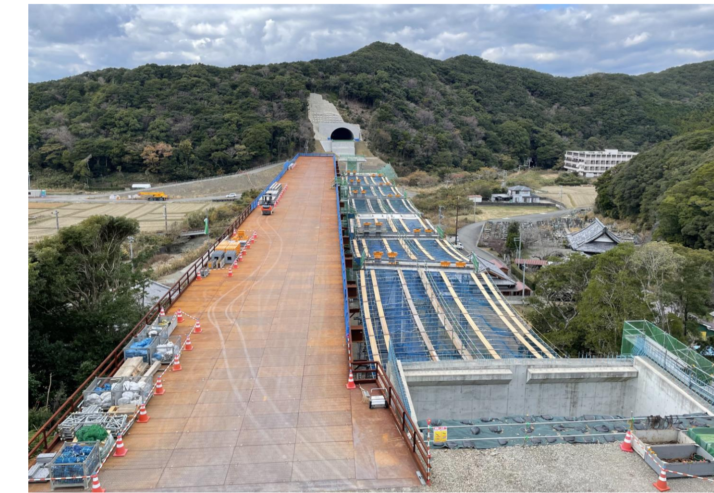
⑦ 串本町二色(二色川橋)
