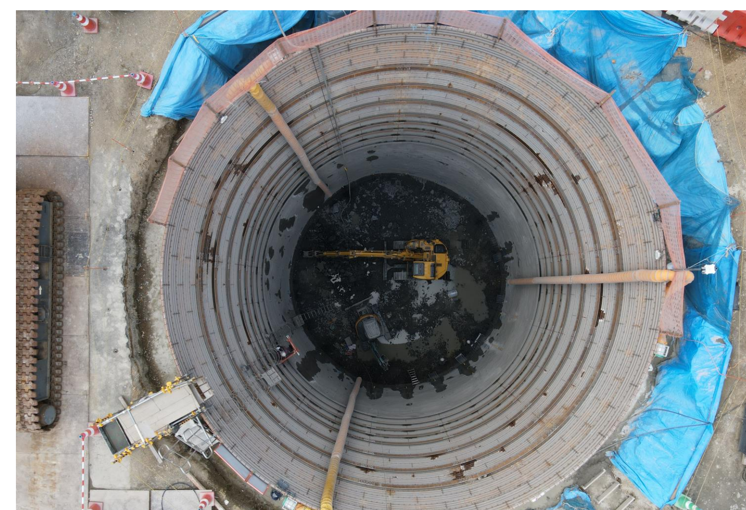
⑤ 串本町和深(熊谷川第二橋)
