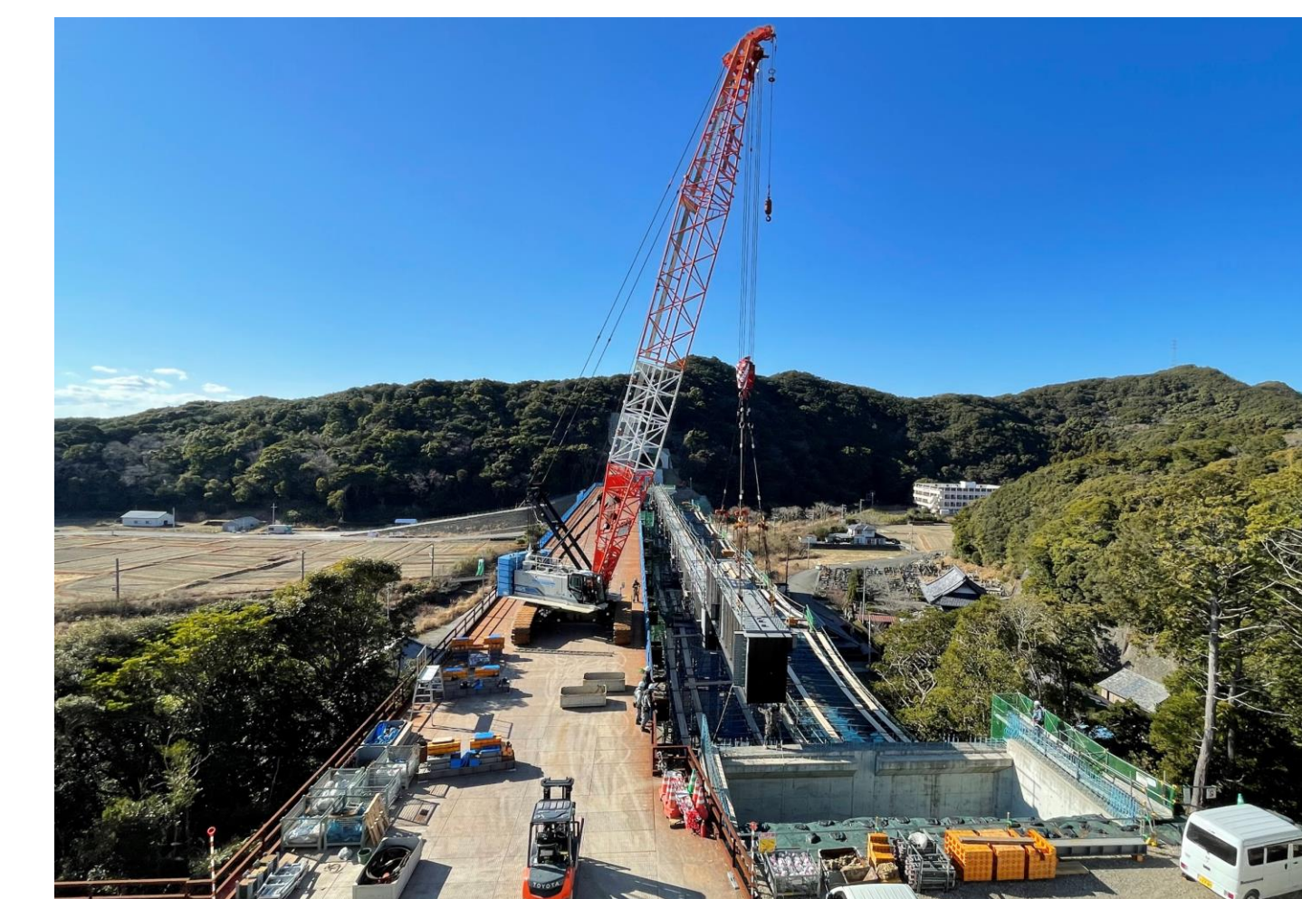
⑦ 串本町二色(二色川橋)
