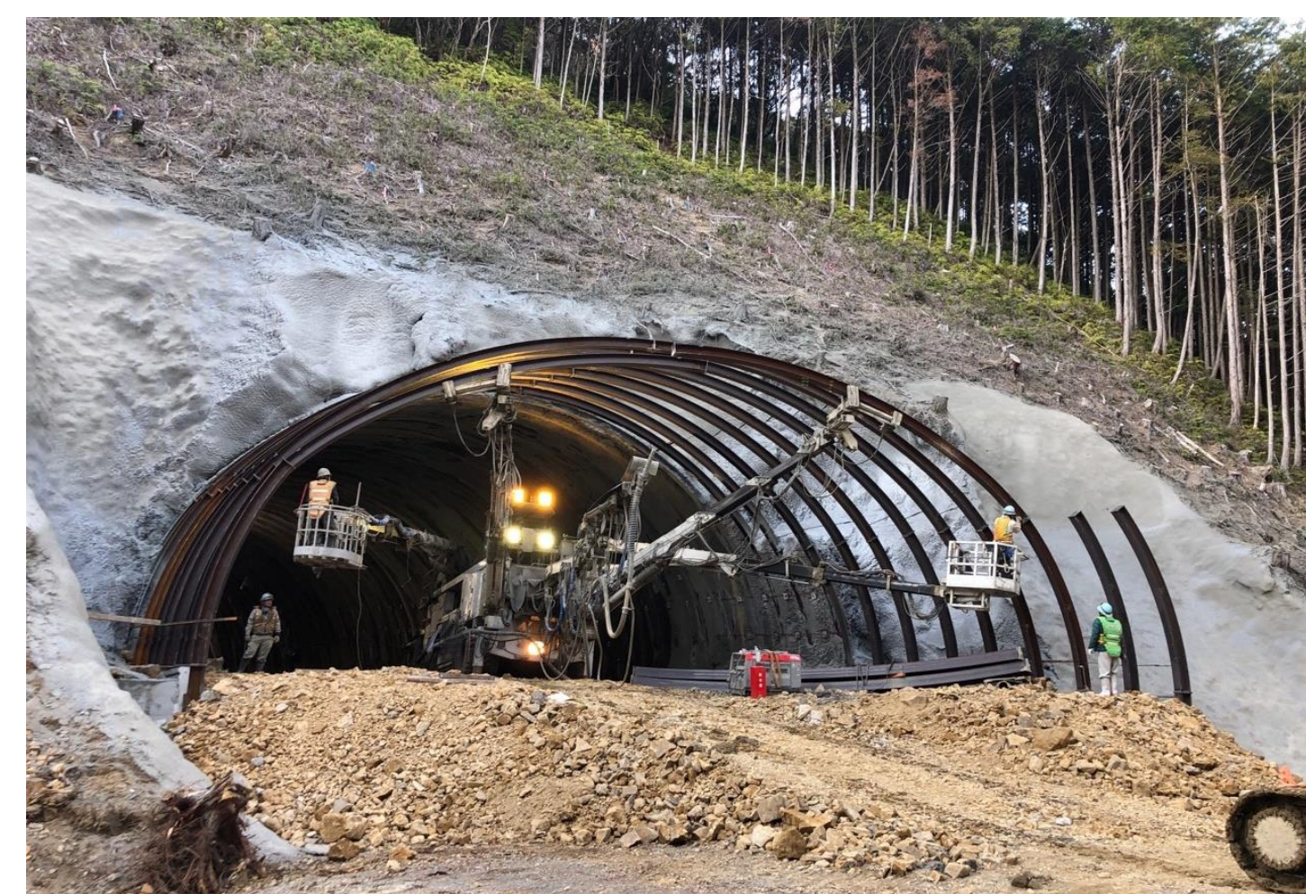
⑤ 串本町有田(有田上第一トンネル)
