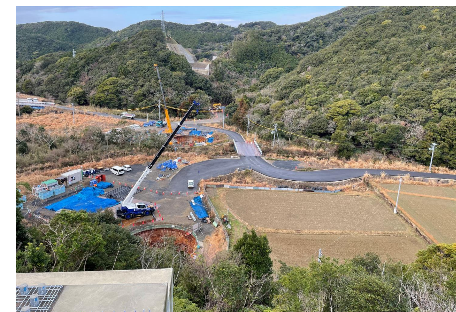
⑧ 串本町關野川(關野川橋)
