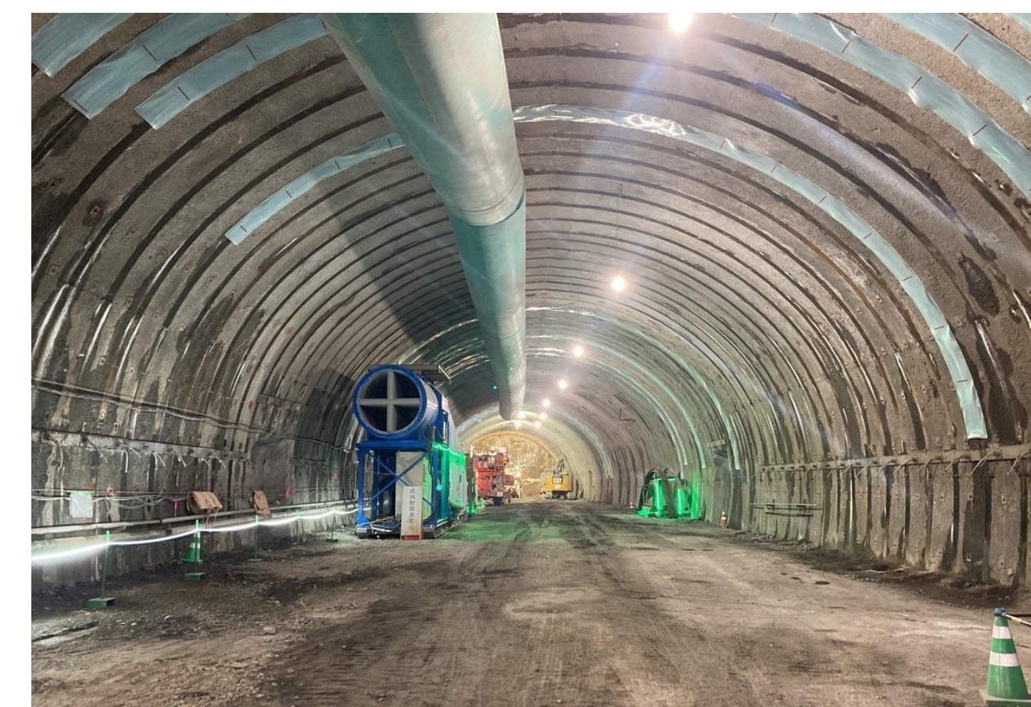
④ 串本町田並(田並トンネル)
