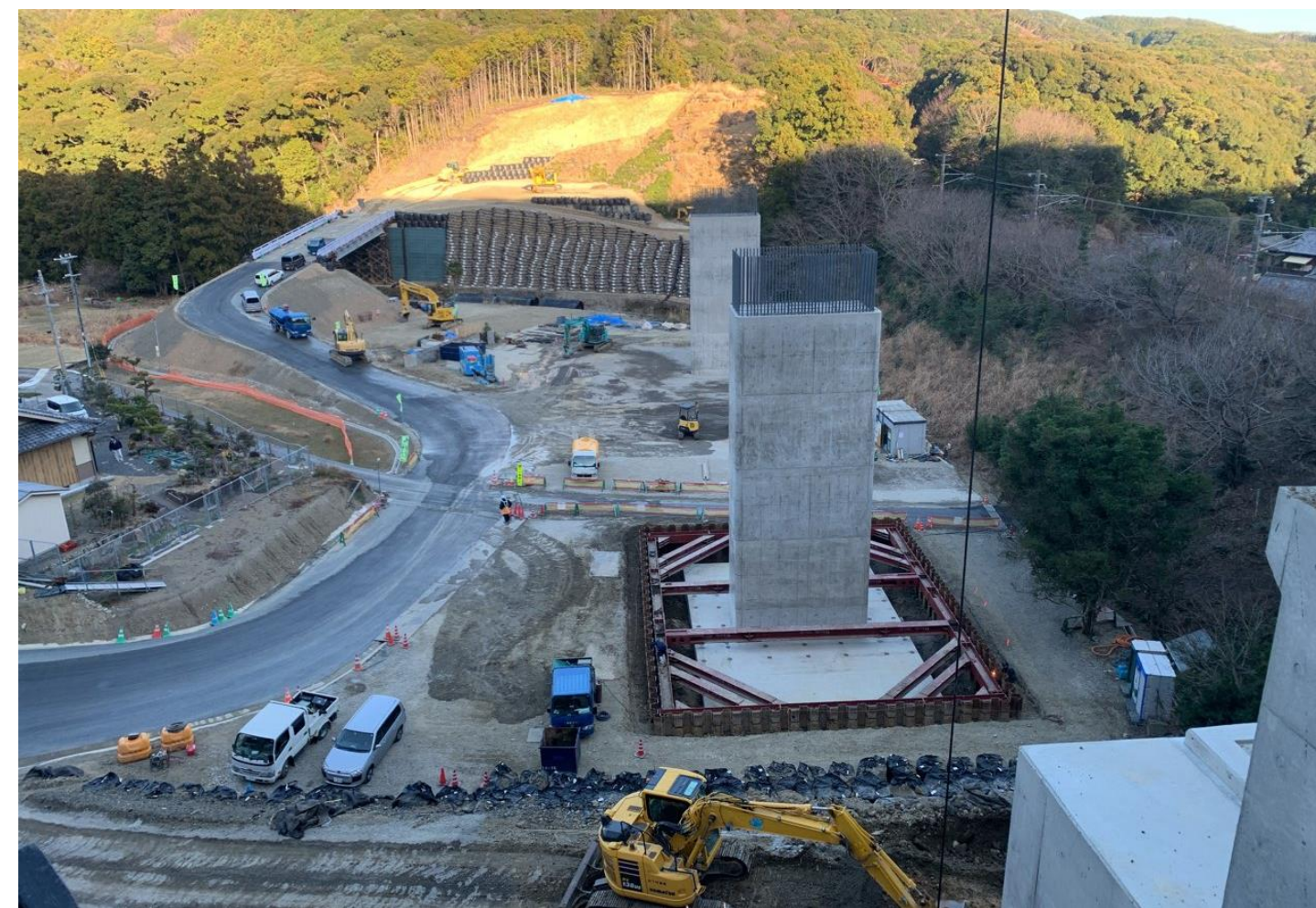
② すさみ町里野(里野西池川橋)
