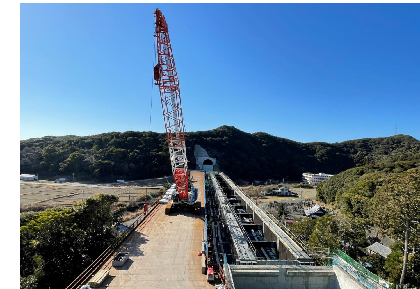
⑦ 串本町二色(二色川橋)
