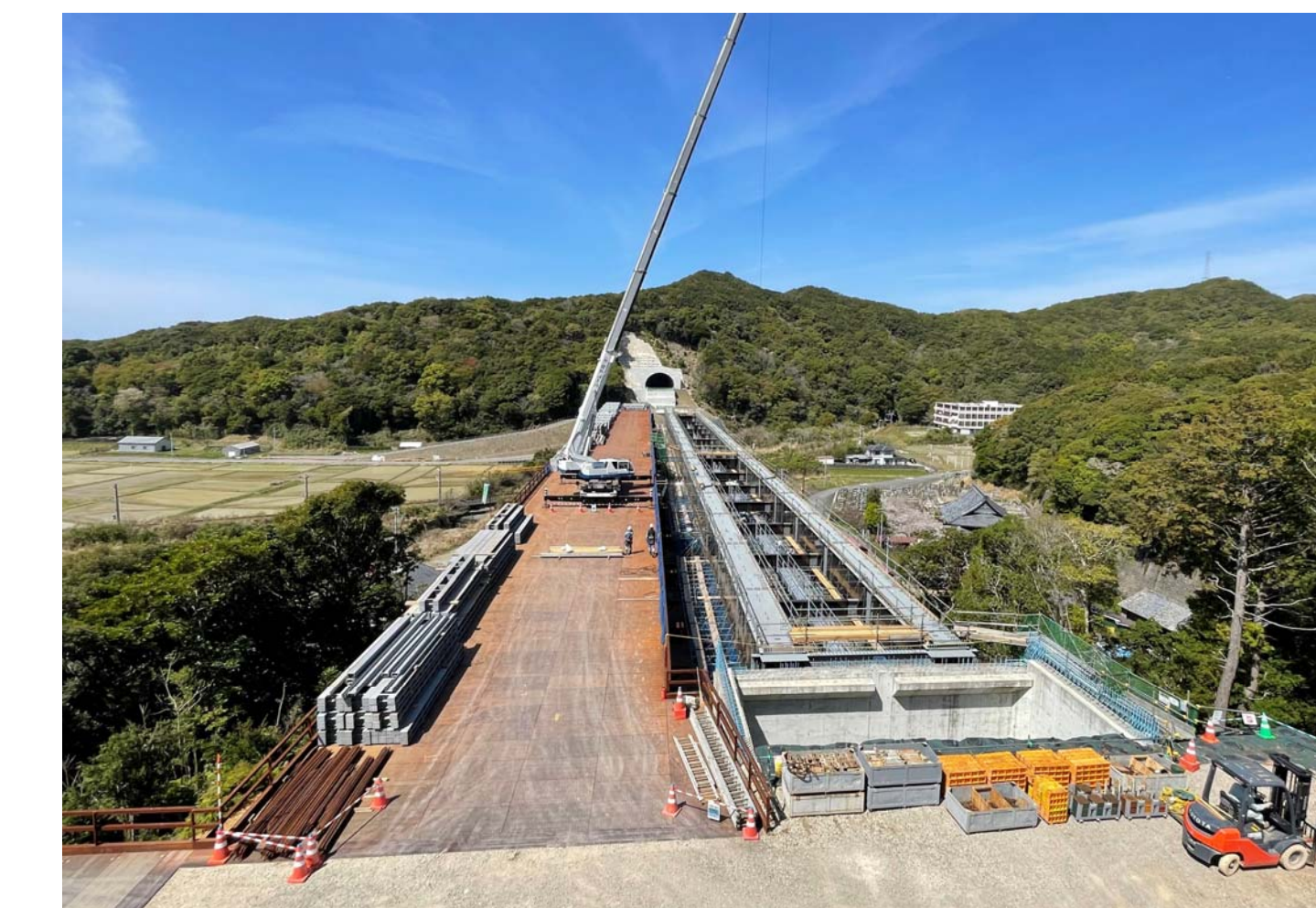
⑦ 串本町二色(二色川橋)
