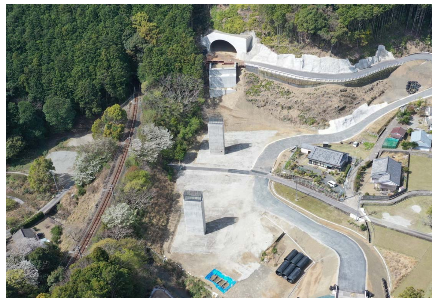
② すさみ町里野(里野西池川橋)
