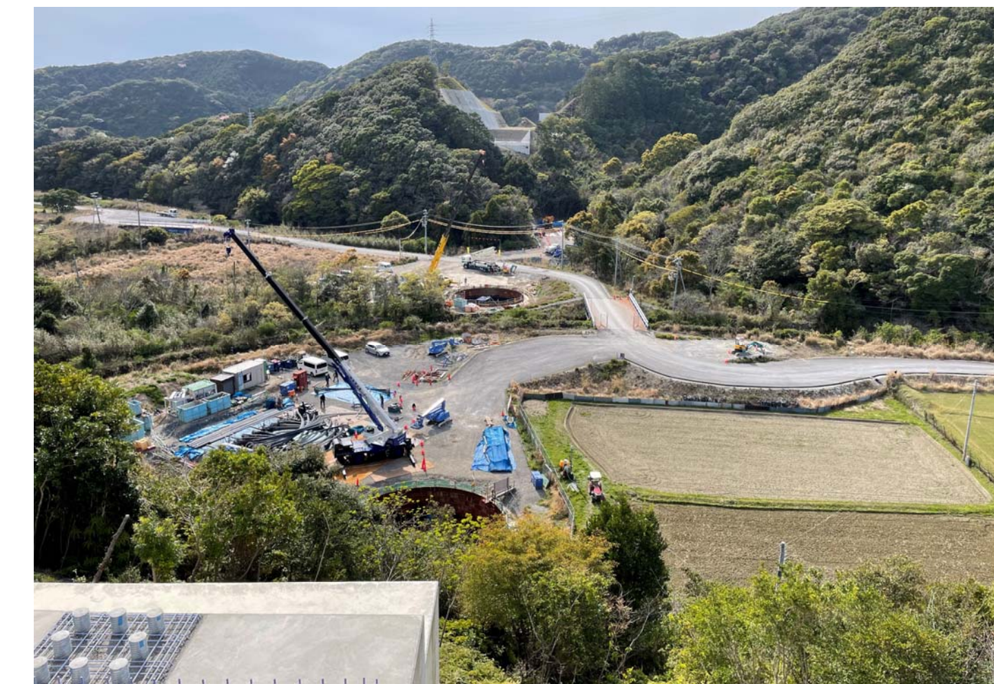
⑧ 串本町關野川(關野川橋)
