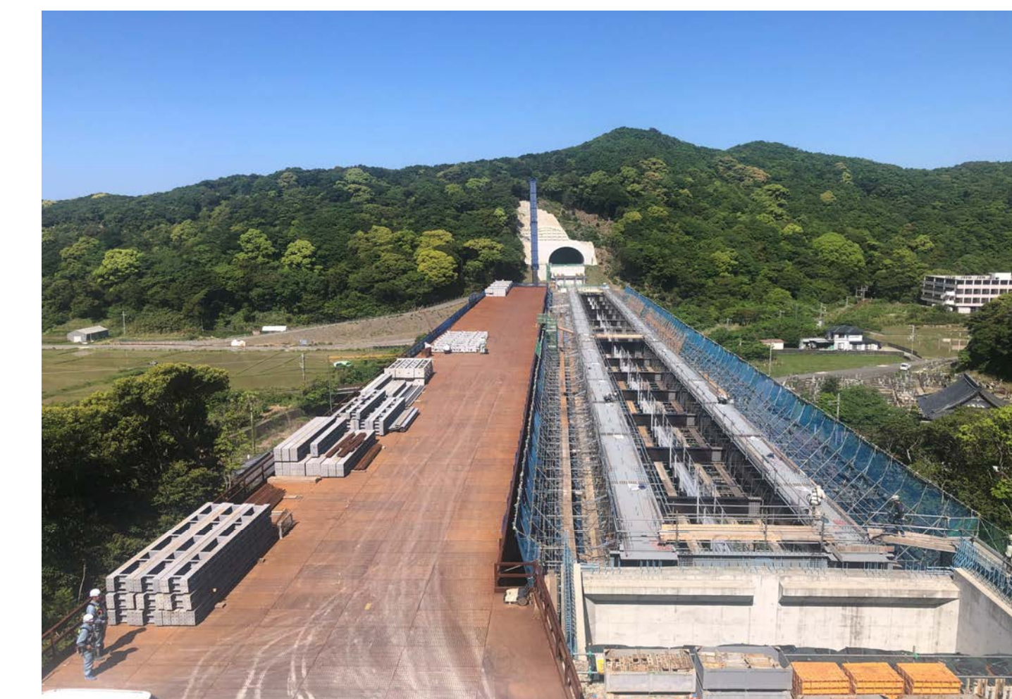
⑦ 串本町二色(二色川橋)
