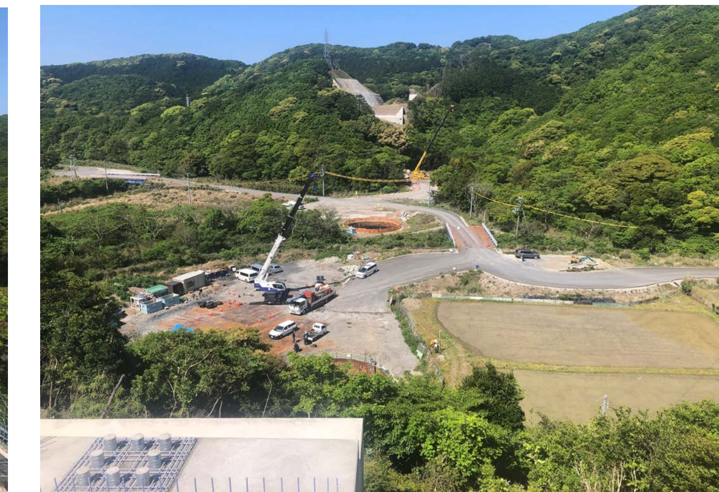
⑧ 串本町關野川(關野川橋)
