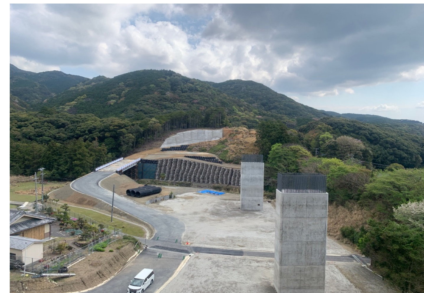
③ すさみ町里野(里野西池川橋)
