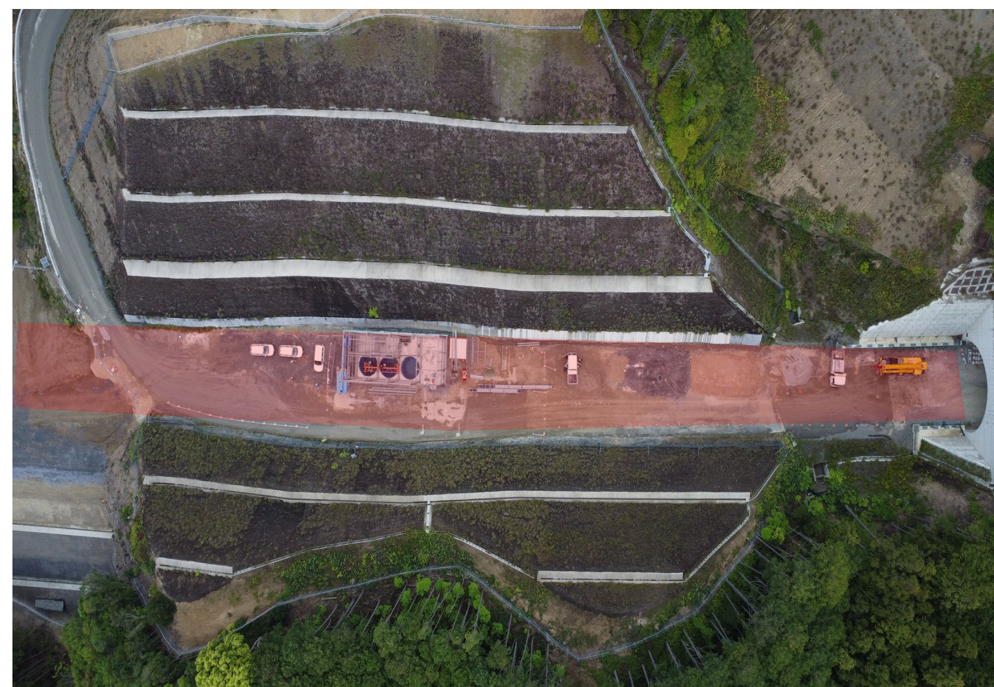
② すさみ町里野(道路改良)
