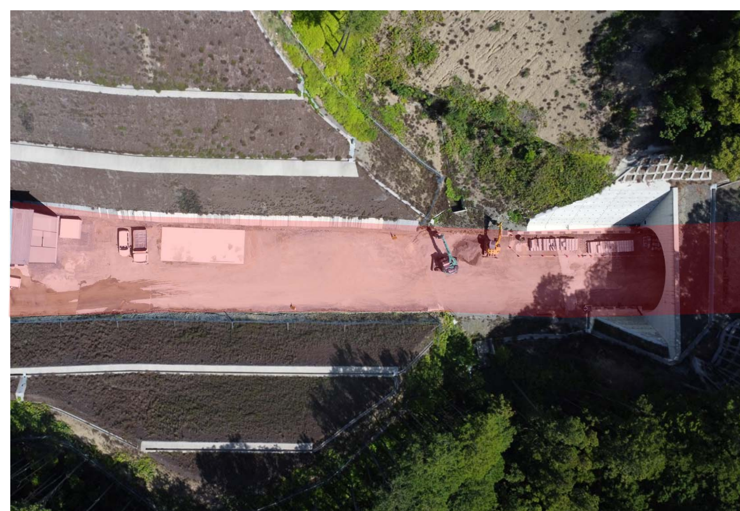
② すさみ町里野(道路改良)
