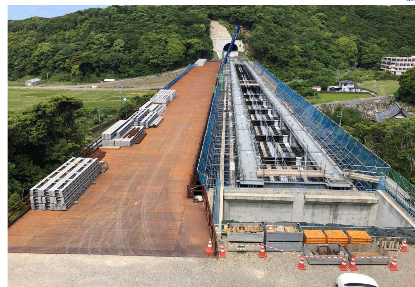
⑦ 串本町二色(二色川橋)
