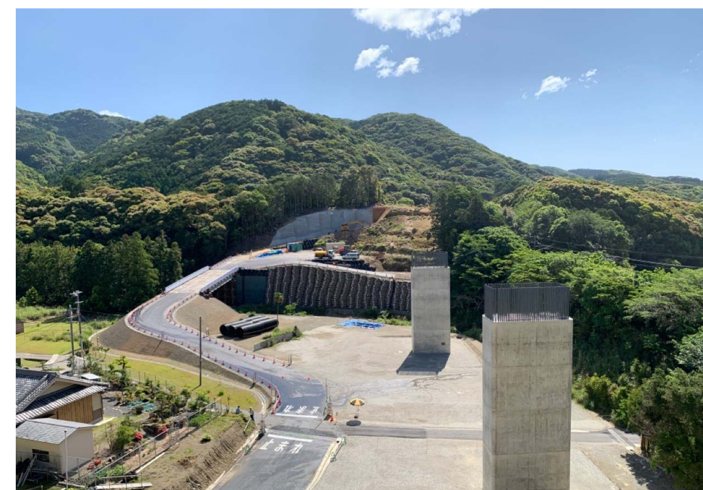
③ すさみ町里野(里野西池川橋)
