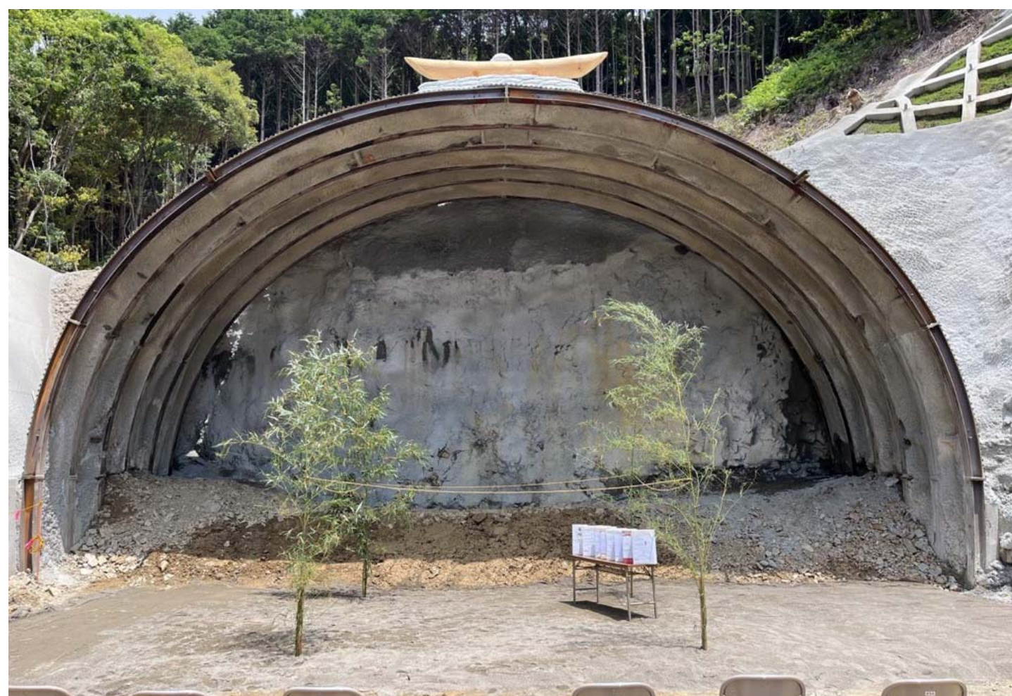
⑥ 串本町和深(和深西トンネル)
