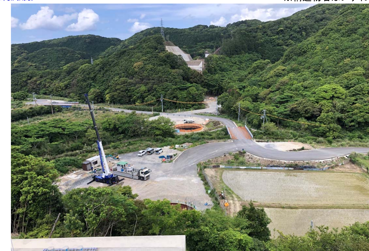
⑧ 串本町 鵜野川 ( 鵜野川橋 )
