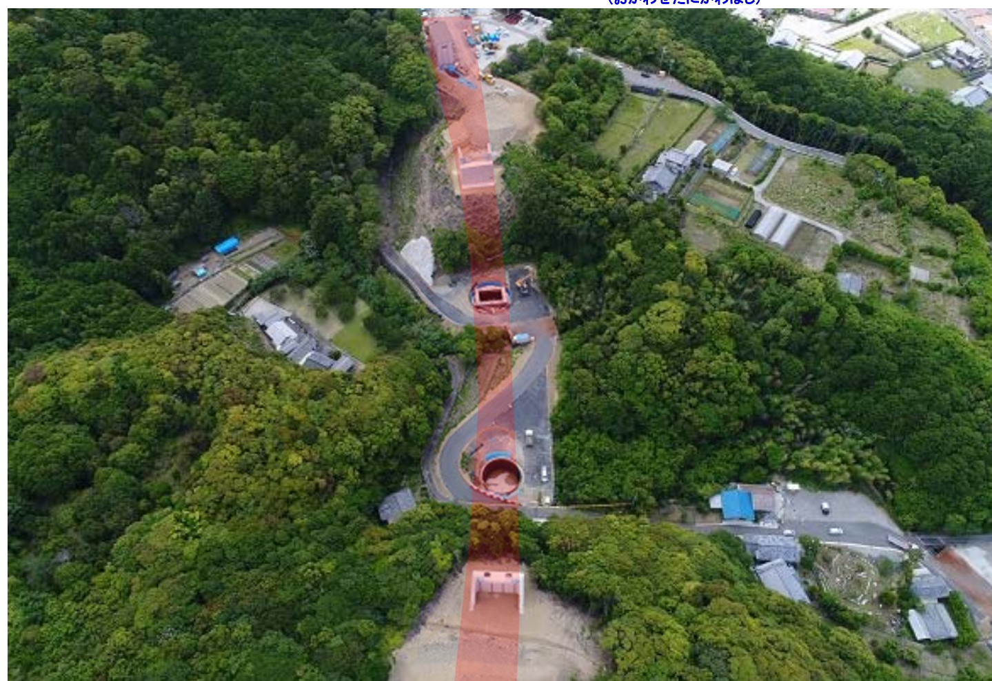
⑤ 串本町和深(熊谷川橋第二橋)
