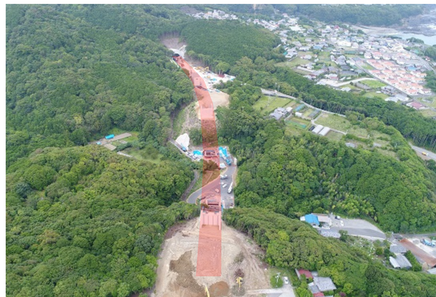
⑤ 串本町和深(熊谷川橋第二橋)
