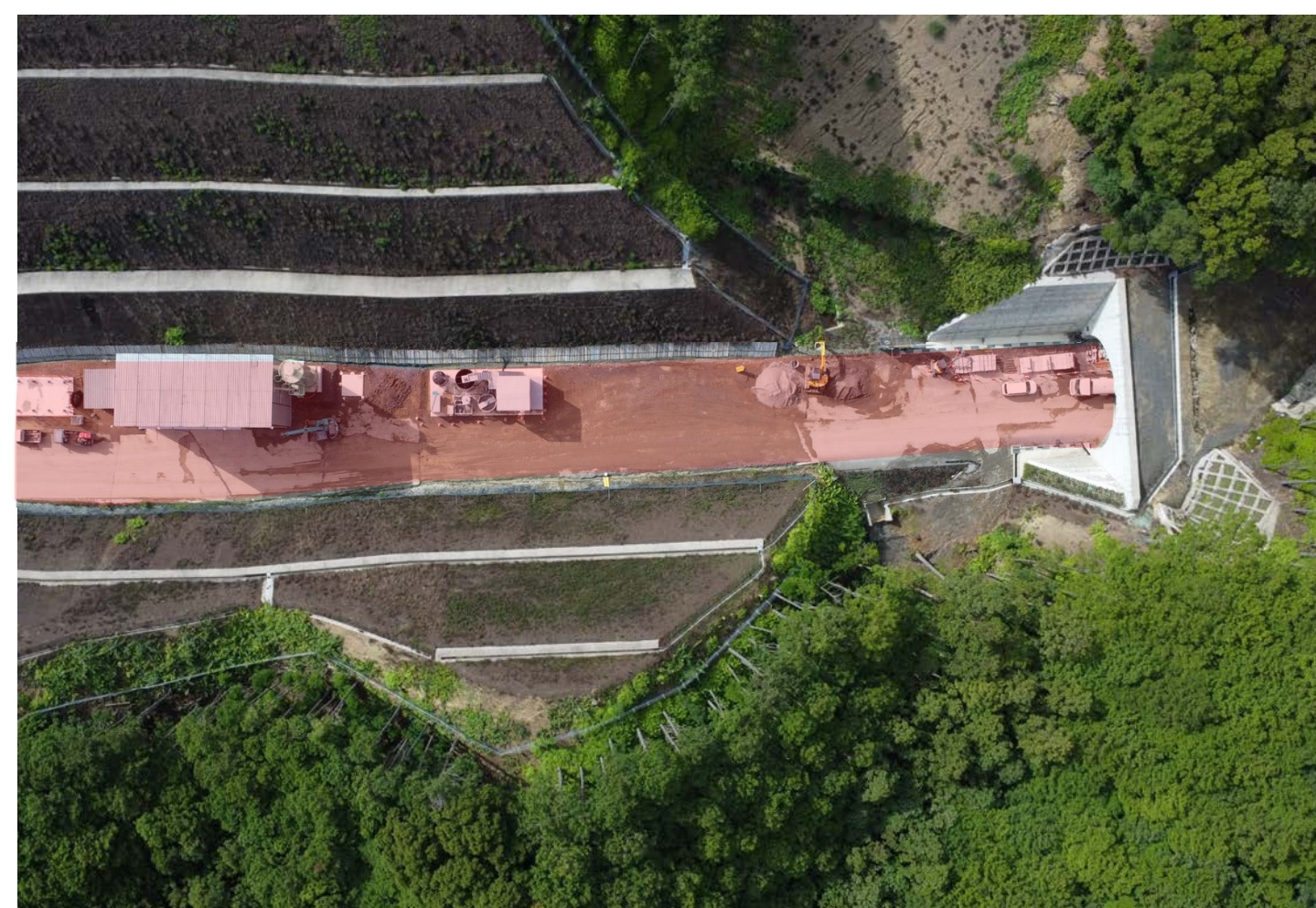
② すさみ町里野(道路改良)
