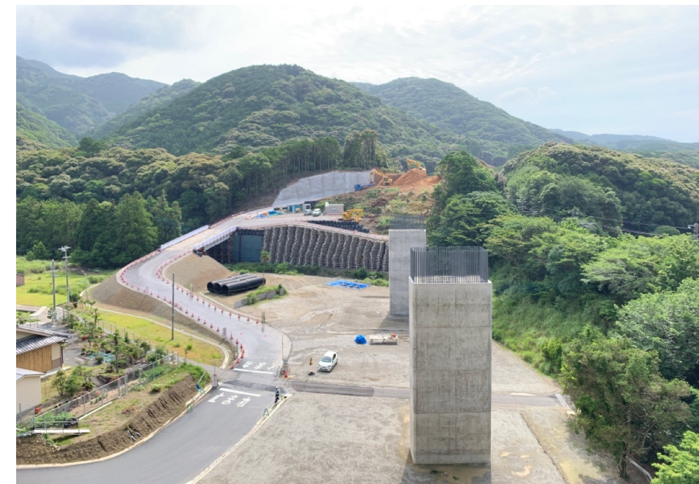
③ すさみ町里野(里野西池川橋)
