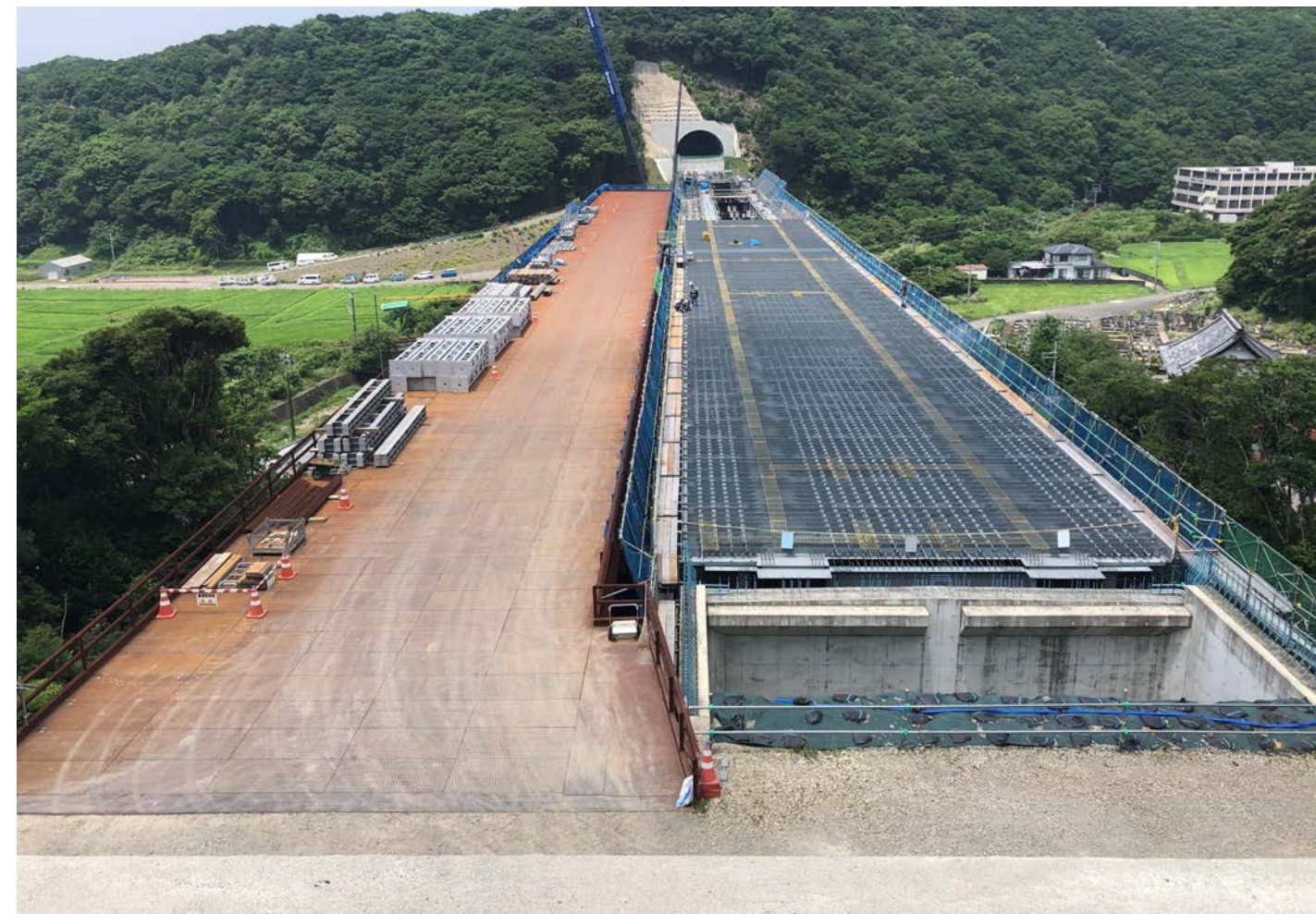
⑦ 串本町二色(二色川橋)
