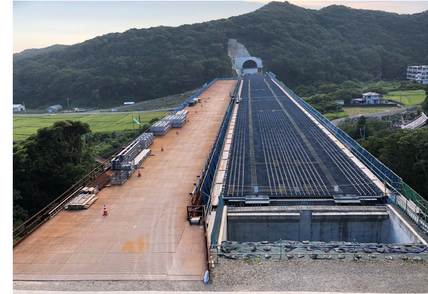
⑦ 串本町二色(二色川橋)
