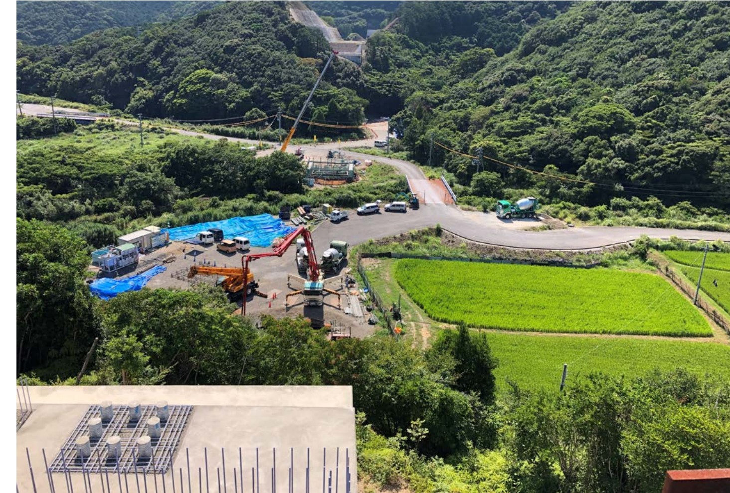
⑧ 串本町關野川(關野川橋)
