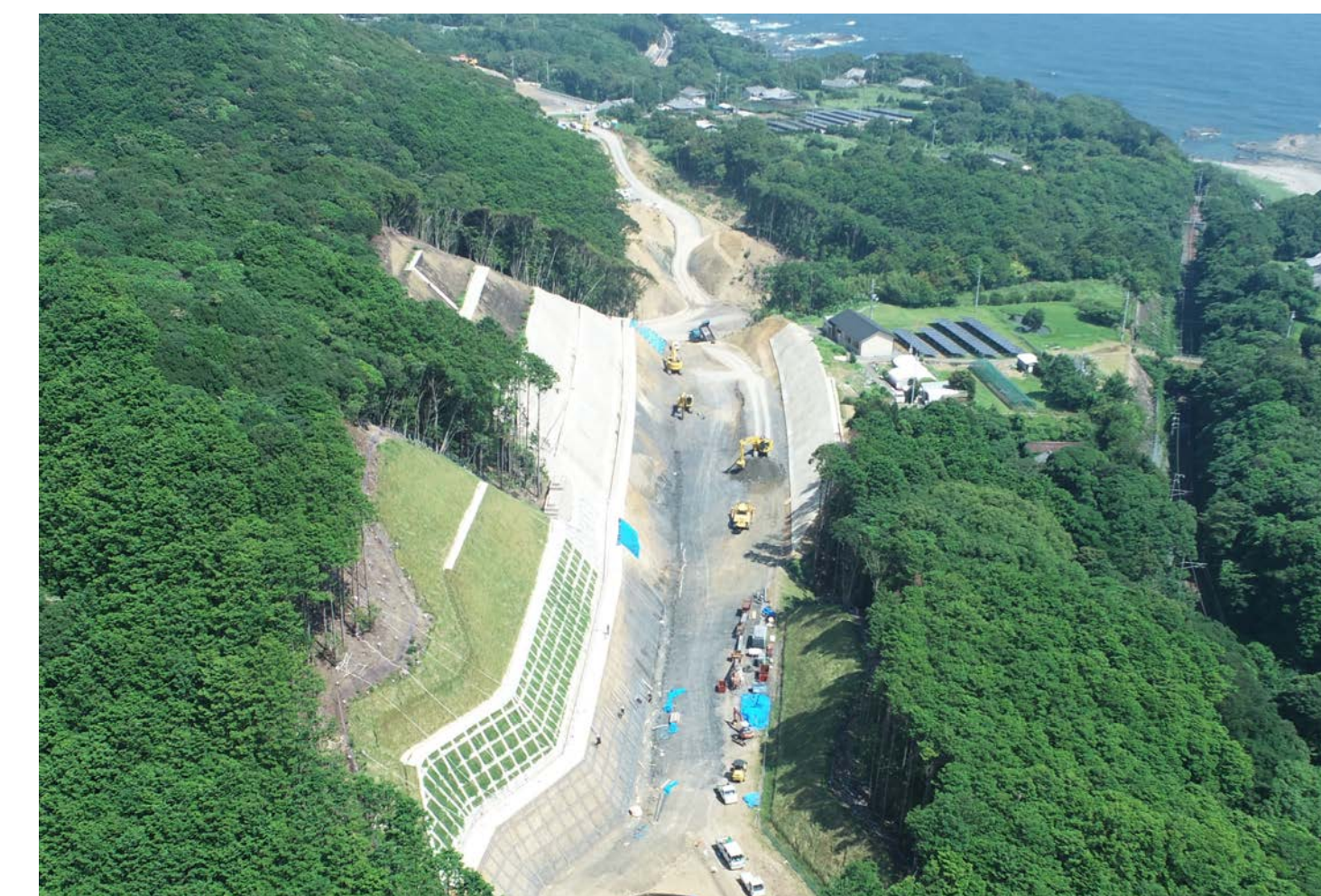
④ 串本町和深(道路改良)
