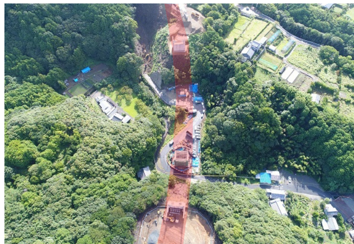
② 串本町和深(熊谷川橋第二橋)
