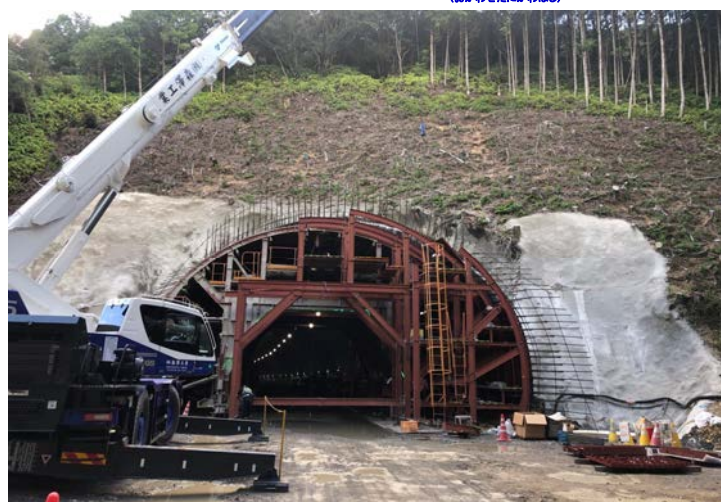
⑤ 串本町有田(有田上第一トンネル)
