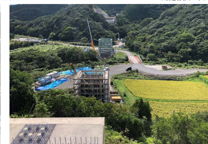
⑧ 串本町關野川(關野川橋)
