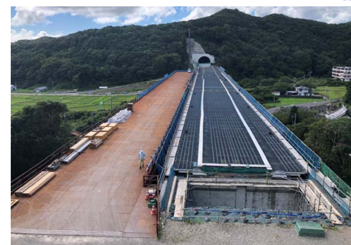
⑦ 串本町二色(二色川橋)
