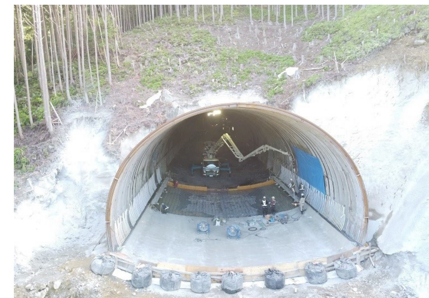
④ 串本町田並(田並トンネル)
