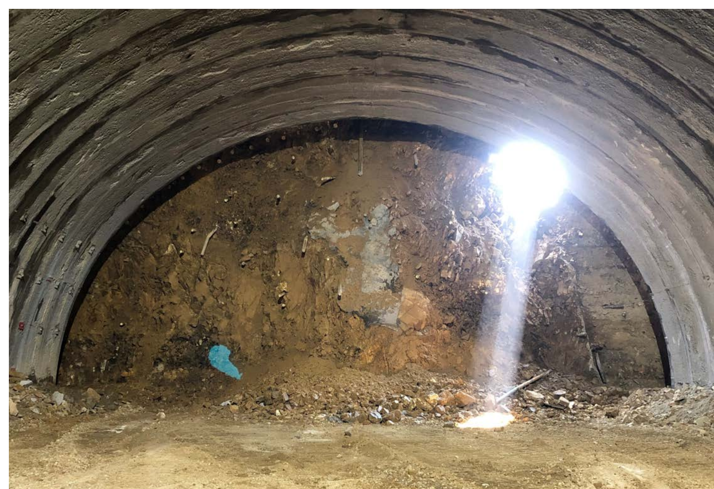
⑤ 串本町有田(有田上第二トンネル)
