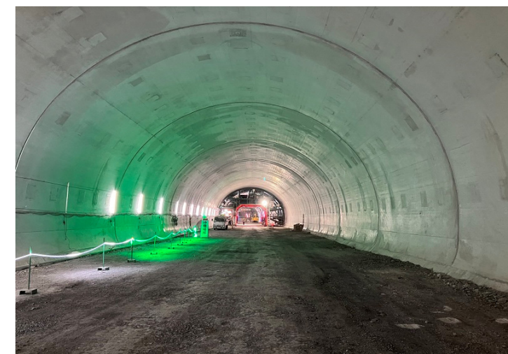
④ 串本町田並(田並トンネル)
