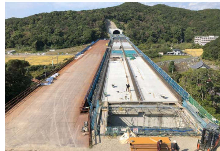
⑦ 串本町二色(二色川橋)
