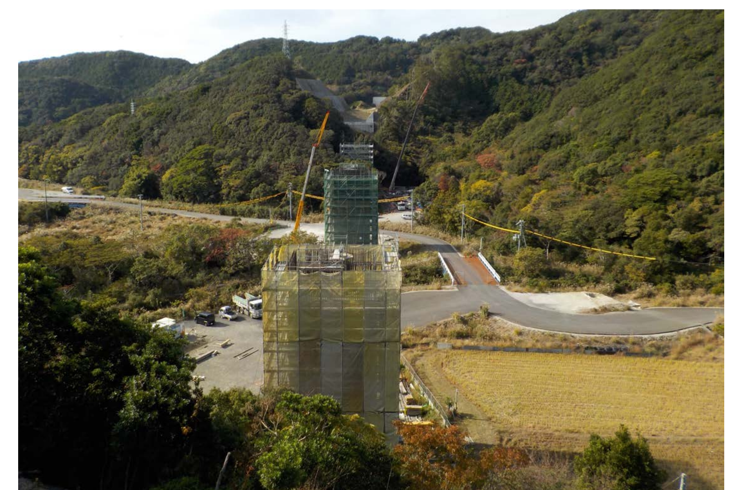
⑧ 串本町關野川(關野川橋)
