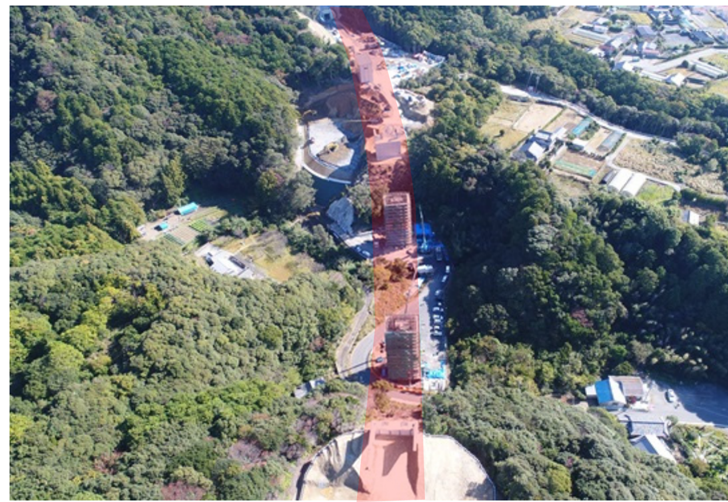
② 串本町和深(熊谷川橋第二橋)
