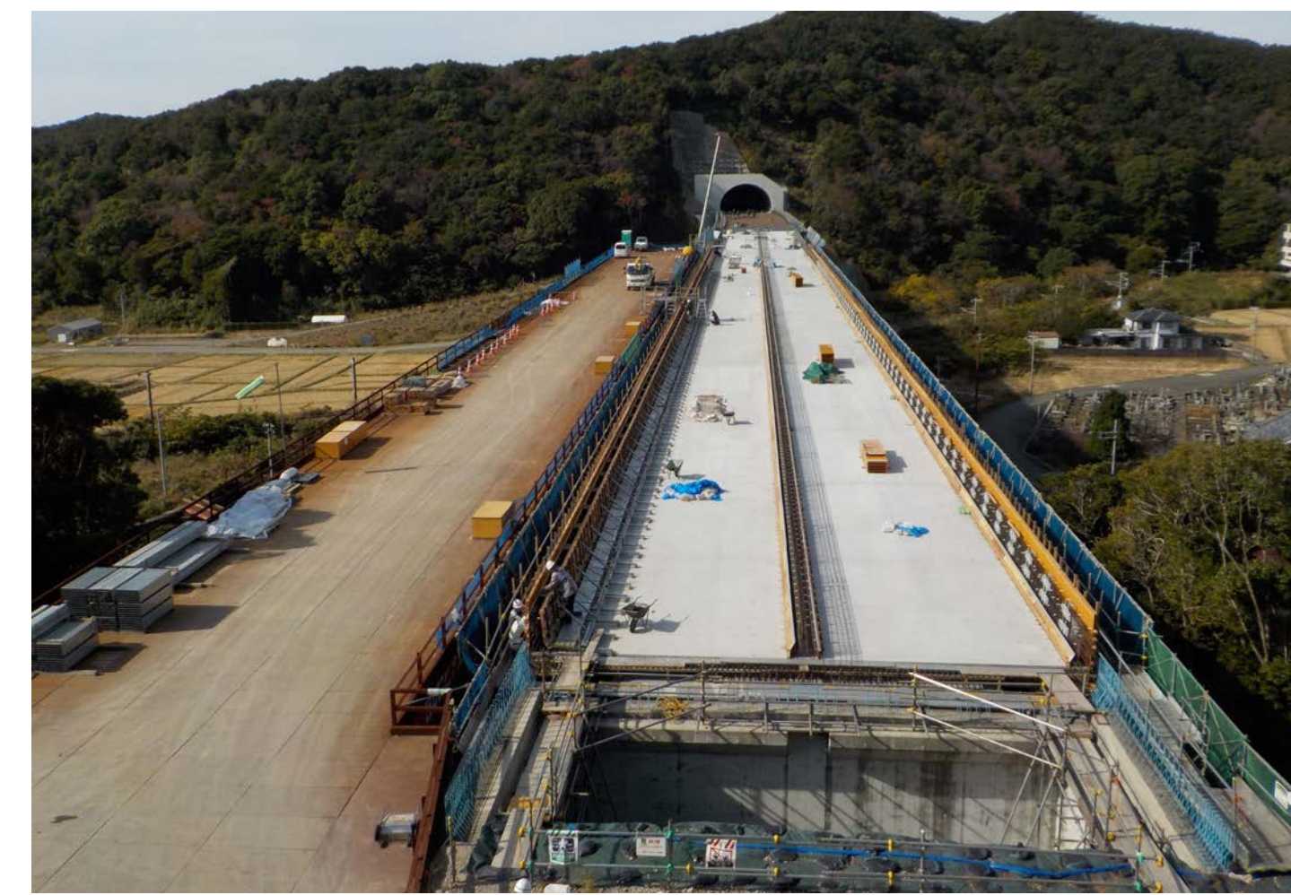
⑦ 串本町二色(二色川橋)
