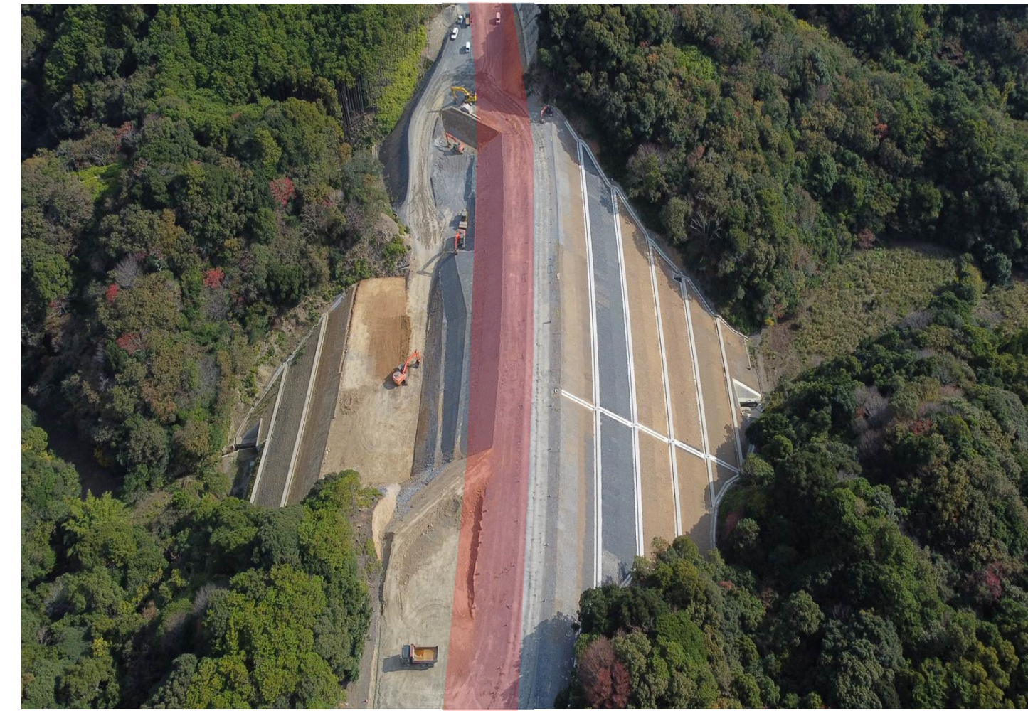
③ 串本町江田(道路改良)
