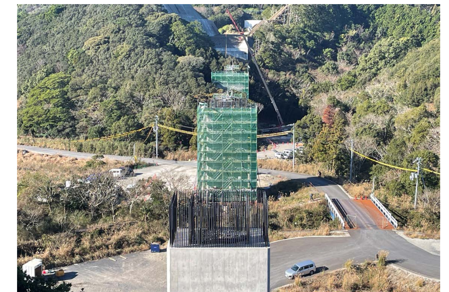
⑧ 串本町鵜野川(鵜野川橋)
