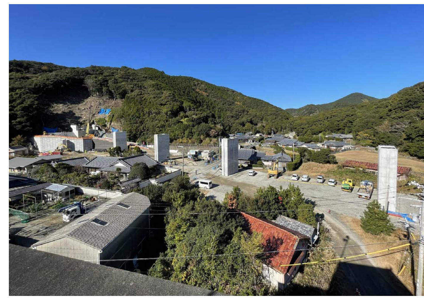
③ 串本町和深(和深川橋)
