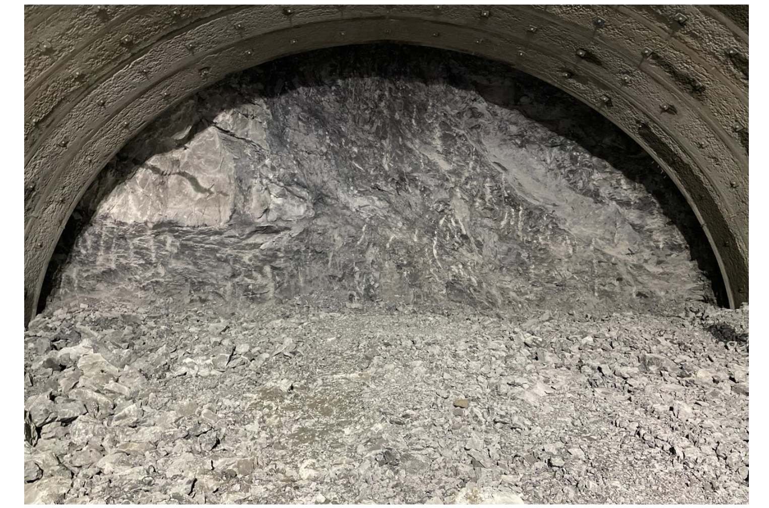
④ 串本町和深(東地トンネル)
