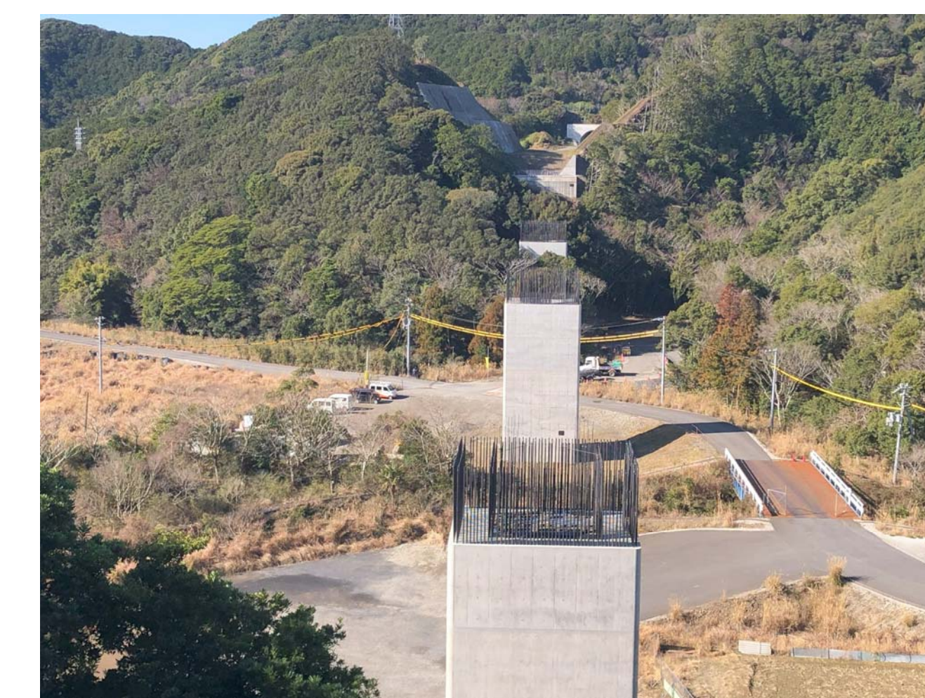
⑧ 串本町關野川(關野川橋)
