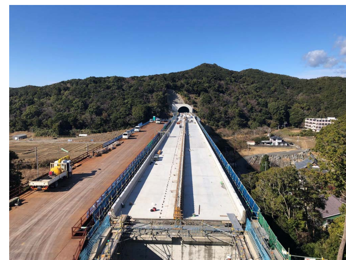
⑦ 串本町二色(二色川橋)
